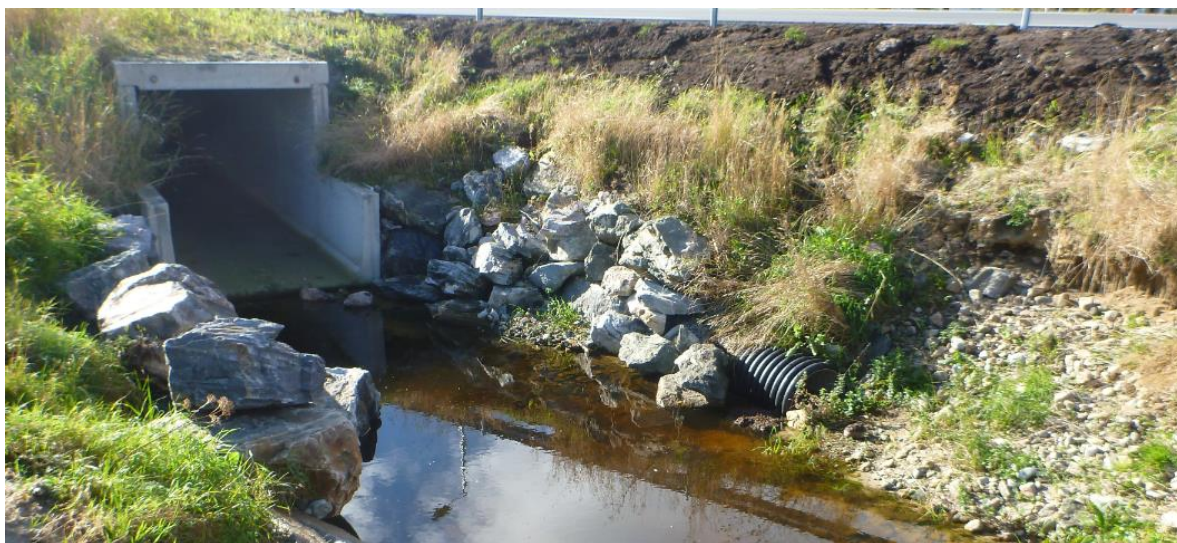
Figur 110. Nyanlagt veikulvert under Fv 714.
