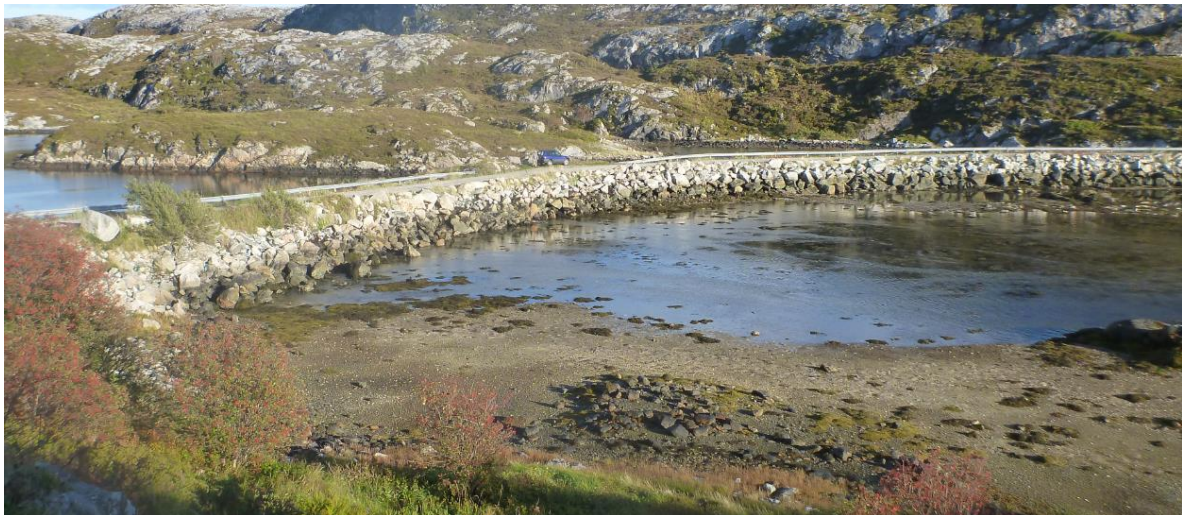
Figur 53. Veiforbygning og kommunal vei anlagt på tvers av indre Veisfjorden.
