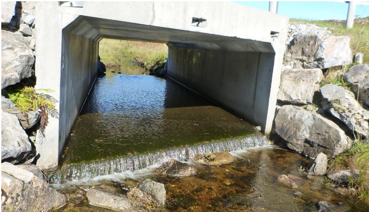
Figur 30. Kulvert av relativt ny dato er anlagt under Fv 716. Denne ivaretar fiskevandring på en dårlig måte. Foto ved normal vannføring.
