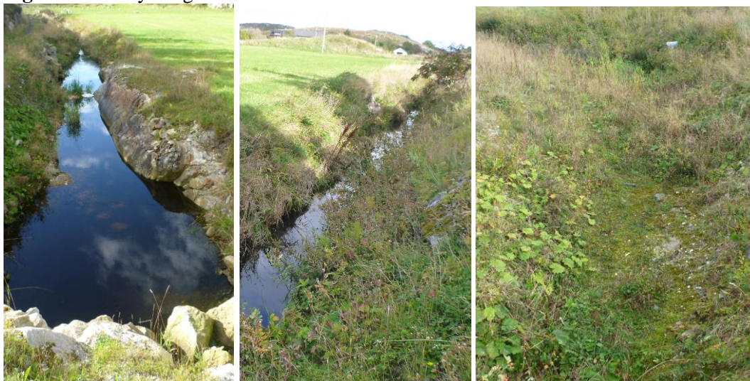
Figur 98. Utgrøftet, utrettet og utgrunnet tilløpsbekk til Littljønna nedstrøms Fv 716 (t.v. og midten), og parti lagt i bakken ovenfor Fv 716 (t.h.).
