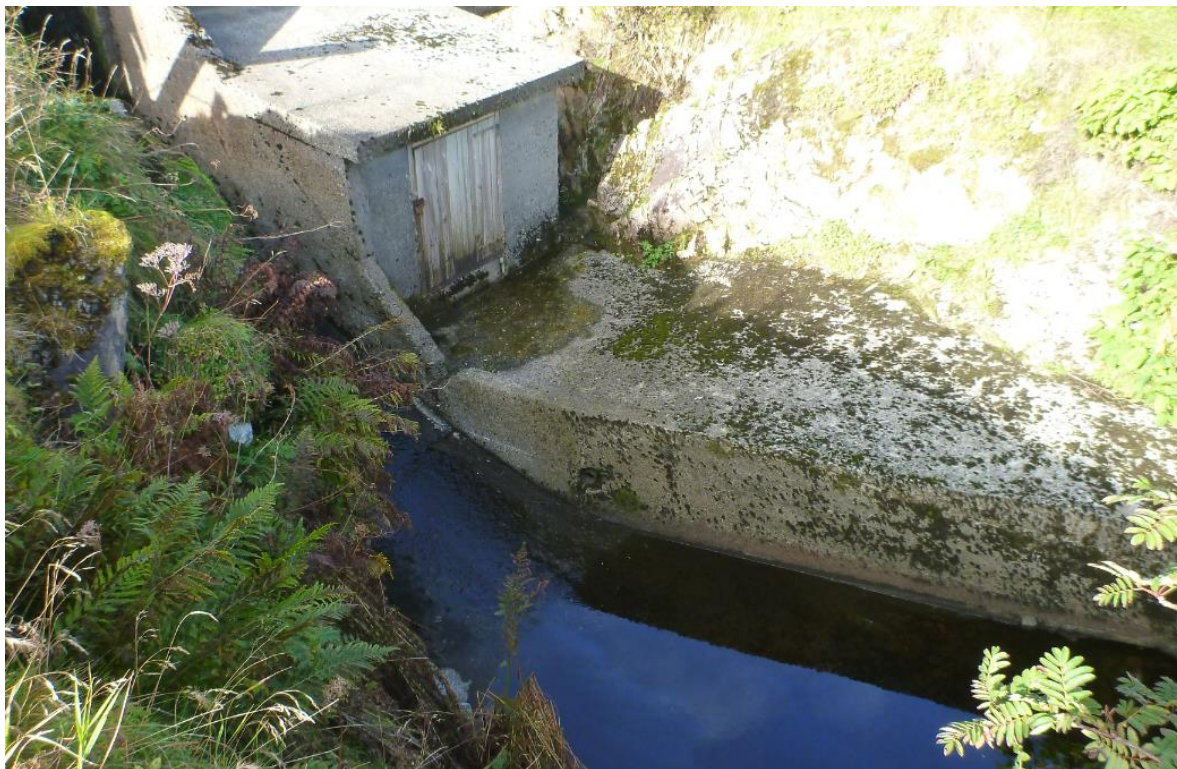
Figur 108. Ingen vannføring i Ervikelva ved normale avrenningsforhold, kun lekkasjer fra demningen opprettholder stående vann i kulper.
