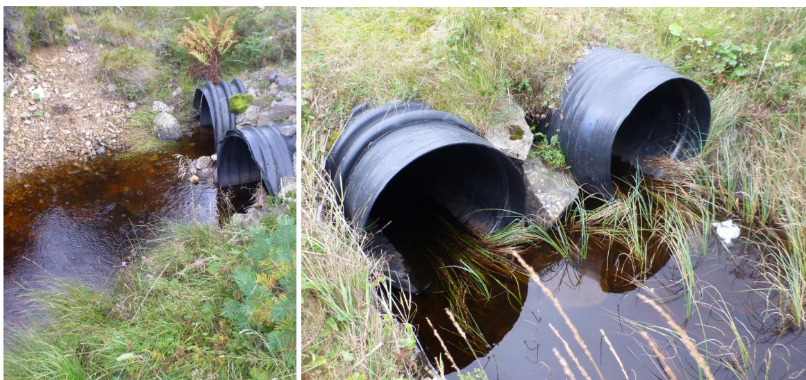
Figur 19. Veikrysning utført med to senkede plastrør med stor diameter.
