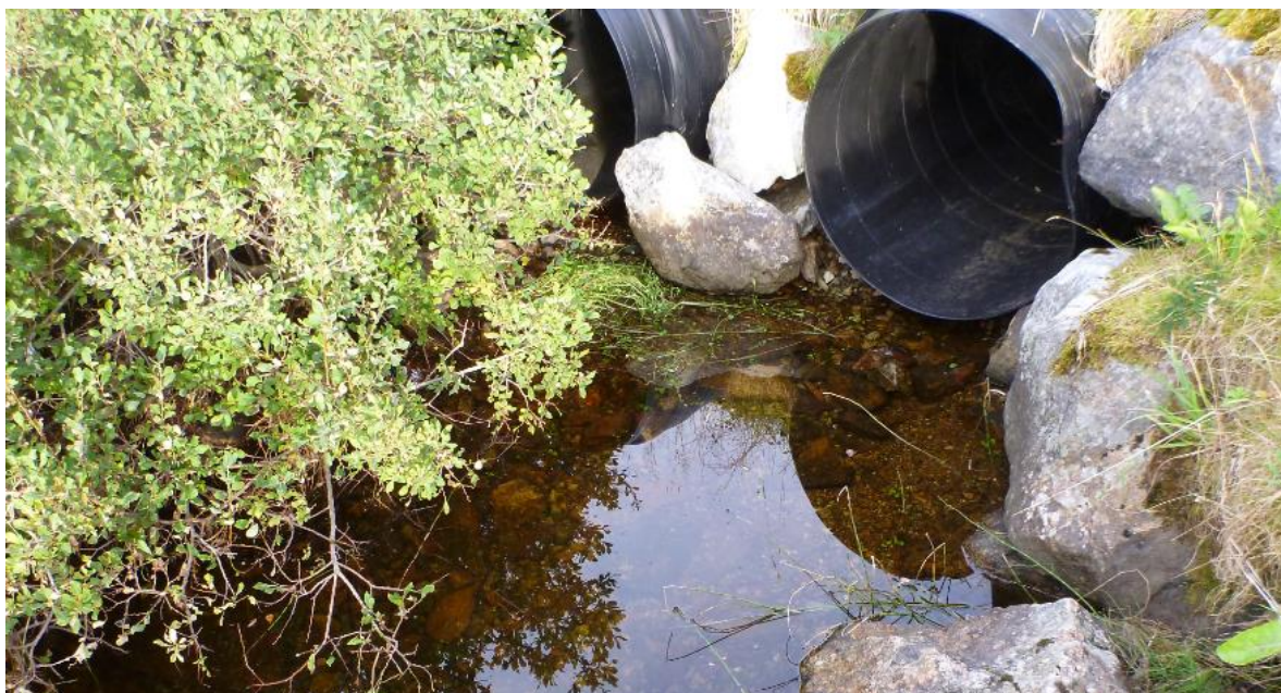
Figur 90. Kulvertkrysning under Fv 716 i utløpsbekken fra Tuvnesvatnet.
