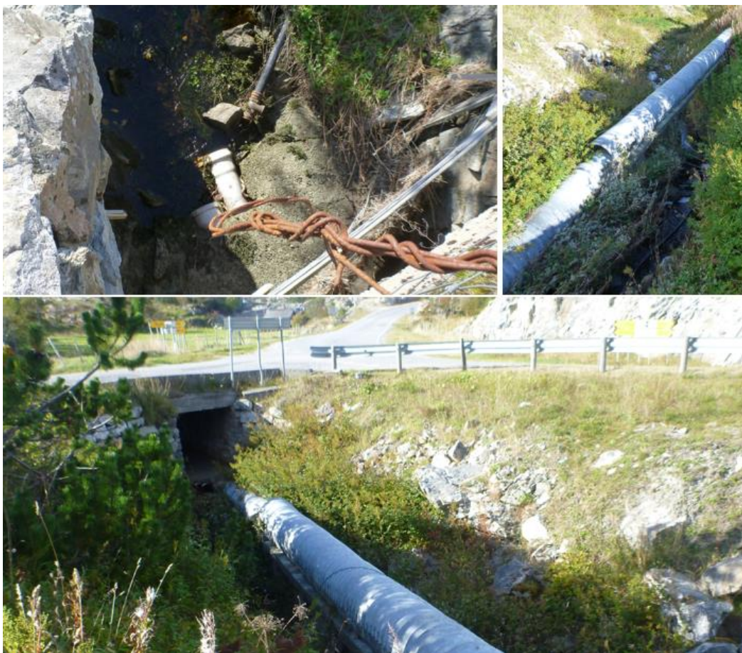
Figur 38. Krysning under Fv 411 og gammelt vanninntak i Hallarelda.
