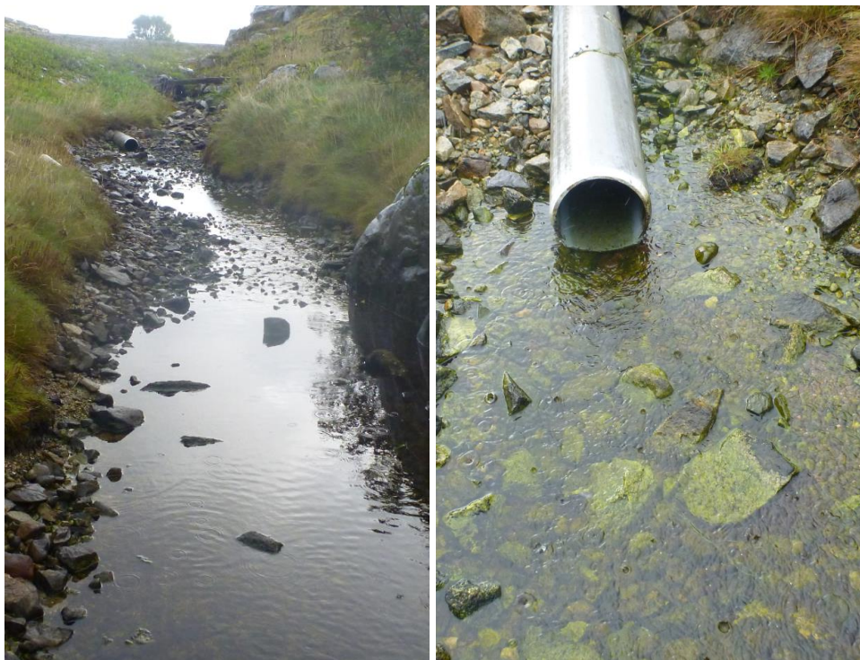
Figur 62. Kulvert under Fv 410 er ivaretar ikke fiskevandring for sjøørret.
