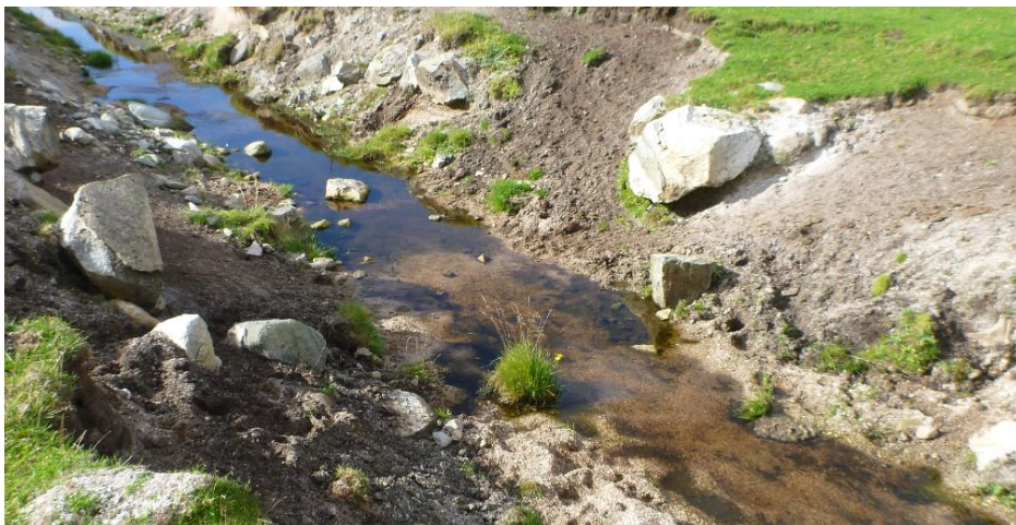
Figur 99. Endret, utgravd bekkeløp nedstrøms Fv 716.
