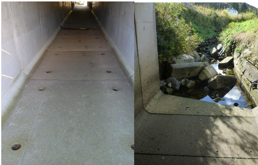
Figur 111. Kulvert under Fv 714 er anlagt med flat betongbunn, der vannet går under kulverten ved lave vannføringer.
