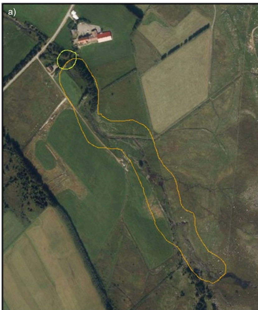
Foto 7.1. Områder der det er et spesielt behov for å sette opp gjerder for å avgrense tilgangen til Ualandsåna og kjørespor over elven samt vandringshinder som trenger utbedring. Oransje strek omslutter de aktuelle områdene for avgjerding, rød strek omslutter kjøresporet der det bør lages bro eller kulvert og gul strek omslutter vandringshinderet som bør utbedres. a) Området mellom Ualandsvegen og kulpen ved Kråkura. b) Området ovenfor Myrane. I dette området har nedre del, fra kjøresporet og nedover, høyest prioritet. Flyfotoet er hentet fra Norge i bilder (2023).
