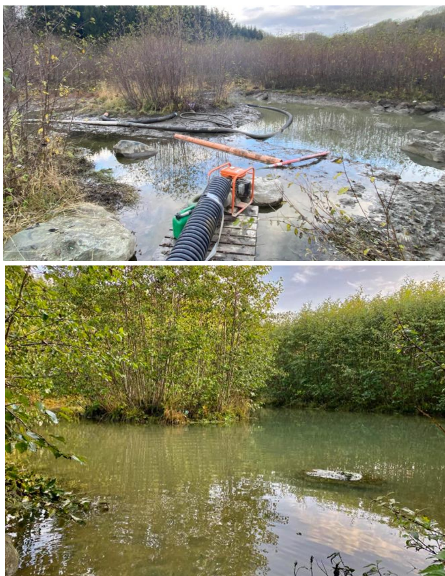
Figur 20. Fangdam i Heggstadbekken i 2021, i forbindelse med slamsuging (øverst). Foto tatt på samme sted i 2023 (nederst). Foto: ©Morten A. Bergan
