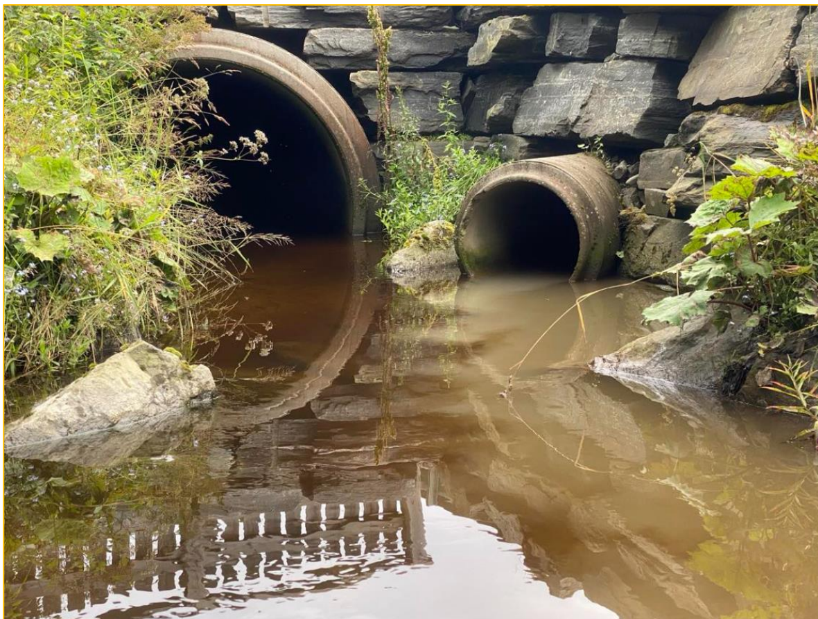
Foto: Partikkelforensing og nedslamming av vannmiljøet utgjør en stor risiko for økologisk tilstand for små vassdrag i Trondheim kommune. Årsakene knyttes ofte til menneskelige aktiviteter i nedbørfeltet. Bildet er fra ett av mange punktutslipp av partikkelforensning til sjøretvassdraget Søra fra Nordmyra/Søbstadmyra. Foto: @Morten André Bergan/NINA
