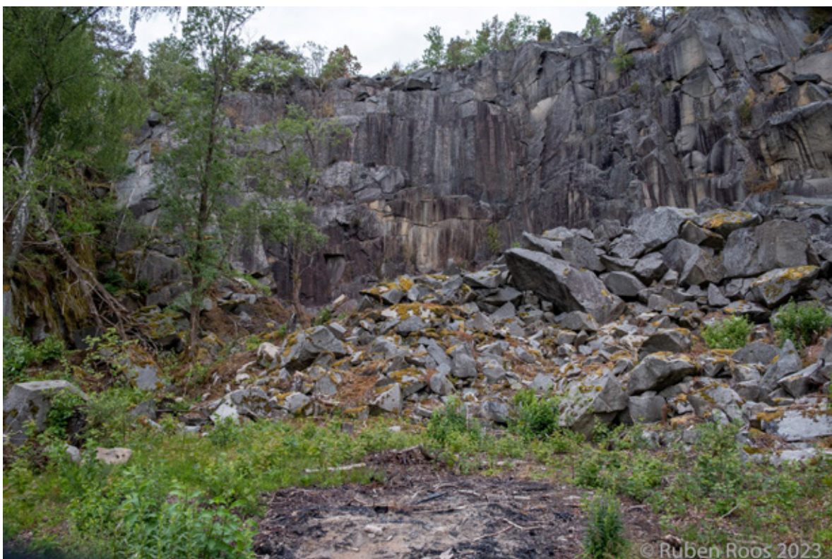
Figur 23. Hovsbruddet ved Hov i Halden etter rydding 19. juni 2023. Foto tatt mot nordvest: Ruben Roos.
