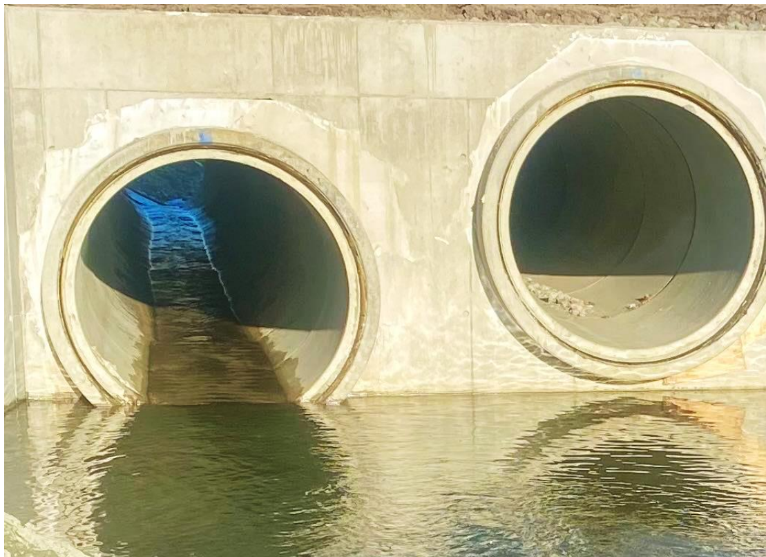
Figur 1. Ny dobbelkulvert i Sjøskogbekken etter nedlegging, med hovedkulvert til venstre og flomkulvert til høyre. Foto 30.10.2023, på lav vannføring, før installering av flexi-terskler i hovedkulverten. Foto: @Morten Andre Bergan,
