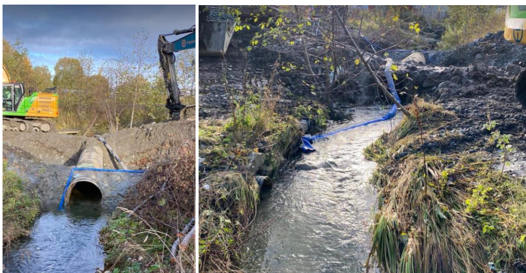
Figur 7. Gravearbeid og midlertidig rørløp av Sjøskogbekken senhøsten 2022. Foto: @Morten Andre Bergan
