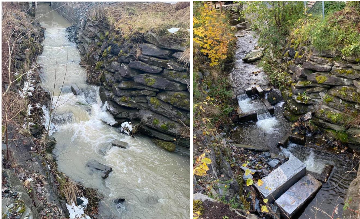
Figur 12. Fisketrappa like oppstrøms Ranheimsvegen. Foto på høy vannføring (til venstre) og lav vannføring (til høyre). Foto: @Morten Andre Bergan
