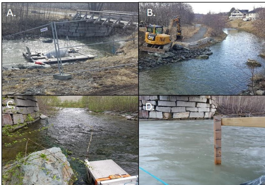
Vedleggsfigur 3A-D. A. Plassering av smolthjul i Vigda våren 2017. B. Tilpasning og utjevning av elvebunn med gravemaskin. C. Ledegjerde montert fra brukar og ned til smoltskue, og wire over elva for ekstra sikring av smolthjulet. D. Enkel målestav for daglig avlesing av vannstand gjennom smoltutvandringsperioden. Foto: Øyvind Solem, NINA.
