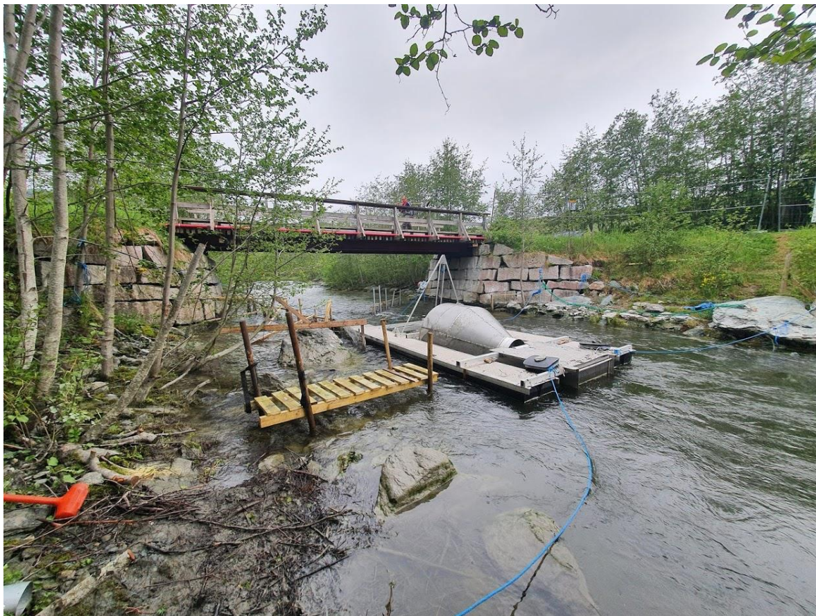
Vedleggsbilde 8. Rampe for lettere tilgang i forbindelse med røkting av smolthjul. Foto: Øyvind Solem, NINA.
