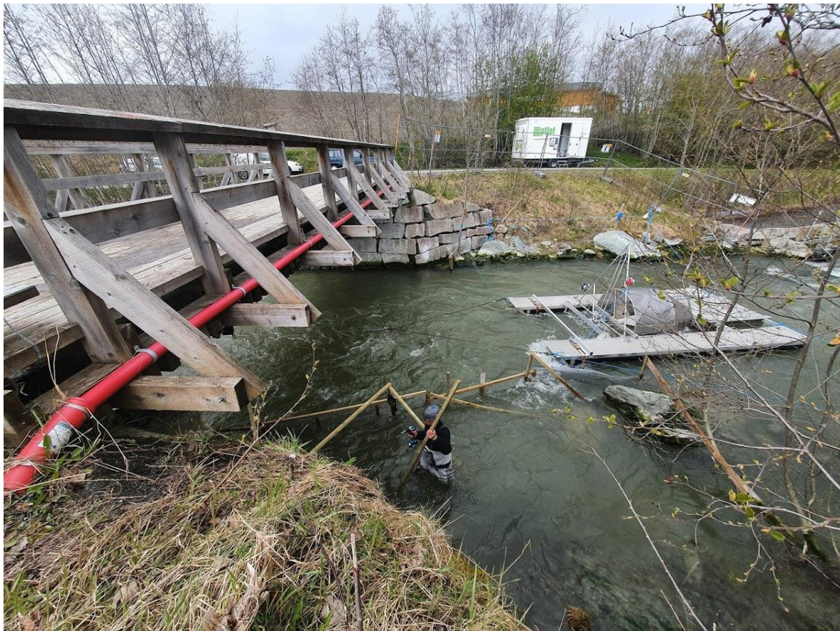
Vedleggsbilde 7. Montering av ledegjerde våren 2020. Mobil arbeidsbrakke som ble brukt under merking og prøvetagning ses i øvre halvdel av bildet. Foto: Øyvind Solem, NINA.
