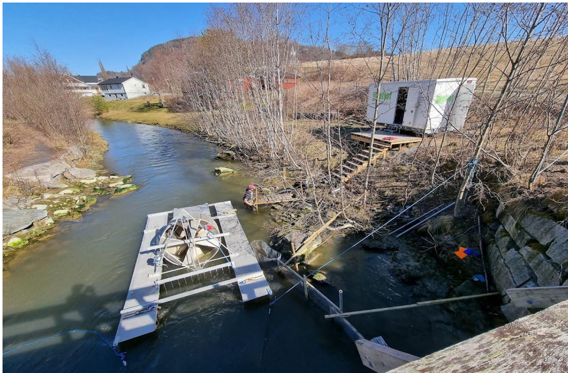
Vedleggsbilde 14. Situasjonsbilde fra 21. april 2022 i forbindelse med montering av ledegjerde og rampe etter utsett av smolthjul. Foto: Øyvind Solem, NINA.
