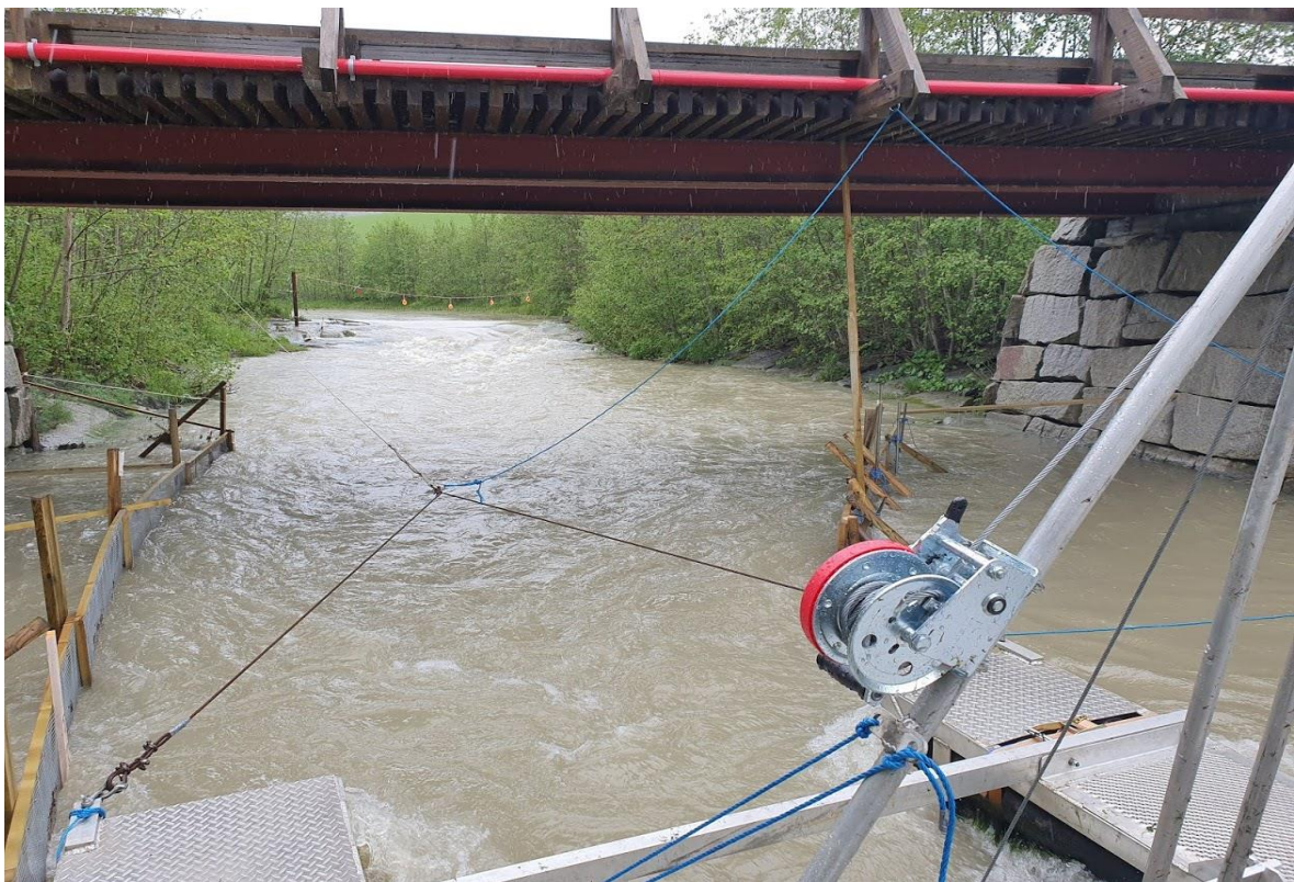
Vedleggsbilde 5. I 2019 ble det montert et ledegjerde på tvers av strømmen (til høyre i bilde) og et langs med elva (til venstre i bilde). Foto: Øyvind Solem, NINA.
