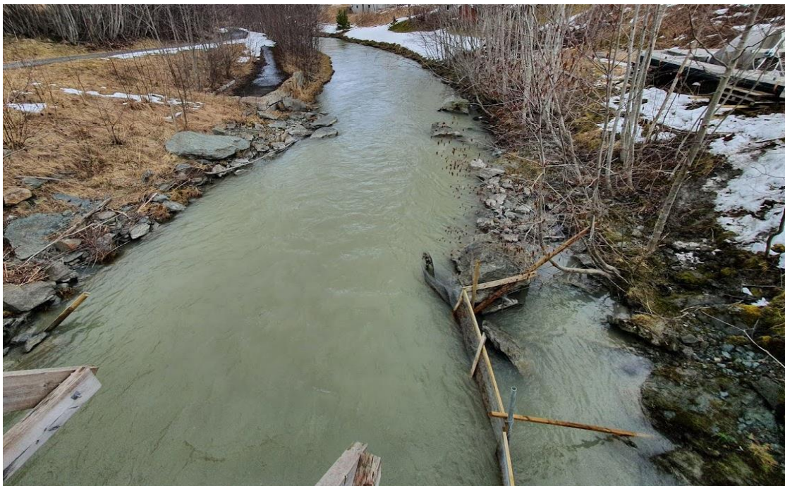
Vedleggsbilde 10. Ledegjerdet som ble montert på østre bredd 14. april 2021. Foto: Øyvind Solem, NINA.
