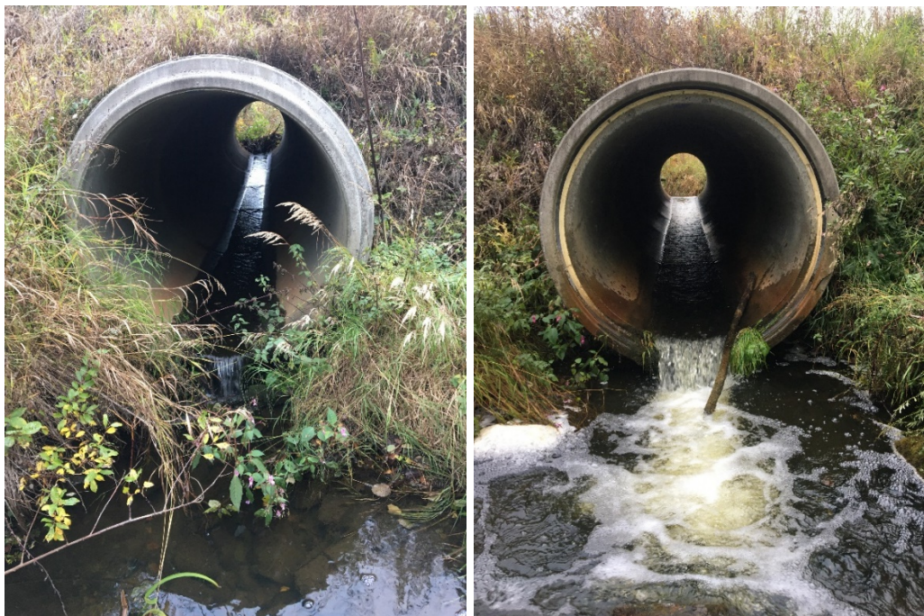
Figur 3. Antatt vandringshinder (for oppvandrende fisk) under dagens jernbanespor ved Gubberud i Stange. Foto: K.M. Myrvold, NINA.
