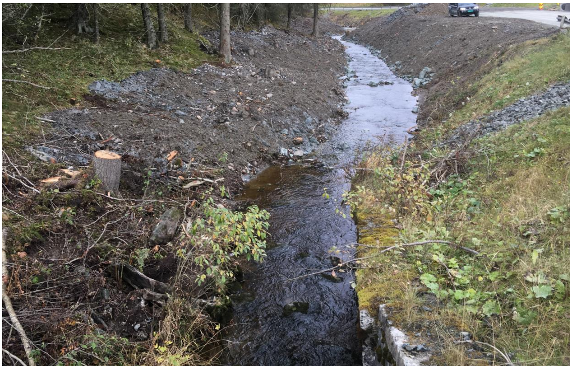
Figur 19. Solemsbekken nedenfor vegkrysning Amundalsvegen har ingen grad av naturtilstand i bekkeløpet helt ned til samløp med Amundsbekken, og er i dag 100 % endret og modifisert. Foto fra 2017, ved i igangsetting av dette sikringsarbeidet. Foto: @Morten André Bergan.
