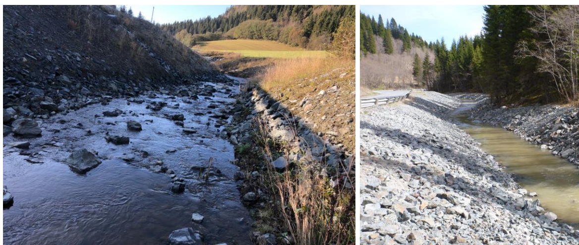
Figur 10. Amundbekken er 100 % endret og modifisert i midtre og nedre del etter vei- og rasrelatert aktivitet. Foto fra 2021 (t.v.) og 2012 (t.h.). Foto: @Morten André Bergan
