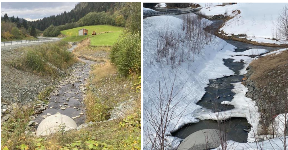
Figur 33. En kort strekning av Solemsbekken nedstrøms kulvert under Leiråkervegen er tilgjengelig for nidelvørreten, og er undersøkt for ungfisk av ørret i perioden 2019-2022. T.v.- Foto fra 2021. T.h.- foto fra 10.april 2023. Foto: @Morten André Bergan.
