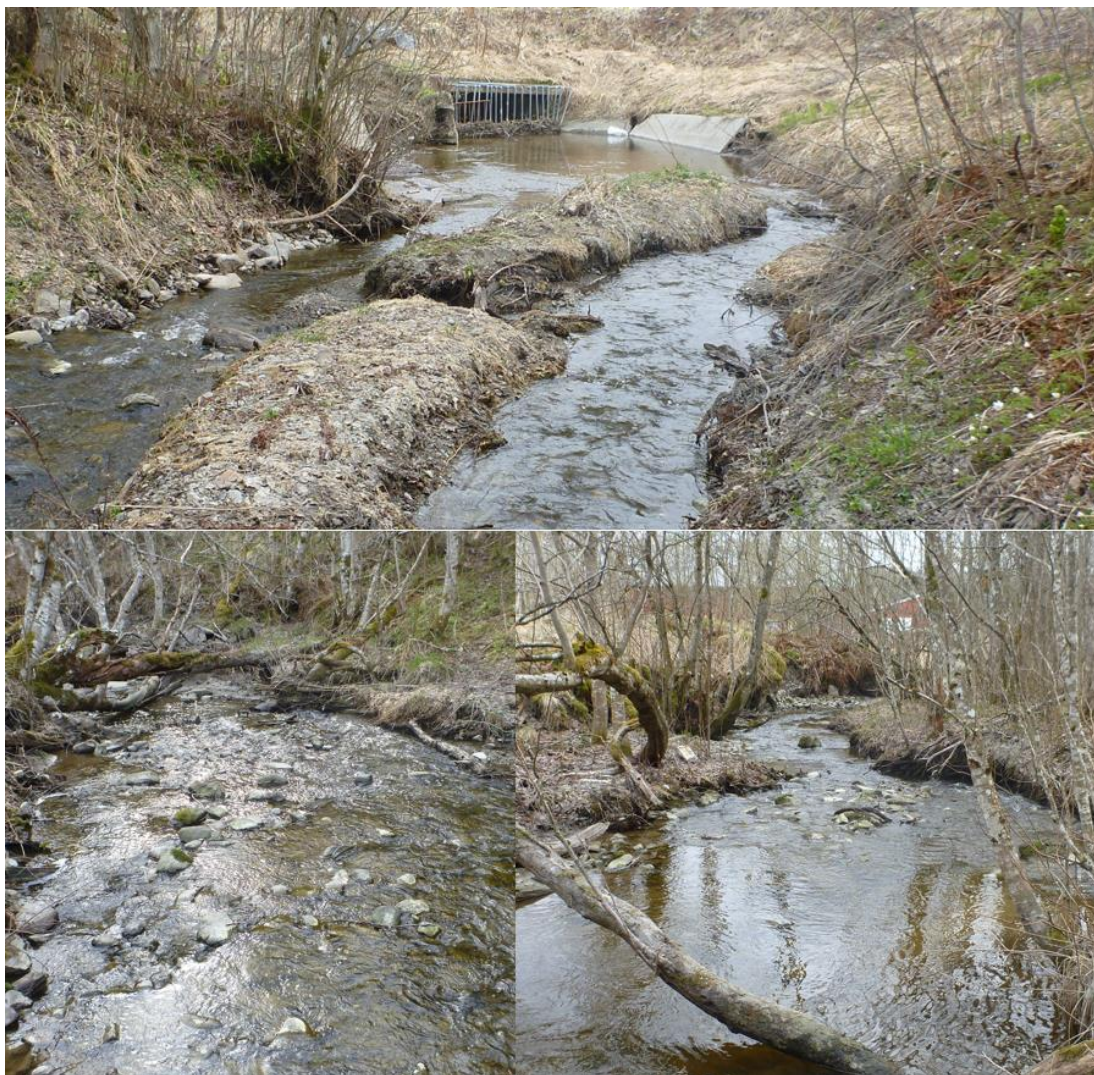
Figur 14. Røstadbekken ovenfor Leiråkervegen og ridesenter, etter en nærmere 500 meter lang bekkelukking. Svært godt egnet gytebekk med nært naturtilstand som i dag er utilgjengelig for nidelvørreten i Røstadbekken. Foto fra befaring ovenfor ridesenteret i 2013. Foto: @Morten André Bergan.
