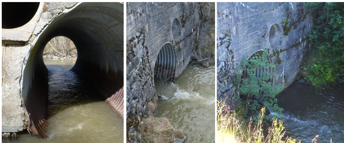
Figur 37. Kulvert under Nordsetvegen kan i perioder hindre oppvandring av ørekyte fra Nidelva, dersom Nidelvas vannstand er lav eller Amundbekken har stor vannføring. T.v. og midten: Foto fra mai 2013, der Nidelva har høy vannstand og Amundbekken normal vannføring, noe som gir muligheter for forbiwandring av ørekyte. T.h.: Foto fra 2012, med noe lavere vannstand i Nidelva. Foto: @Morten André Bergan.
