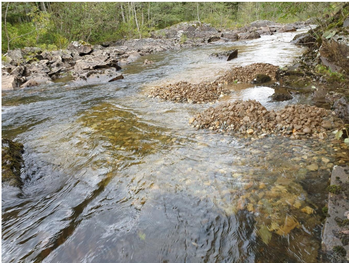
Bilde 11.2. Utlagt gytegrus i sideløpet ved Ingridøya. Når vannet stiger, vil elva selv transportere grusen til egnede steder langs sideløpet. Foto: Espen Holthe, NINA.
