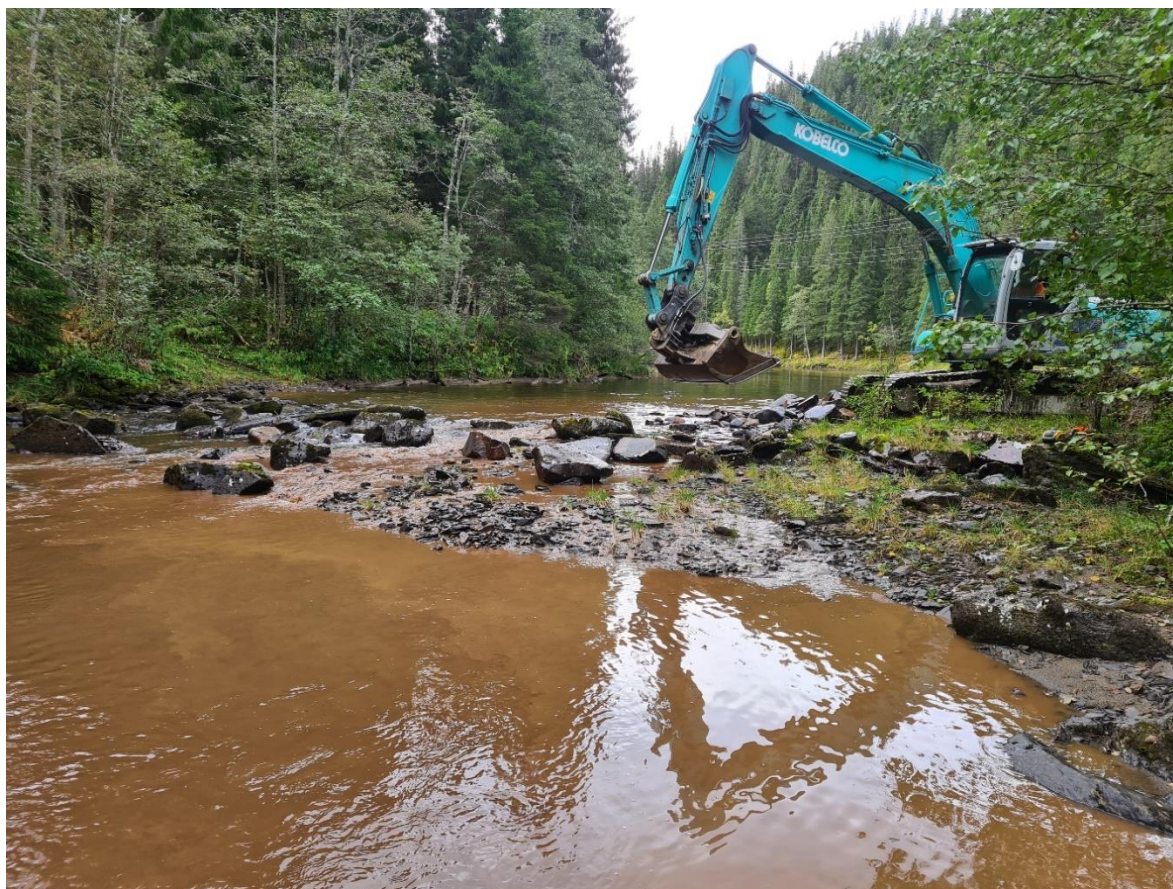
Bilde 11.1. Senking av terskelen ved innløpet til sideløpet ved Ingridøya. Foto: Harald Holm, TrønderEnergi Kraft AS.
