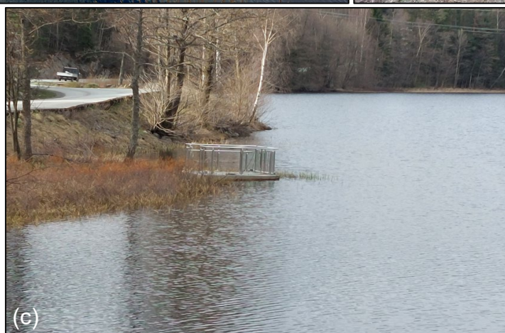
Figur 24. Området ved Rossevannet. (a) Rossevannet. (b) Dreneringsgrøft. (c) Vannuttak. Foto: Marie-Pierre Gosselin.
