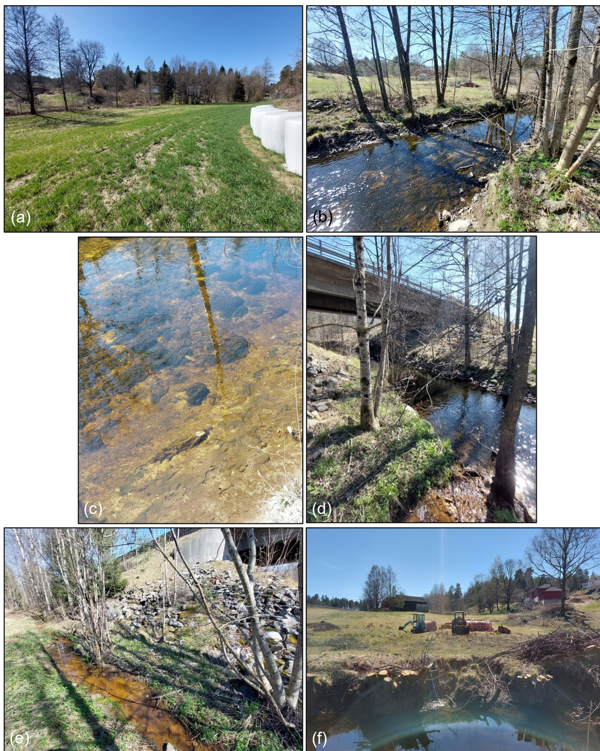
Figur 10. Lilleelv mellom E18-brua og Stampefoss. (a) Jordbruk langs elva. (b) Det er fortsatt noen trær på elvebredden. (c) Elvebunnen viser akkumulering av alger og finsedimenter. (d, e) Oppstrøms brua til E18 er det innløp av mulig forurenset vann til elva. (f) Tømmerhogst gjennomføres på elvebredden. Foto: Marie-Pierre Gosselin.
