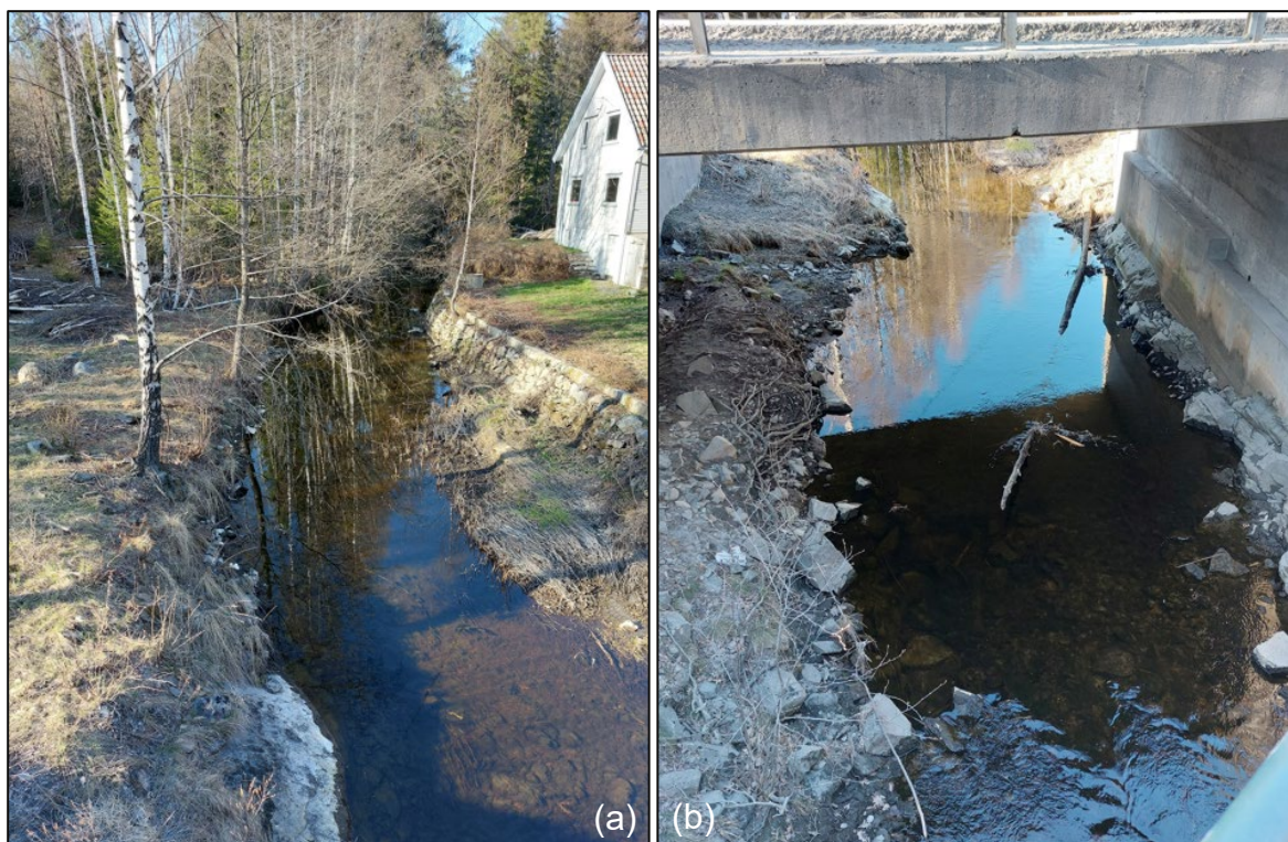
Figur 21. Lilleelv nedstrøms Assævannet. (a) Rester av tømmerfløttingsforbygning. (b) Erosjonssikring og betong tilknyttet brua over Frolandsveien. Foto: Marie-Pierre Gosselin.
