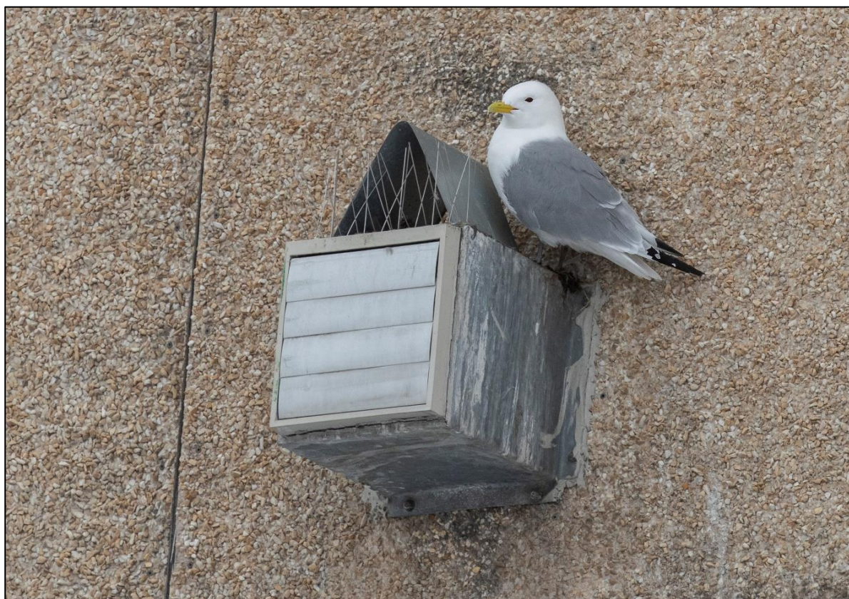
Figur 2.5. Vellykket tiltak for å hindre krykkjene å hekke på ventil. Her er det brukt både skråbord og fuglepigger. Karl-Otto Jacobsen©
