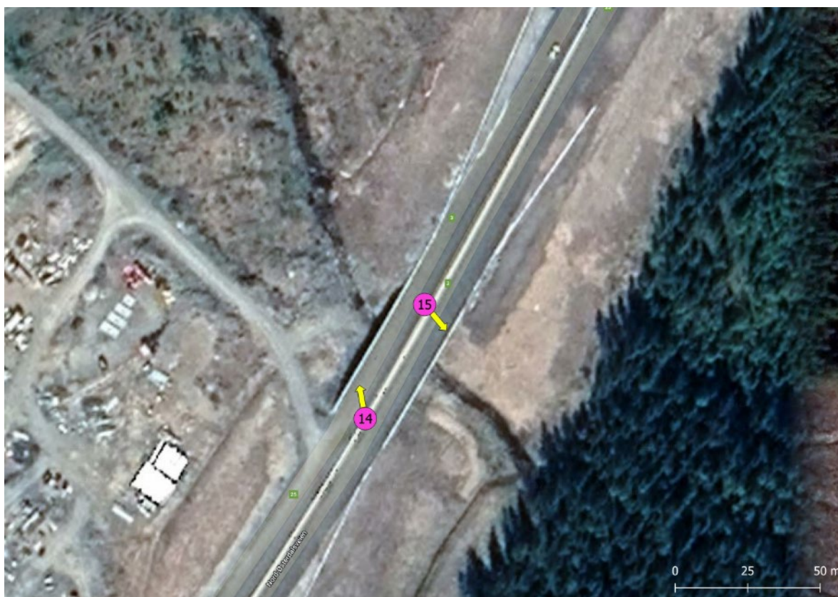
Figur 4. Faunapassasjen under brua som krysser elva Kakkhella. Rosa sirkler er plasseringen av viltkamera (under brua), mens gul pil indikerer hvilken himmelretning kameraet er vendt mot.
