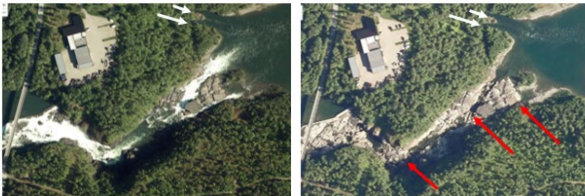
Figur 33. Flyfoto av Bardufossen, med og uten overløp over dam. Røde piler markere partier som fungerer som mulige vandringshindre når fossen er tørrlagt. Utløpene fra Bardufoss kraftverk er markert med hvite piler.
