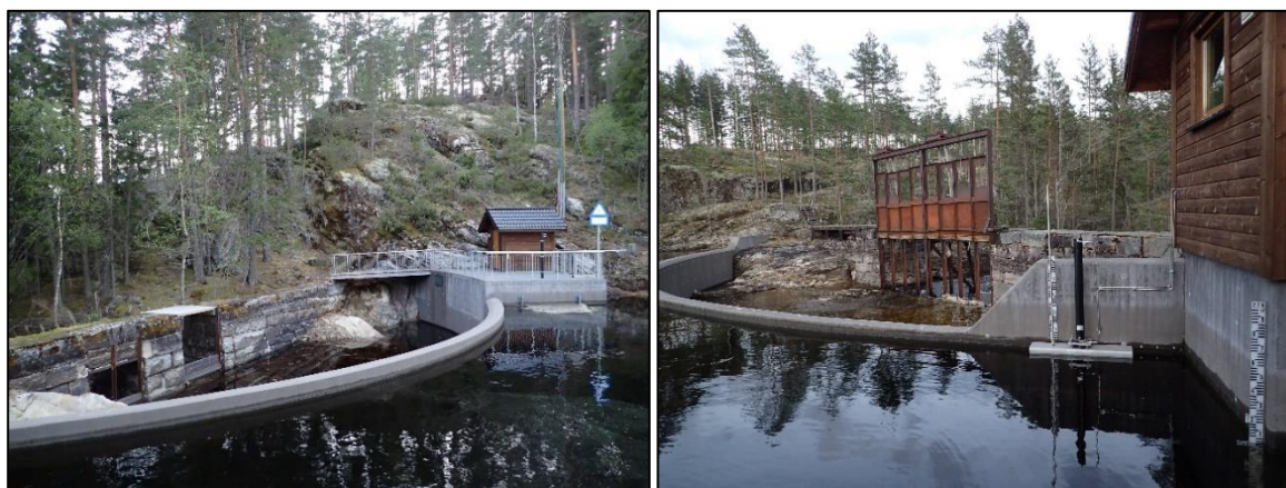
Figur 6. Gamle fløtnings- og reguleringsdammer og nye kraftverksdammer på utløpet av Follsjå – Vesledam til venstre og Storedam til høyre. Foto: Bjørn Mejdell Larsen.
