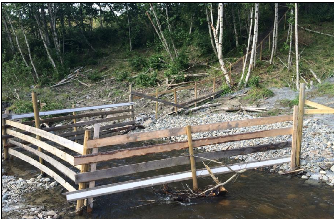
Figur 23. Inngjerdet drikkestasjon for husdyr (storfe) i Hofstadelva, Stjørdal (Trøndelag). Et svært godt tiltak for å unngå utglidning og ras langs kanten av elva. Kantvegetasjon har større mulighet til å utvikle seg raskt langs elvebredden, som blir mer stabil og gir mindre erosjon og utvasking av partikler til vassdraget. Videre reduseres mengden avføring fra kveget i vassdraget. Løsningen bør vurderes i de nedre delene av Meåsbekken. Foto: Morten André Bergan, NINA.
