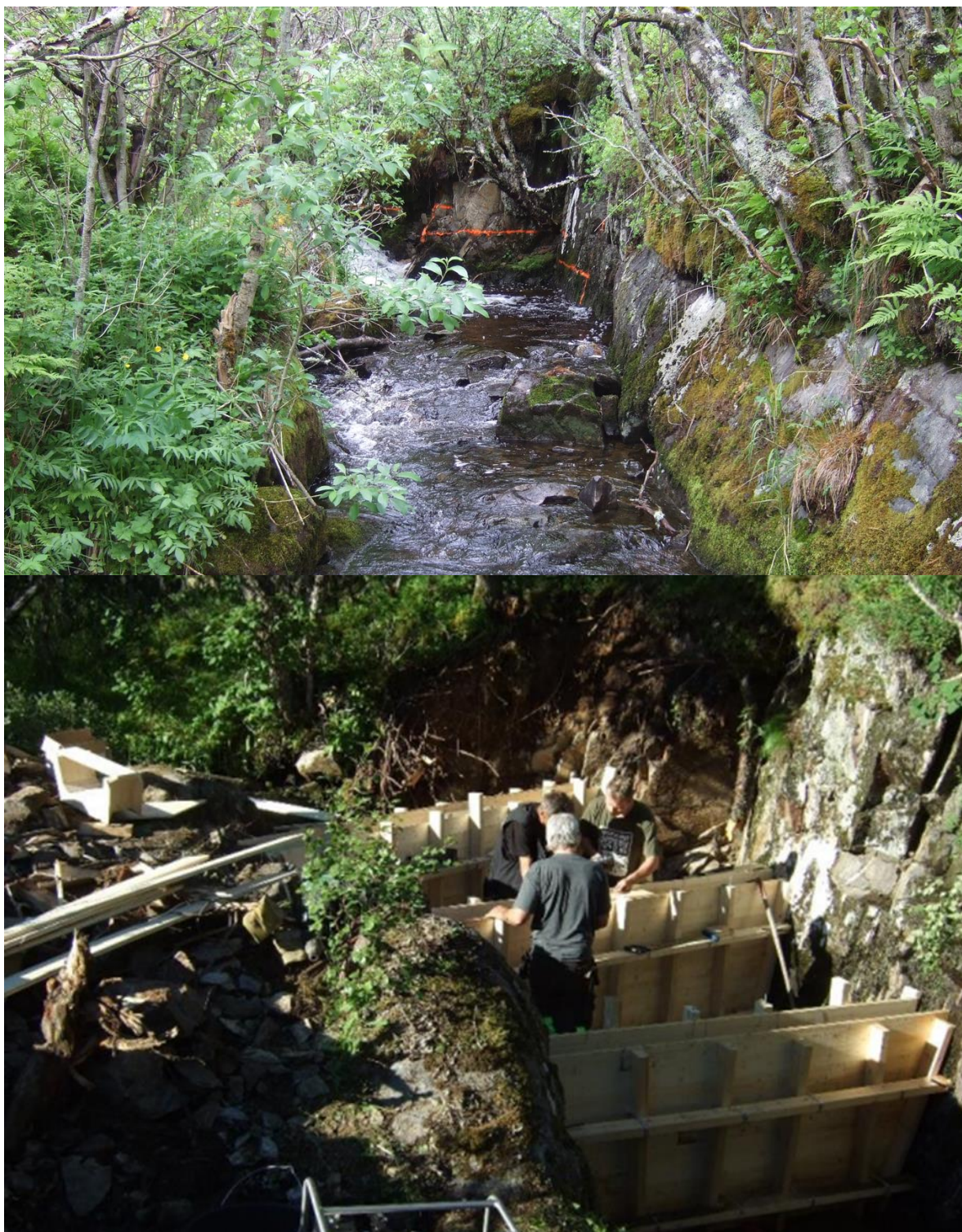
Figur 8. Før tiltak, med markering i fjellside for fundamentering av betongtersklene. Nederste foto viser bilde av selve byggefasen. Foto: Rødøy kommune.
