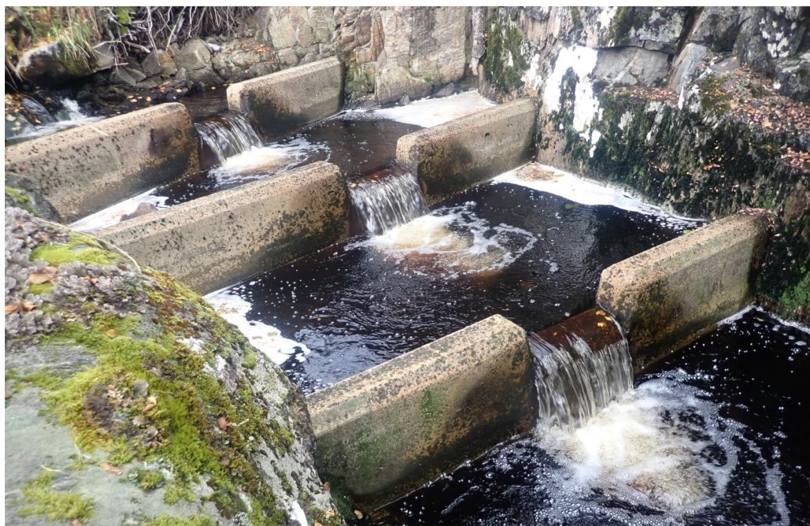
Figur 10. Fisketrapp i betong, forankret i fjell på begge sider, med avrundede spalteaåpninger. Foto nedstrøms og oppover. Foto: @Morten Andre Bergan
