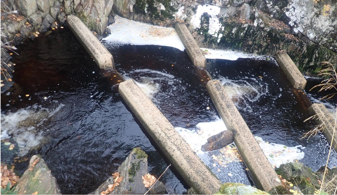
Figur 11. Fisketrapp i betong, forankret i fjell på begge sider, med avrundete spalteåpninger. Foto ovenfra og ned. Foto: @Morten Andre Bergan
