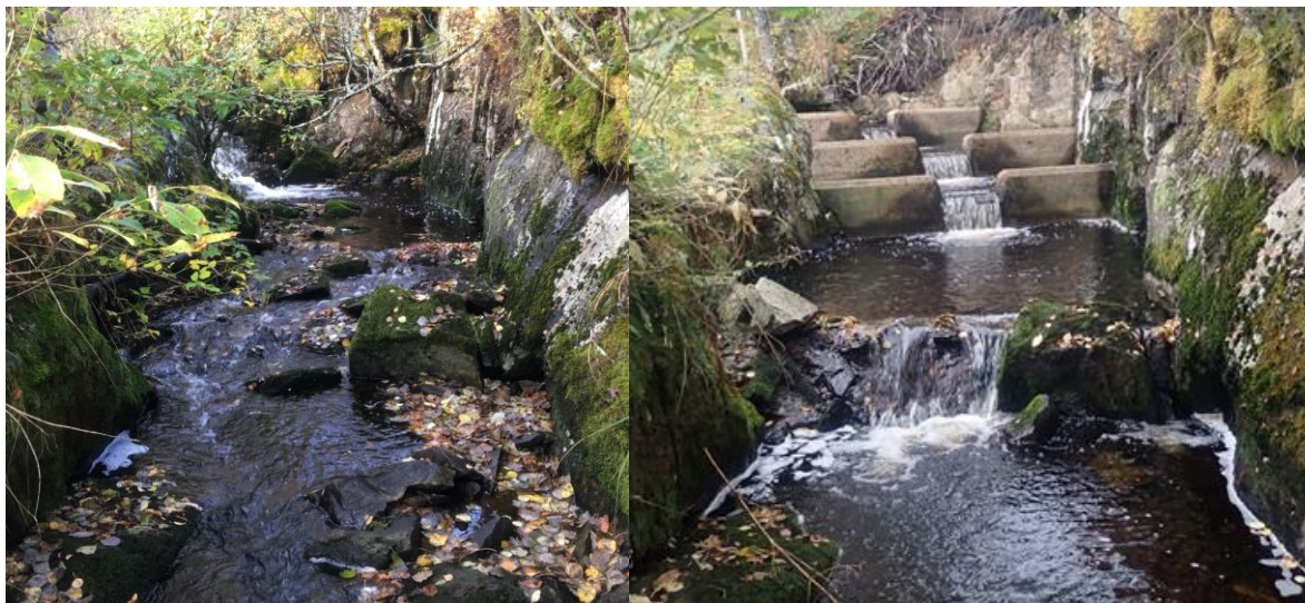
Figur 9. Før (t.v.) og etter (t.h.) tiltak med bygging av fisketrapp. Foto fra 2016 (t.v.) og 2022 (t.h.). Foto: @Morten Andre Bergan
