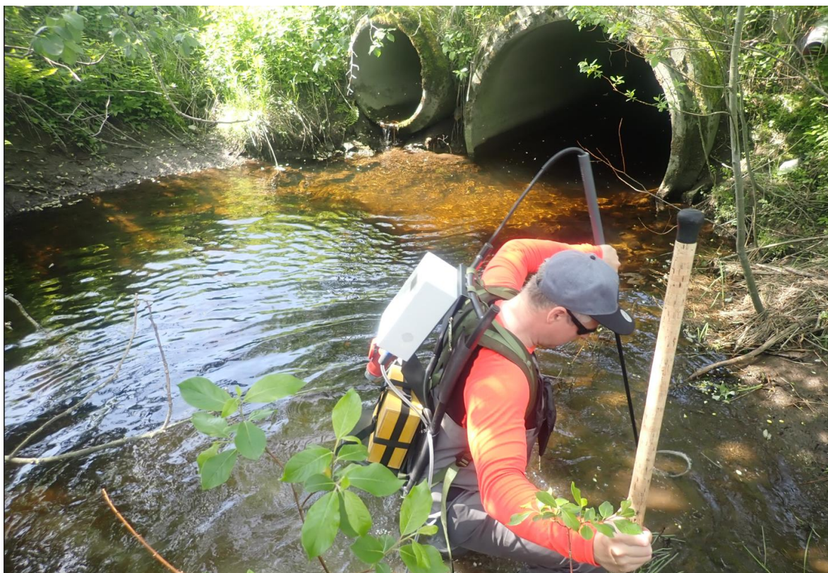
Figur 21. Nesbekken er lukket i kulvert under bakken fra dette punktet (kartref 32 V 7006852 N, 492364 E) og opp til Hovdeset bussholdeplass; en strekning på i overkant av 240 meter i luftlinje. Det ble utført søk med elfiskeapparat fra området i bildet og nedover mot samløp med Staursetelva. Foto: @NINA
