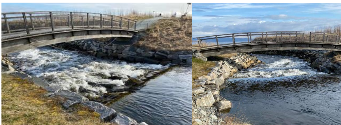
Figur 21. Nederste terskel (nr. 1) og stryk-renne på høy, fiskeførende vannføring. Foto fra 28. april 2018. Foto: @ Morten André Bergan.
