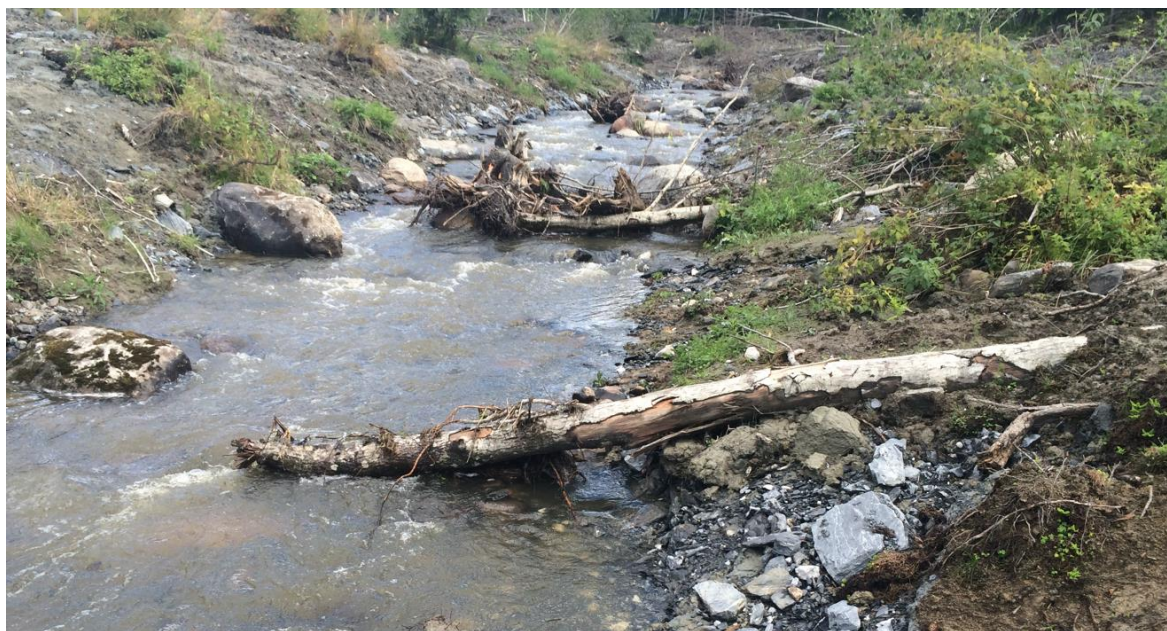
Figur 16. Bruk av dødt trevirke og røtter langs elvesidene ved restaurering av Hofstadelva, et sidevassdrag til Gråelva og Stjørdalselva i 2014/2015. Foto: Morten André Bergan.
