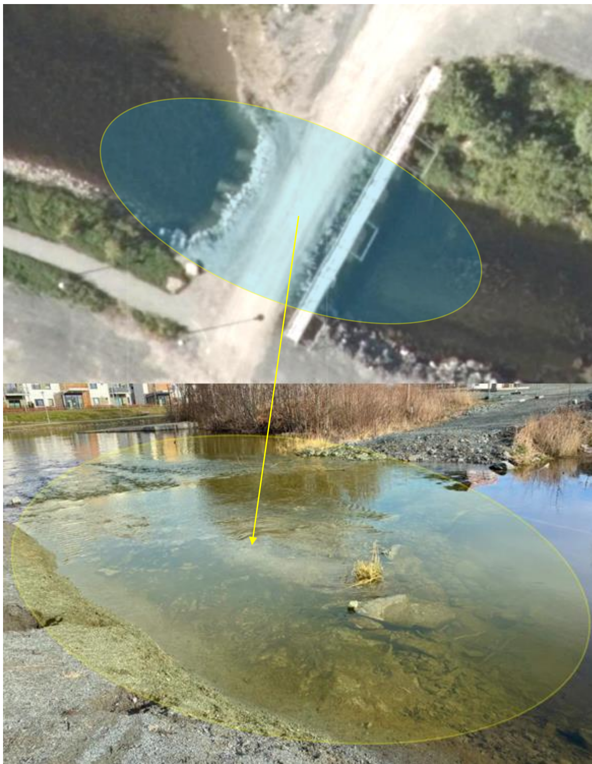
Figur 31. Utvalgt strykparti som i dag mangler egnet substrat, etter at en midlertidig vegkryssning med bru og kulvert ble fjernet i 2021. Pkt 7 i tabell 1 . Strykpartiet styrkes til gyteområde gjennom direkte utlegg i elva. Partiet må også få tilført mer storstein, alene og i grupper, samt at elvesidene bør få forankrede røtter og trestammer for bryte opp dagens svært sterile elvekant. Foto: @Morten André Bergan.
