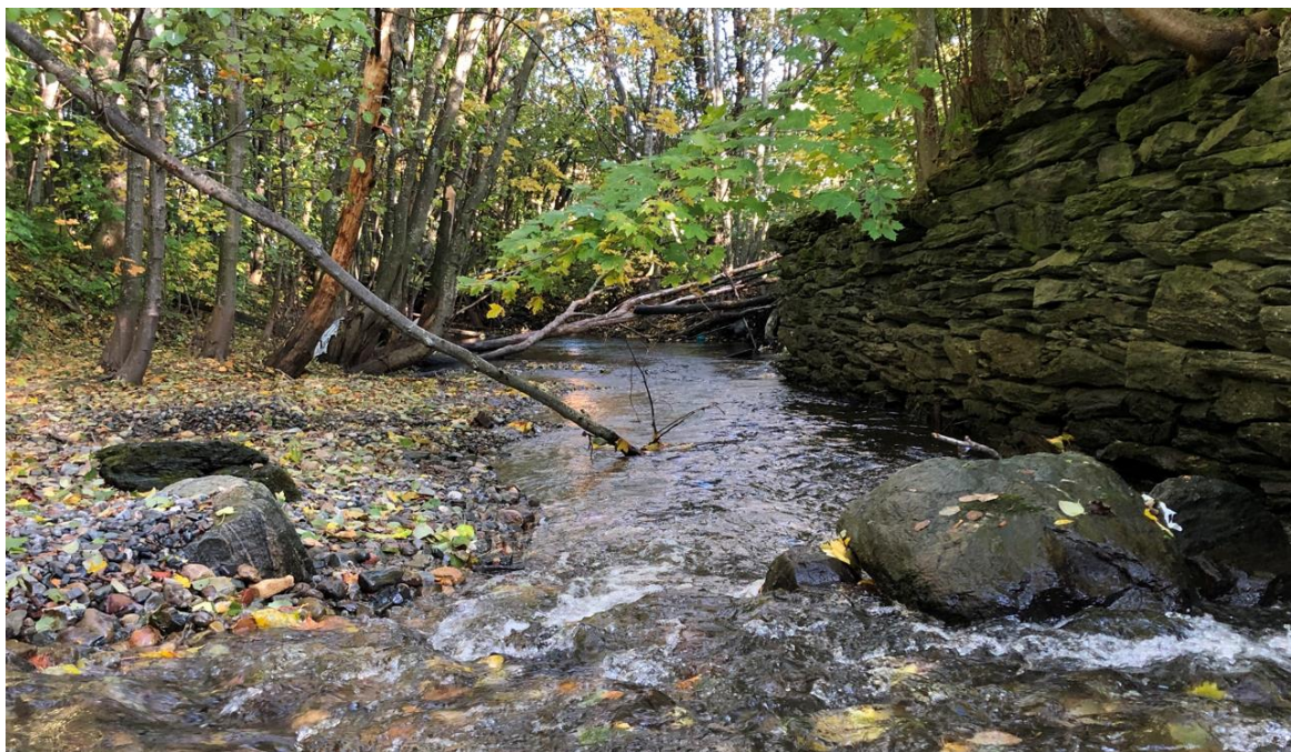
Figur 36. En støttemur/forbygning i elva er en av svært få inngrep og endringer i Vikelva på elveavsnitt B. Foto: @Morten André Bergan.
