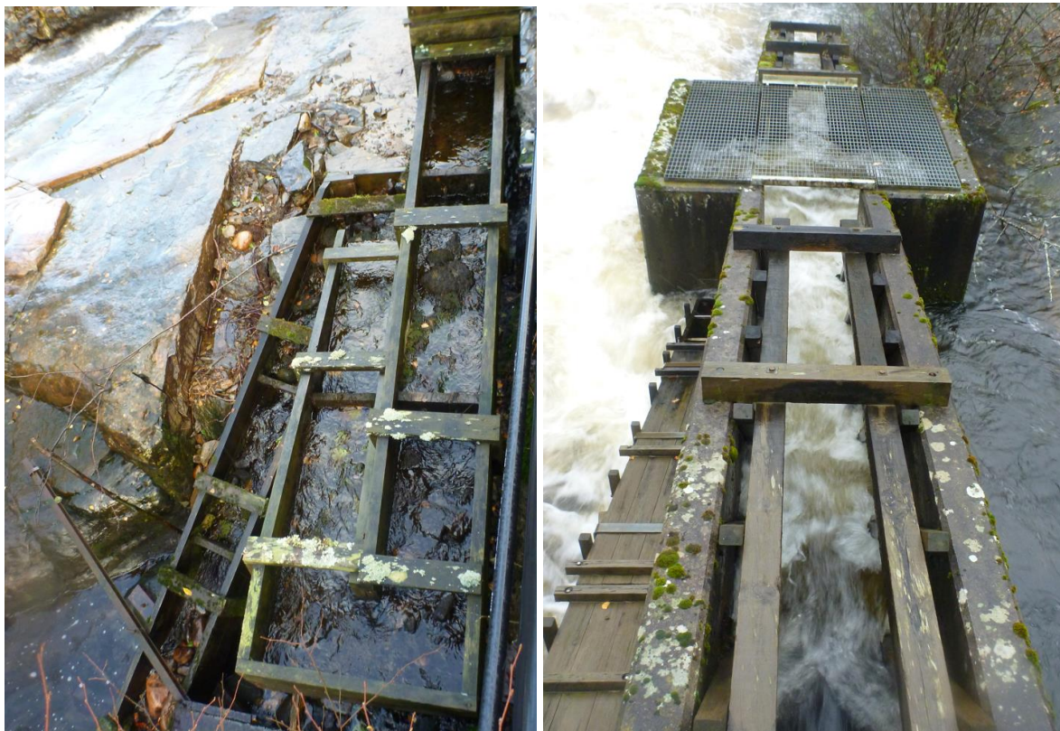
Figur 51. Eksempel på løsninger fra Sverige. Åletrapper for oppvandrende åleyngel forbi demninger og andre fysiske konstruksjoner som gir problemer for oppvandring. Lignende løsninger kan anvendes for demningene i Vikelva/Osvatnet. Foto: ©Morten André Bergan, NINA
