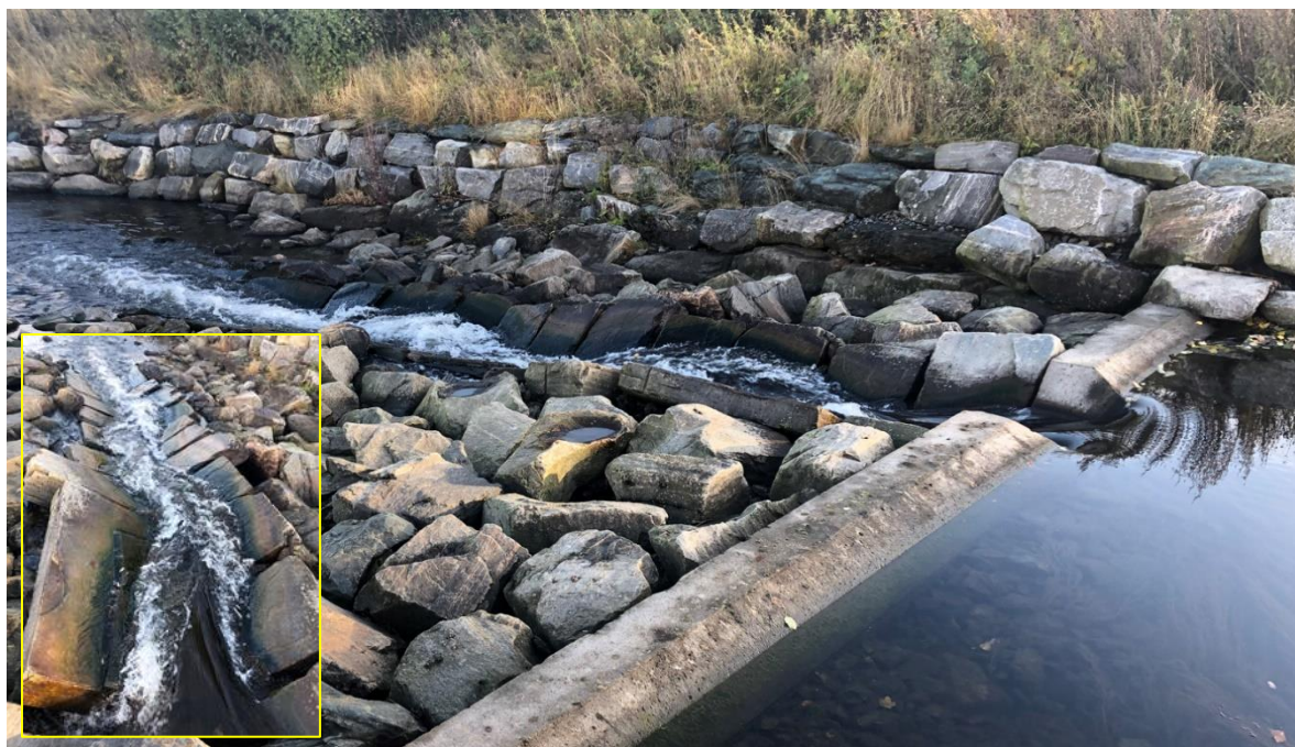
Figur 23. Øverste terskel (nr. 2) og stryk-renne er utformet som barriere for fiskevandring på lav og normal vannføring i Vikelva. Foto fra 17. oktober 2019. Foto: @ Morten André Bergan.
