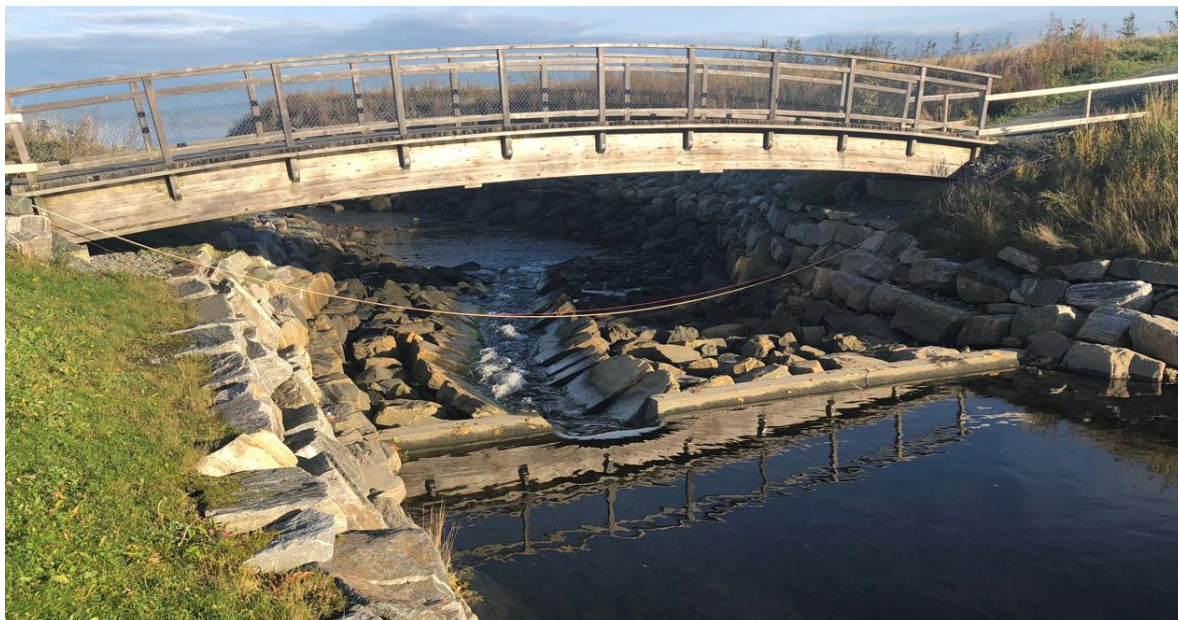
Figur 22. Nederste terskel (nr. 1) og stryk-renne er utformet som barriere for fiskevandring på lav og normal vannføring i Vikelva. Foto fra 16.oktober 2018. Foto: @ Morten André Bergan.
