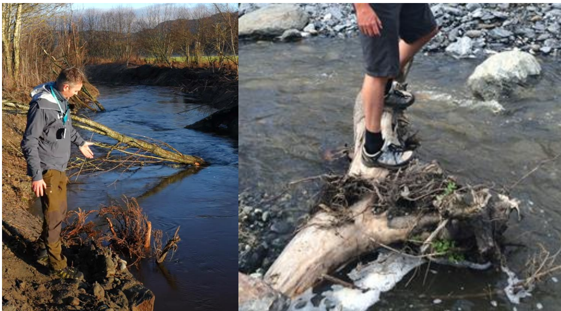
Figur 15. Bruk av dødt trevirke og røtter langs elvesidene ved restaurering av et sidevassdrag til Orkla i 2021/2022 (t.v.) og i Hofstadelva, Stjørdal i 2014/2015 (t.h.). Foto: NINA/NVE.
