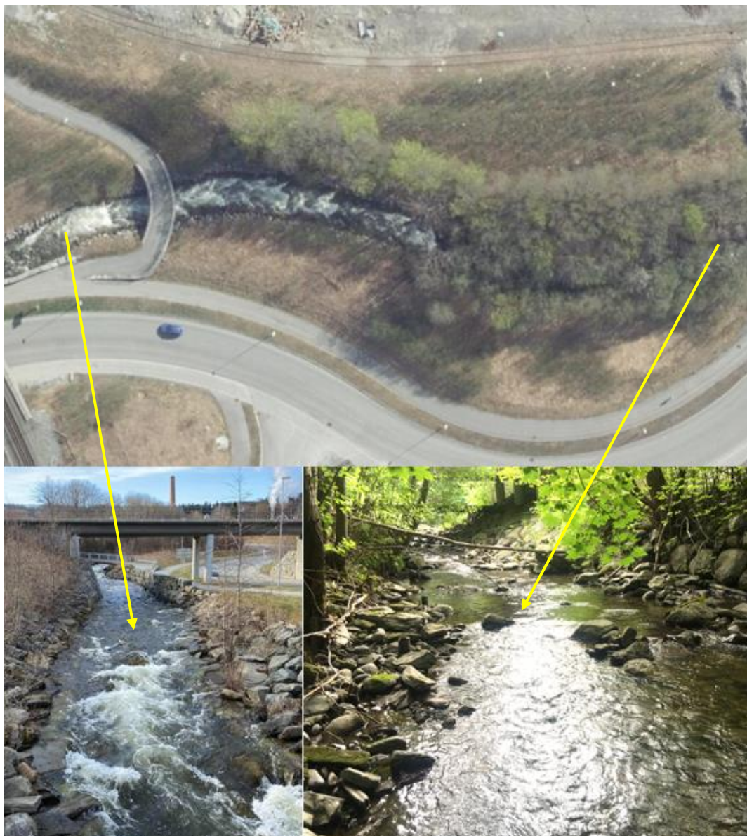
Figur 40. Kanalisert, avsmalnet og steinsatt strekning med manglende kantvegetasjon (t.v.) og med tett overhengende vegetasjon (t.h.) i elveavsnitt C. Brukarene for brukryssing Ranheimsvegen skimtes i bilde t.h. Foto: @Morten André Bergan. Flyfoto: https://kart.finn.no/
