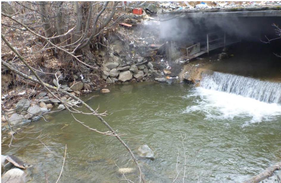
Figur 44. Gytesubstrat legges i elva og langs elvesider på strykpartier nedstrøms denne kulpen før elvelukking, men ikke i kulpen. Kulpen er dyp, 1,5-2 meter, og legges substratet her blir det liggende. Foto fra 2014. Foto: @Morten Bergan
