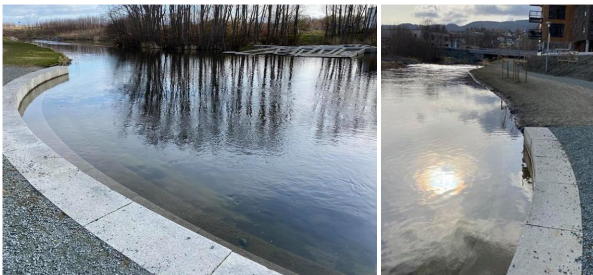
Figur 26. Elvebredden på høy vannstand i dammen. Det er svært lite miljøvennlig utforming av dambreddene, og det er tydelig at et parkmessig utseende har blitt prioritert foran vannmiljø ved prosjekteringen av dammen. Foto: @Morten André Bergan.
