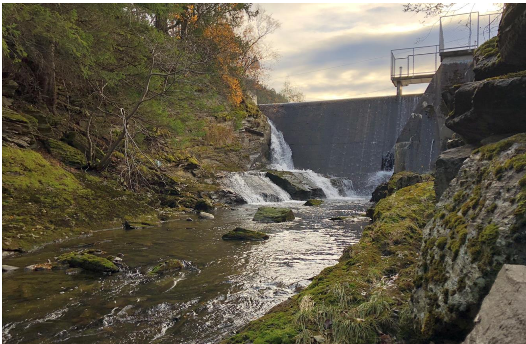
Figur 1. Demningen ved Nydammen. Foto: @Morten André Bergan.
