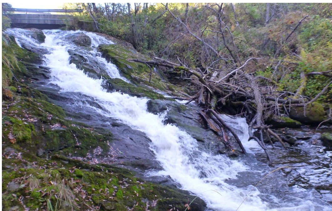
Figur 47. Foto av fossen fra 5. oktober 2012, mens Leirelva gikk på lav vannføring. Foto: @Morten Bergan.
