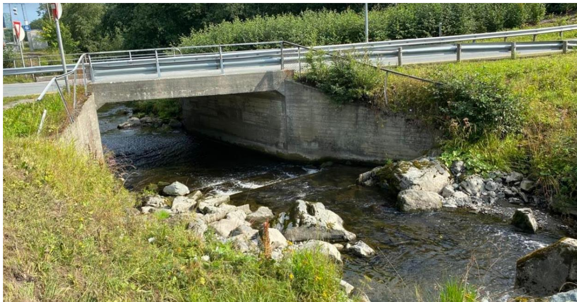
Figur 5. Bru for tidligere påkjøringsrampe fra E6, med betongbunn og terskler i tilknytning til brua. Foto ovenfra og nedover mot munning til Nidelva sommeren 2021. Foto: @Morten Bergan.
