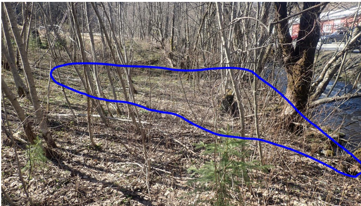
Figur 36. Utgraving av dypere kulp. Pkt 2 i figur 33 og 35 , fotografert fra en annen vinkel. Blå linje markerer område for utgraving av masser og etablering av kulp. Foto: @Morten Bergan.
