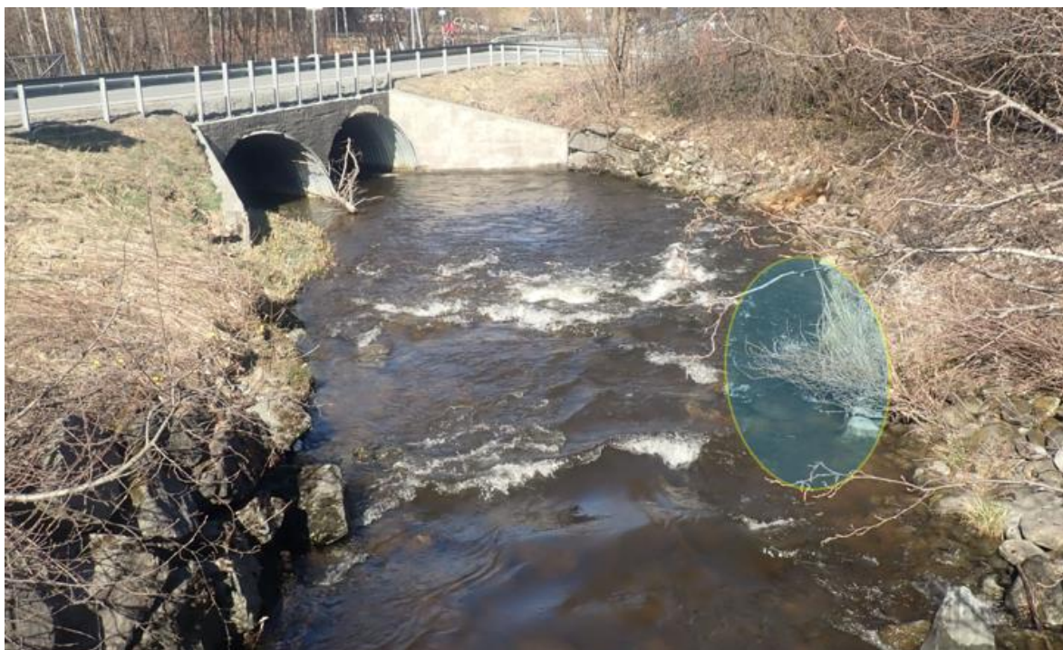
Figur 30. Storstein/blokk legges ut i anmerket elvebredd (rund sirkel), som en liten bune, i et forsøk på å styre vannstrømmen mer mot venstre kulvertløp på ulike vannføringer i Leirelva. Fot nedstrøms elva, ned mot dobbelkølvert. Foto: @Morten Bergan.
