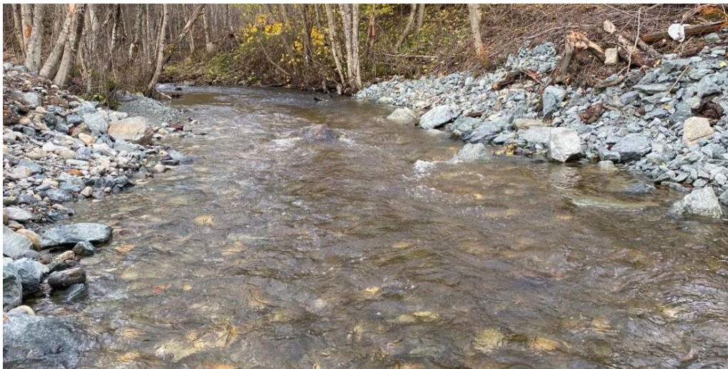
Figur 42. Nylig ras- og erosjonsikring av elvestrekninger i elveavsnitt D. Øverst i bilde vises rester av det opprinnelige elveløpet som var her før sikringsarbeidet. Foto: @Morten Bergan.
