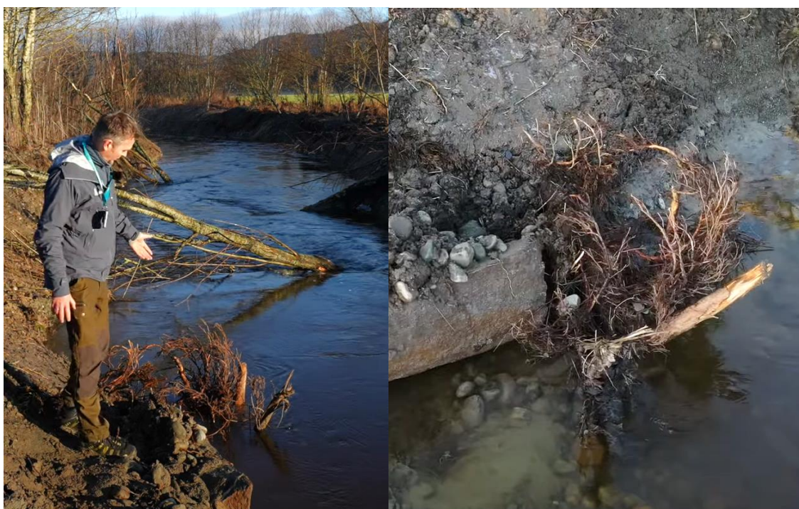
Figur 7. Bruk av dødt trevirke og røtter langs elvesidene ved restaurering av et sidevassdrag til Orkla i 2021/2022. Foto: @NINA.
