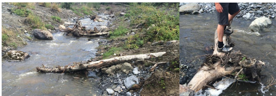
Figur 8. Bruk av dødt trevirke og røtter langs elvesidene ved restaurering av et sidevassdrag til Stjørdalselva i 2014/2015. Foto: @Morten Bergan.
