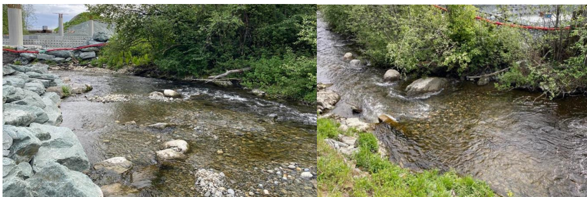
Figur 14. Omlag 50 kubikk gytesubstrat ble lagt ut fra pkt 2 til pkt 1 i figur 11 i mai 2022, ved en kombinasjon av direkteutlegg i elva (som vist på bildet), og deponier langs elvebredden og på strykstrekninger (Sedimentforvaltning). Foto: @Morten Bergan.
