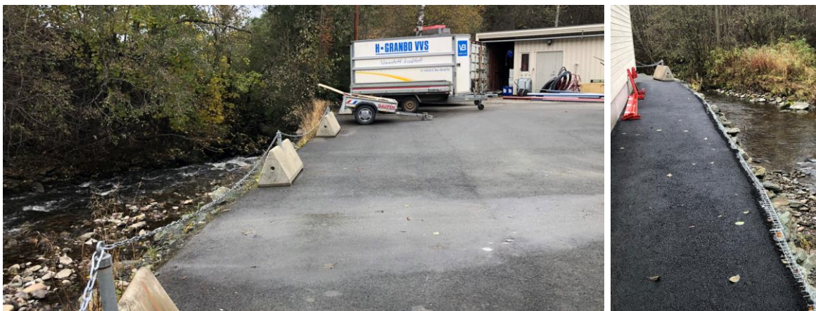
Figur 16. Uheldig utforming av uteområde hos Granbo VVS med hensyn til vannmiljøet i Leirelva. Uhellsutslipp på stedet vil gå direkte i Leirelva. Foto: @Morten Bergan.
