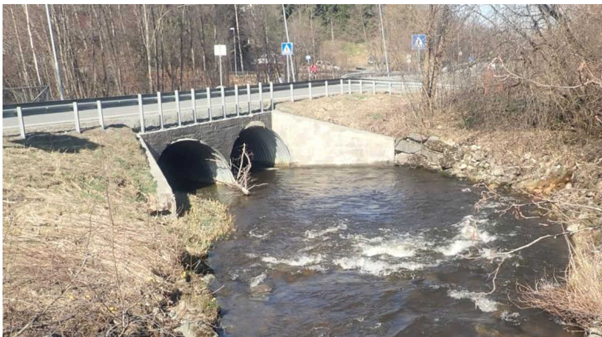
Figur 25. Dobbeltkølvert i Leirelva under veien Bjørndalen (veinr. 6682). Foto tatt nedover elva på høy vannføring i april 2022. Foto: @Morten Bergan.
