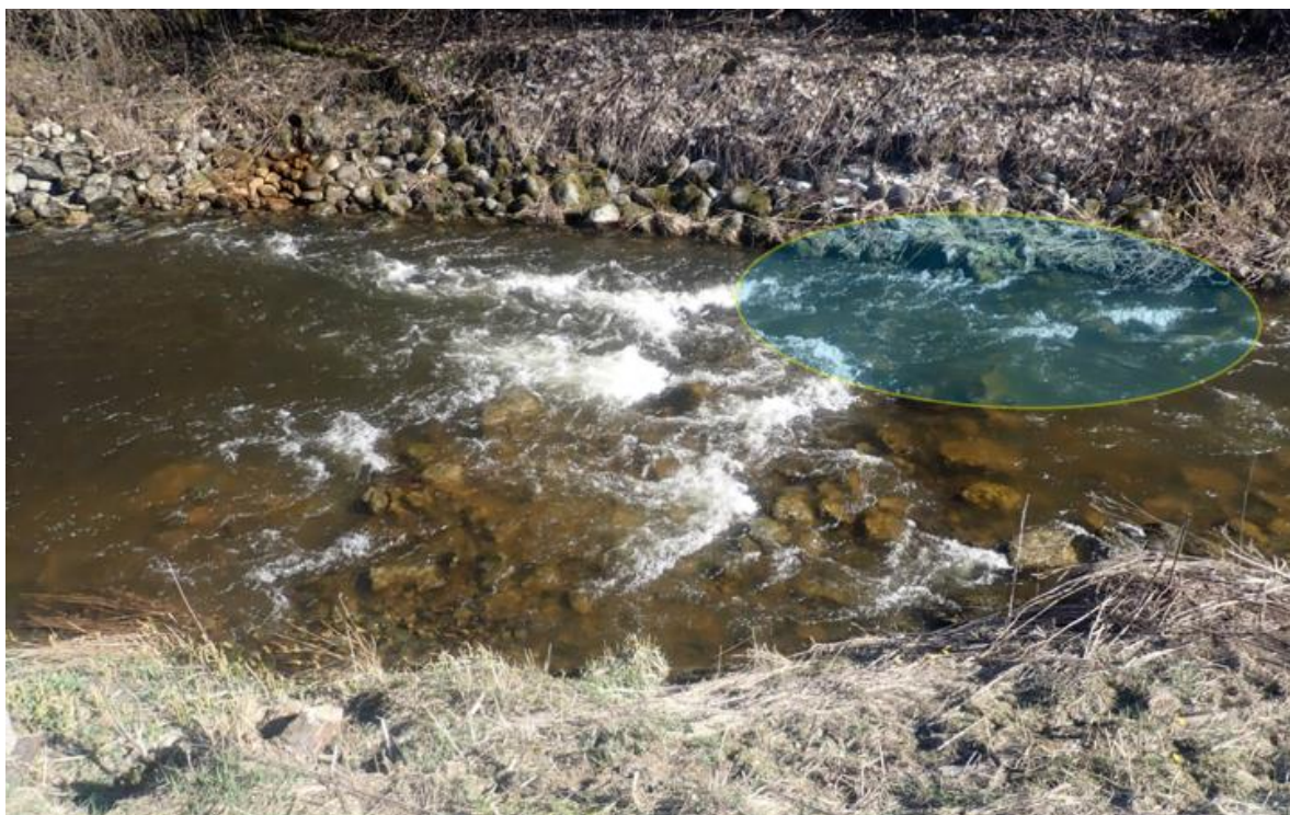
Figur 29. Storstein/blokk legges ut i anmerket elvebredd (sirkel), som en liten bune, i et forsøk på å styre vannstrømmen mer mot venstre kulvertløp på ulike vannføringer i Leirelva. Foto fra motsatt bredd. Foto: @Morten Bergan.
