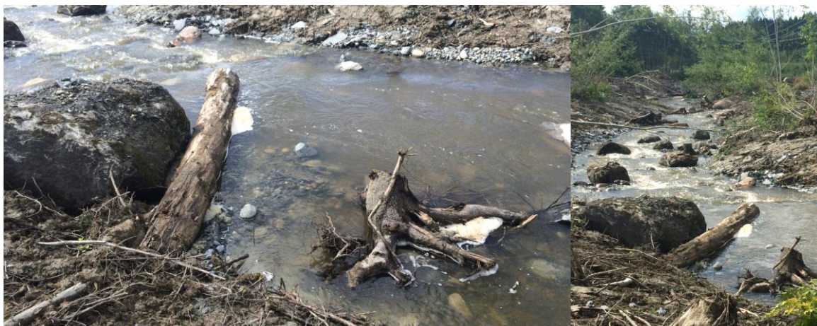
Figur 9. Bruk av dødt trevirke og røtter langs elvesidene ved restaurering av et sidevassdrag til Stjørdalselva i 2014/2015. Foto: @Morten Bergan.
