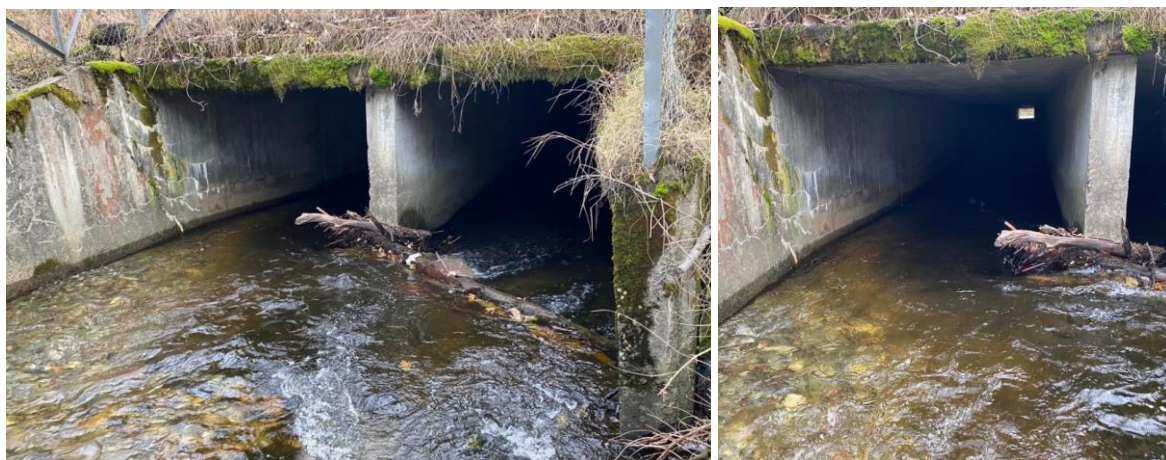
Figur 40. Kulvert under avkjøring til Romolslia i Leirelva. Foto på overside av veien. Foto: @Morten Bergan.
