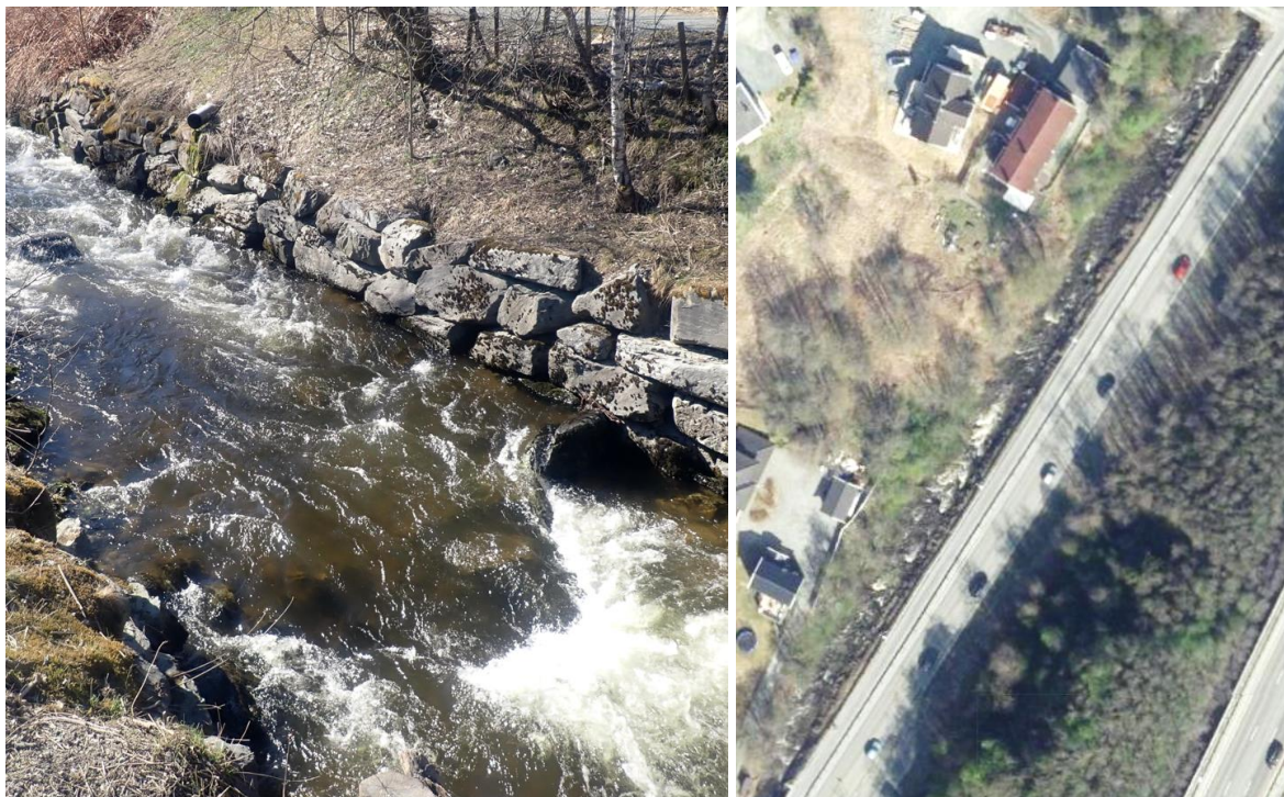
Figur 59 14. Dominerende vassdragslandskap i Leirelva i dag er steinsatte, utrettede og avsmalnende elvestrekninger, med underskudd på naturlig elvestein og uten velutviklet, naturlig kantvegetasjon. T.v.: Foto fra 2022. T.h.: Flyfoto 2019. Foto: @Morten Bergan. Flyfoto: https://kart.finn.no/ .
