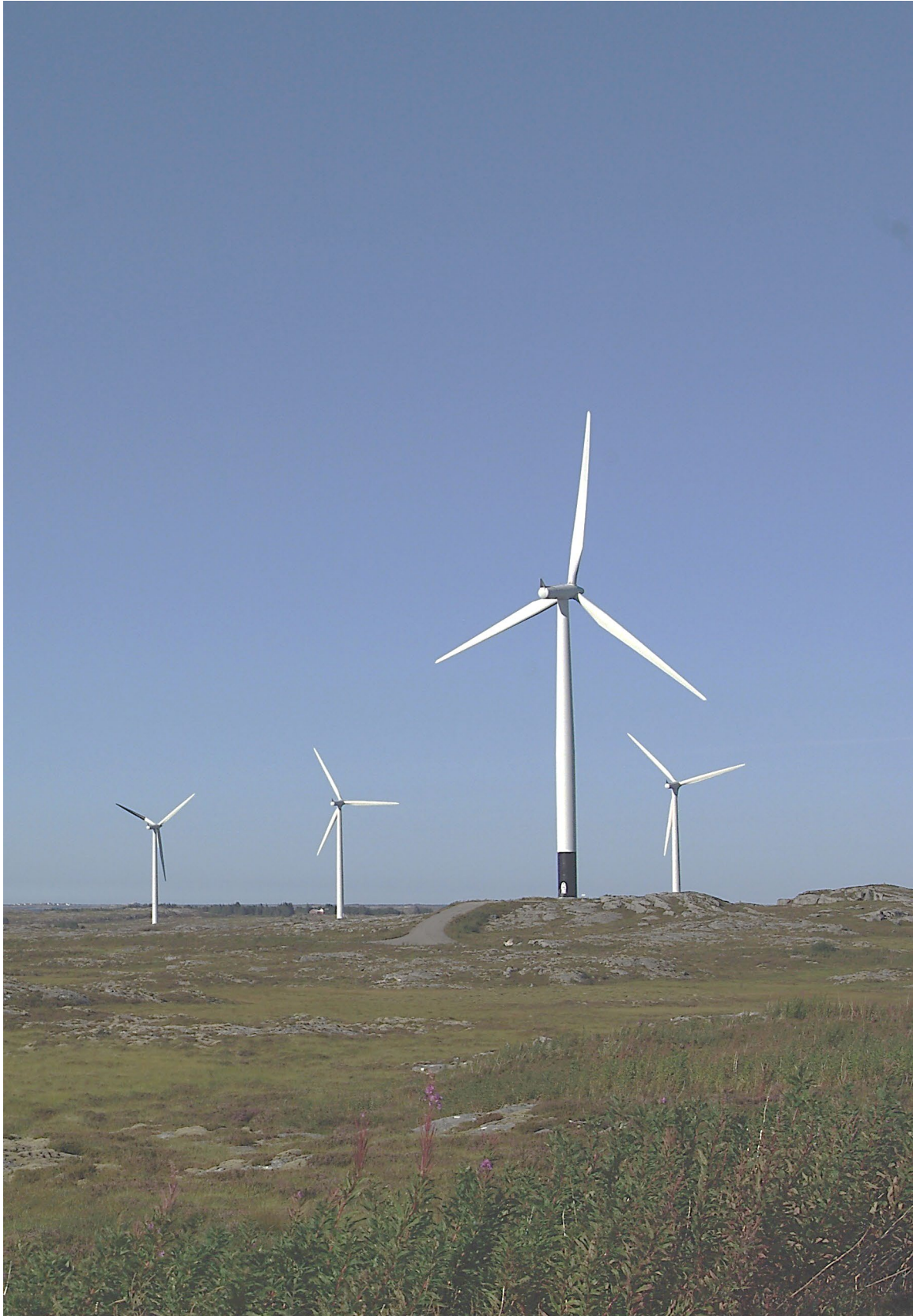
Figur 7. Vindturbiner med svartmalt rotorblad (venstre) og turbinbase (front) i Smøla vindpark. Foto: Roel May©.
