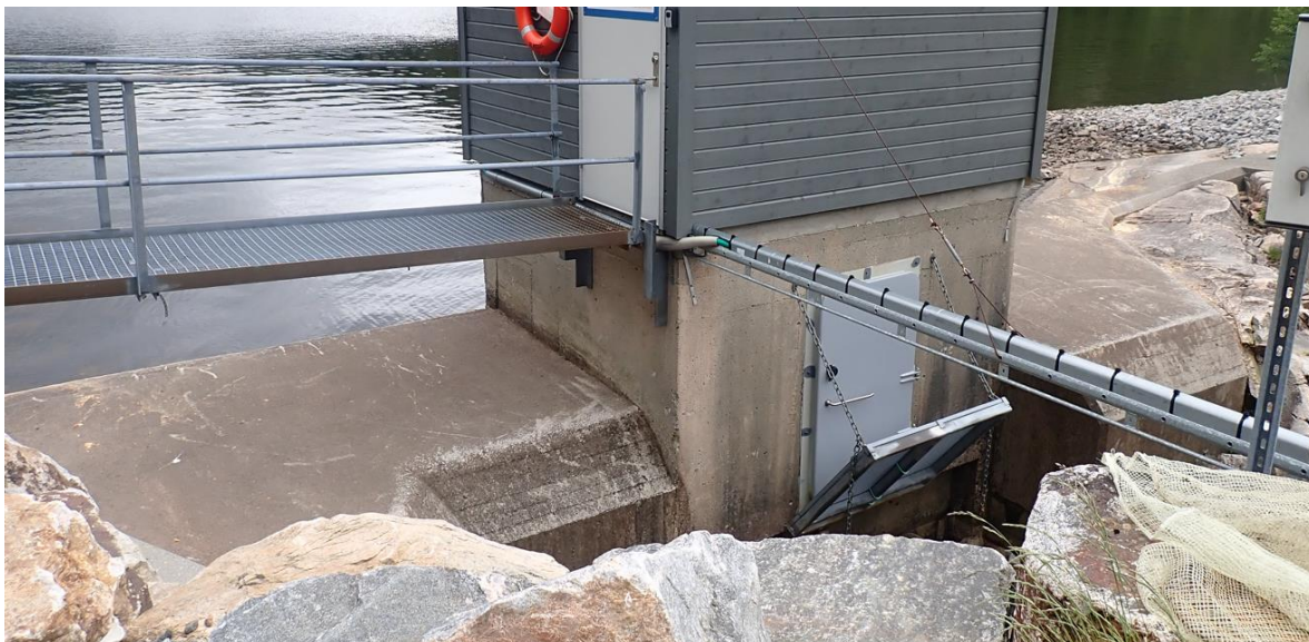
Figur 52. Foto av demning uten overløp. Foto: ©Morten André Bergan, NINA.
