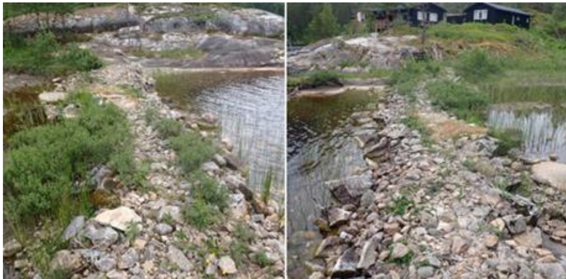
Figur 43. Demning lagt i utløp av Hattvatnet stanser vannavrenningen tidligere enn det som er naturlig avrenning. Foto: ©Morten André Bergan, NINA..
