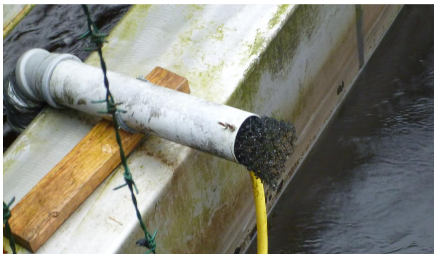
Figur 55. Rør kledd med netting, som gir ålen mulighet til å «klatre røret fra motsatt side av demningen på bildet, og forbi. Lignende løsninger bør vurderes for minstevannsføringsrøret ved demningen. Foto: ©Morten André Bergan, NINA.
