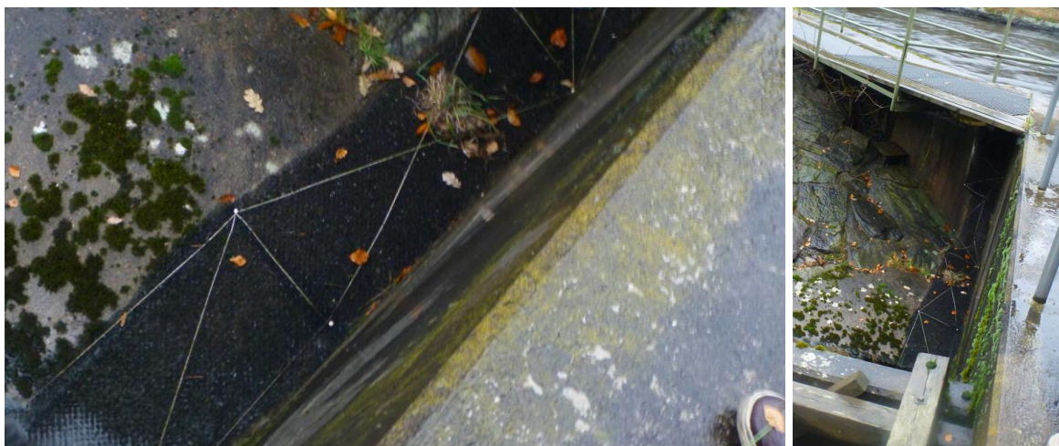
Figur 54. Nettingmatter montert for å gi små ål/ålefaringer gi mulighet til passering forbi demning i et vassdrag i Sverige. Foto: ©Morten André Bergan, NINA.
