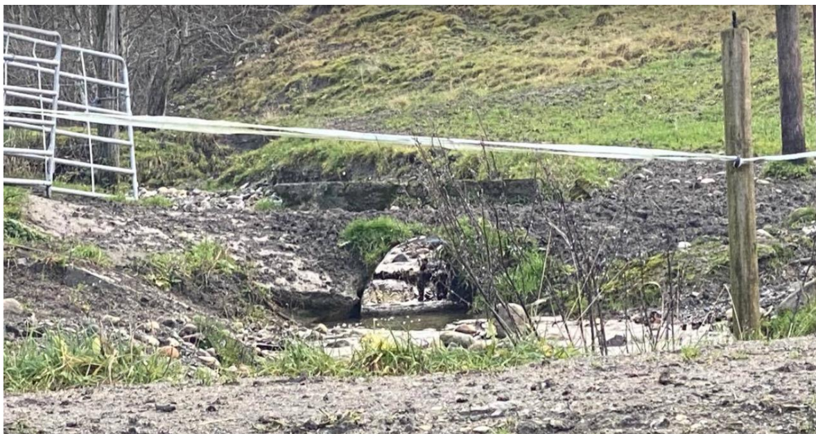
Foto 6: Tredje veikulvert under tredje veikrysning (traktorvei/kvegtråkk) i sidebekk til Kaldvella. Punkt 6 i kart 2. Foto: NINA.
