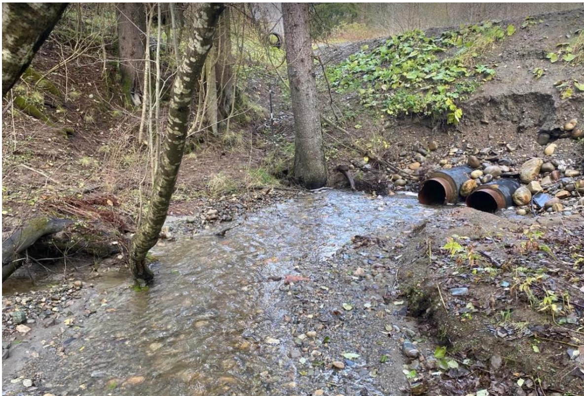
Foto 13: Oppstrøms kryssende grusvei og kulvertinnløp. Punkt 13 i kart 4. Foto: NINA
