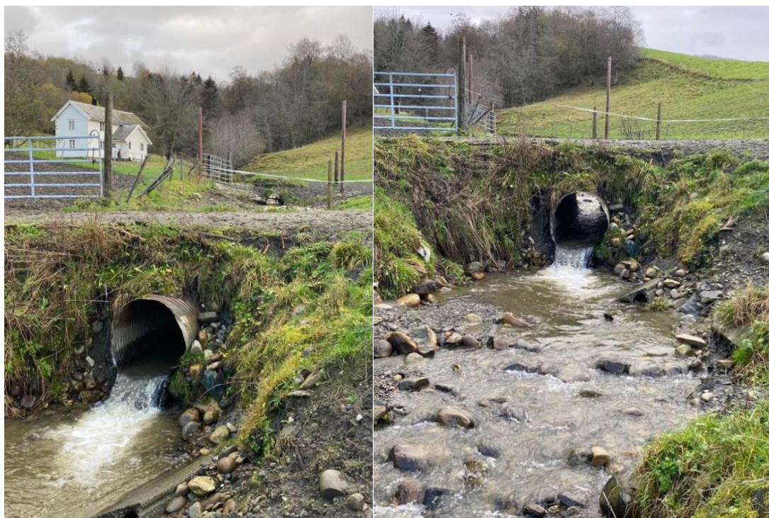
Figur 18. Ytterligere to kulvertkryssninger i sidebekken ovenfor nedre vegkryssning i figur 17 , der spesielt kulverten i forkant av bildene ikke er gunstig utfromet med hensyn til fiskevandring. Foto: NINA.
