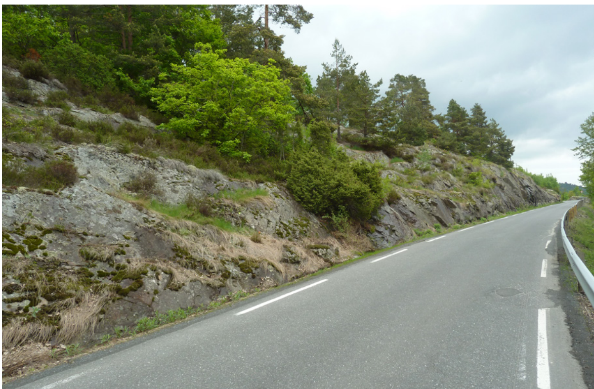
Figur 19. Veiskjæringen langs nordsiden av Dypvågveien fra avkjøringen til Vadstengene mot Åsstø 30. mai 2013 og det vil si før utvidelse av veien (Figur 18). Foto: Anders Endrestøl.
