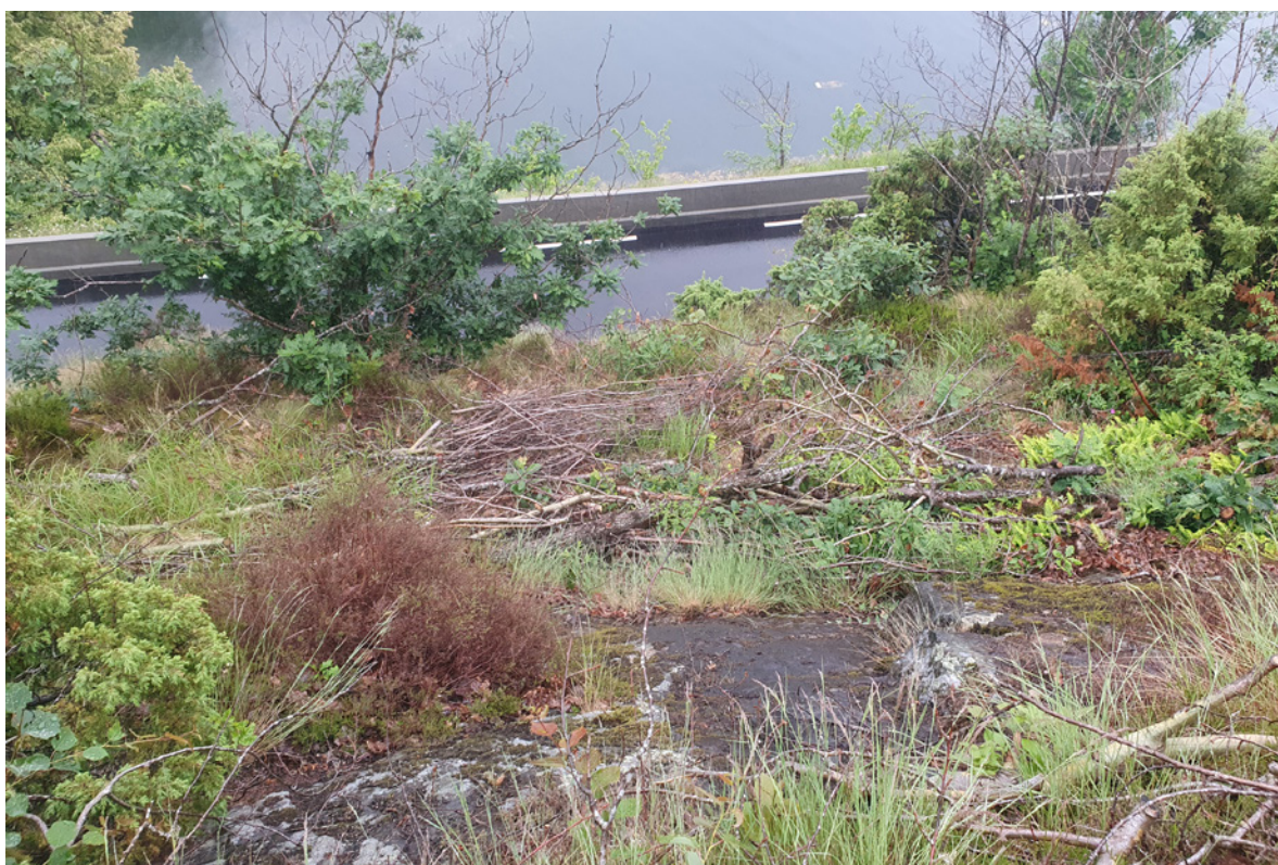
Figur 30. Veiskjæring og kraftgate på nordsiden av Dypvågveien vis-à-vis Rånatangen 20. juni 2021. Nokså mye kvist ligger igjen etter skjøtsel. Foto: Anders Endrestøl.
