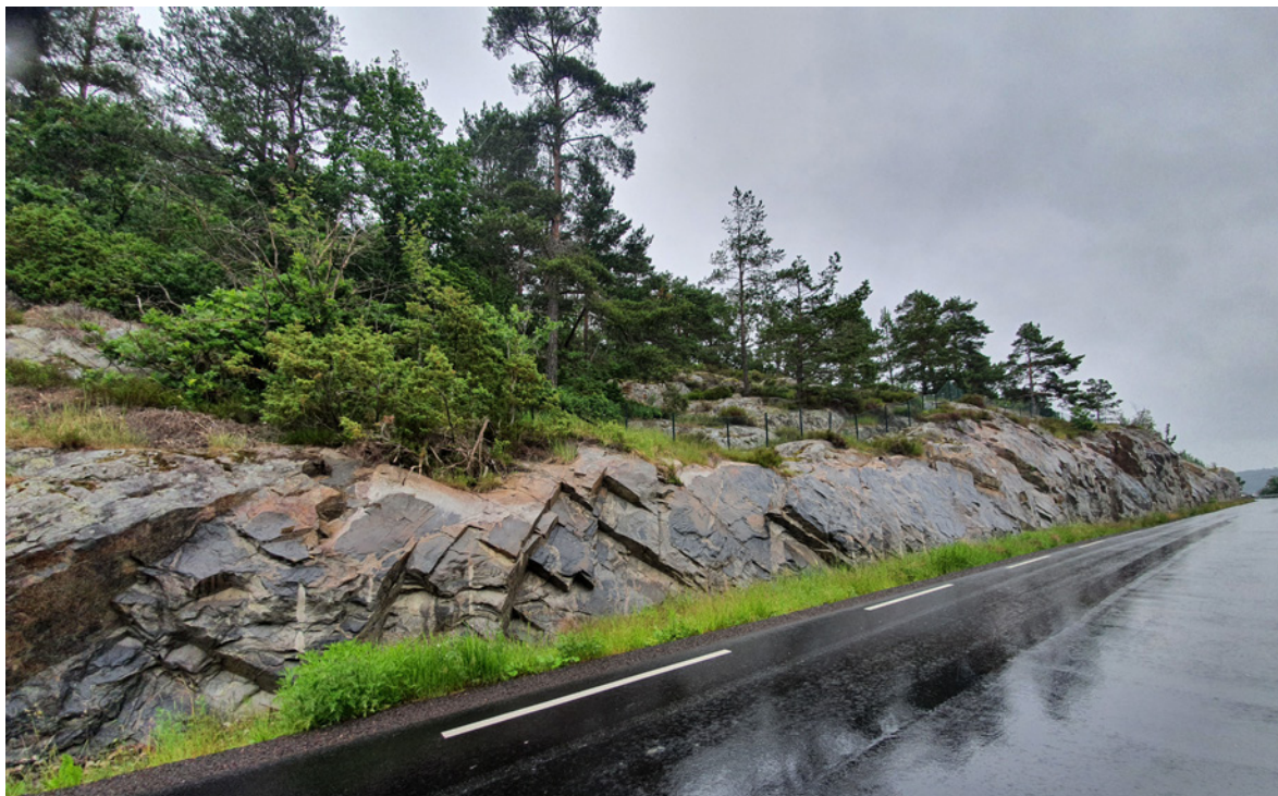
Figur 18. Veiskjæringen langs nordsiden av Dypvågveien fra avkjøringen til Vadstengene mot Åsstø 20. juni 2021. Her ble veien utvidet og veiskjæringen rensket i perioden 2016–2017. Her er det en blanding av impediment, kratt og røsslyng. Oppslag av osp, eik, rogn og vier. Begrenset med nektarplanter. Foruten røsslyng også blant annet noe annen lyng, bjørnebær, vivendel, rose og blåmunke. Begrenset mengde smørbukk (< 15). De fleste individene står ned mot veien. Foto: Anders Endrestøl.
