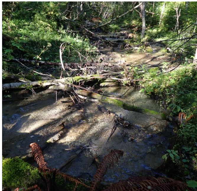
Foto 8: Vandringshindrende veikulvert i tilløpsbekken til Vikelva (t.v.), og partier i bekken ovenfor veien (stasjonsområde 6). Foto: NINA
