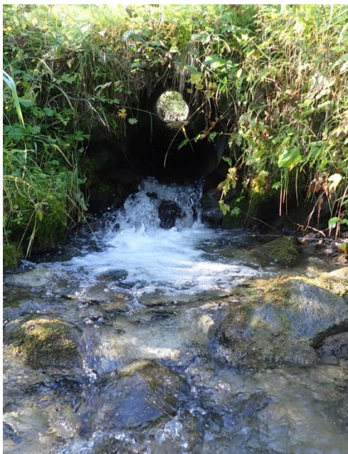
Foto 8: Vandringshindrende veikulvert i tilløpsbekken til Vikelva (t.v.), og partier i bekken ovenfor veien (stasjonsområde 6). Foto: NINA
