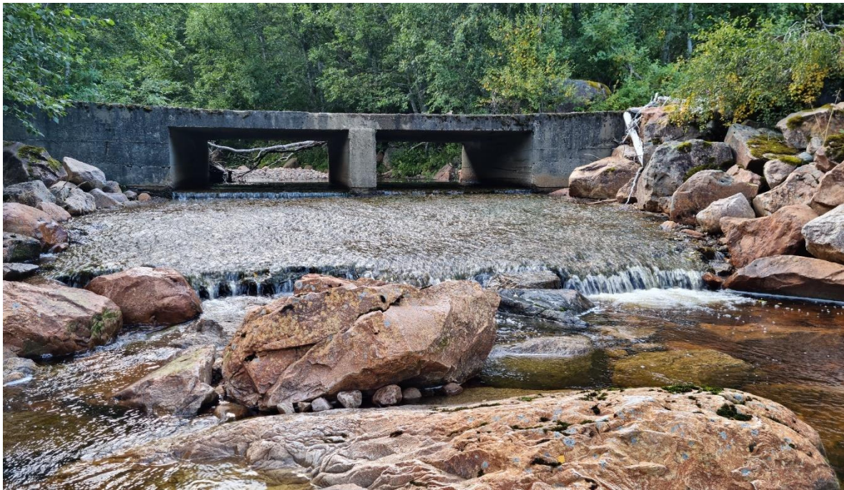
Bilde 8. Kulvert der Skaua krysser Ferjavegen, omtrent 50 meter fra bekkens samløp med Ferja. Foto: Eva M. Ulvan, NINA.
