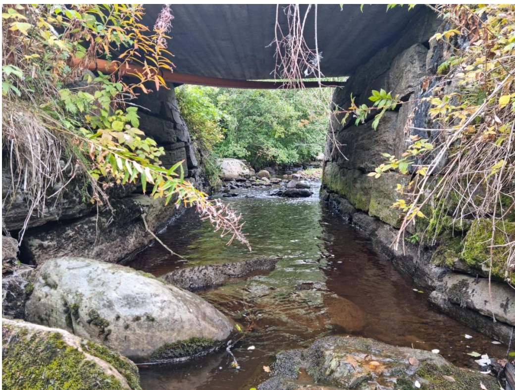
Bilde 14. Brustuelva passerer Brustuvegen under en bru med intakt elvebunn, omtrent 2,7 kilometer fra samløpet med Ferja. Løsningen er god for fiskevandring Foto: Eva M. Ulvan, NINA.
