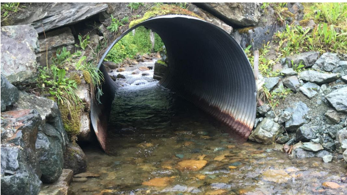
Bilde 14. God løsning. Veikulvert med bevart bekkebunn og noe innsnevring av opprinnelig vassdragsløp. Foto: Morten Andre Bergan, NINA.
