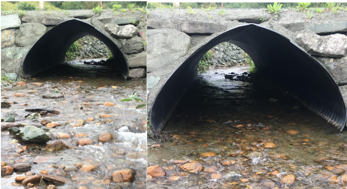
Bilde 13. Optimal løsning. Veikulvert med bevart bekkebunn og ingen innsnevring av opprinnelig vassdragsløp. Foto: Morten Andre Bergan, NINA.
