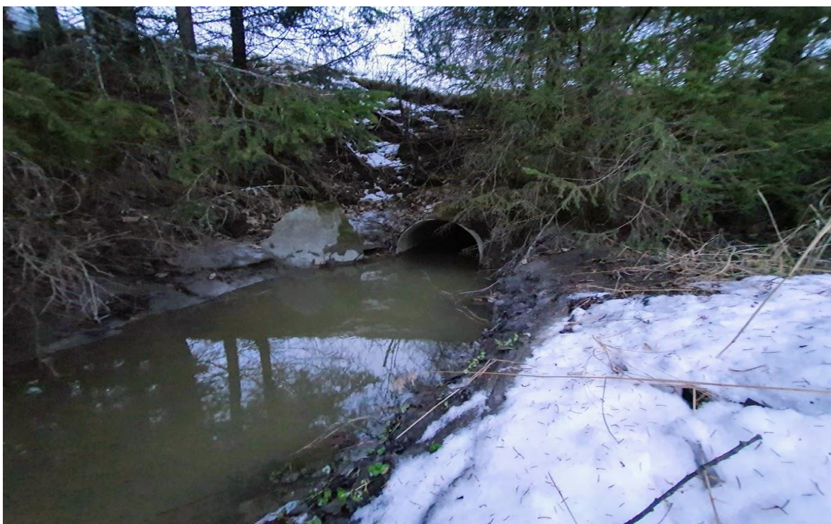
Bilde 12. Kulvert under traktorvei ca. 200 meter oppstrøms Valsetvegen. Foto: Øyvind Solem, NINA.
