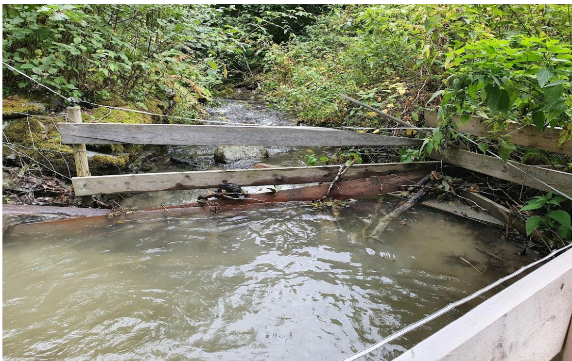
Bilde 6. Gjerde i Kjølvassbekken rett oppstrøms kulvert under avlingsvei fremstod høsten 2021 som et vandringshinder for anadrom laksefisk. Foto: Øyvind Solem, NINA.
