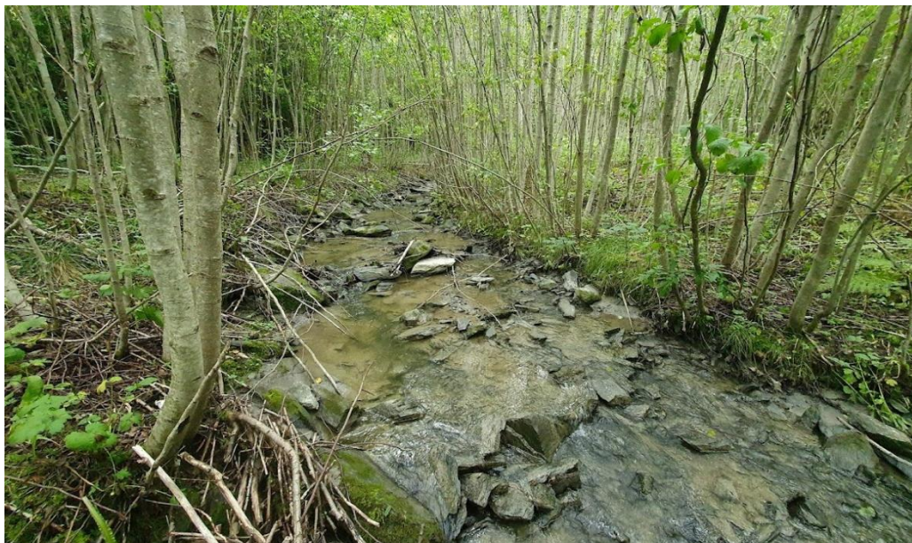
Bilde 10. I andre deler av den erosjonssikrede delen av vassdraget er det brukt finere masser av sprengtstein og disse fremstår som lite egnet både som oppvekst- og skjulområder, samt gytehabitat. Foto: Øyvind Solem, NINA.
