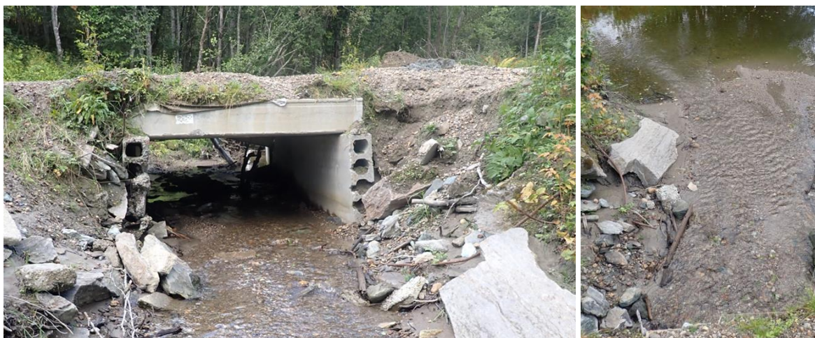
Foto 11: Ormlibekken munner til Slettenelva under grusvei i kulvert med bevart bekkebunn. Foto: NINA.
