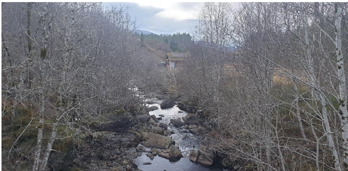
Bilde 12. Rodalselva med kraftstasjonen i bakkant på bildet.
