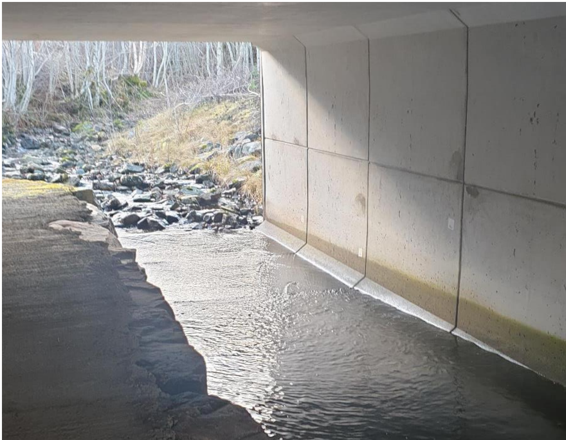
Bilde 8. Utløpsområdet til Vinjefjorden ligger rett nedstrøms vegkrysningen til E39 og har tilstrekkelig vannspeil for oppvandrende fisk.
