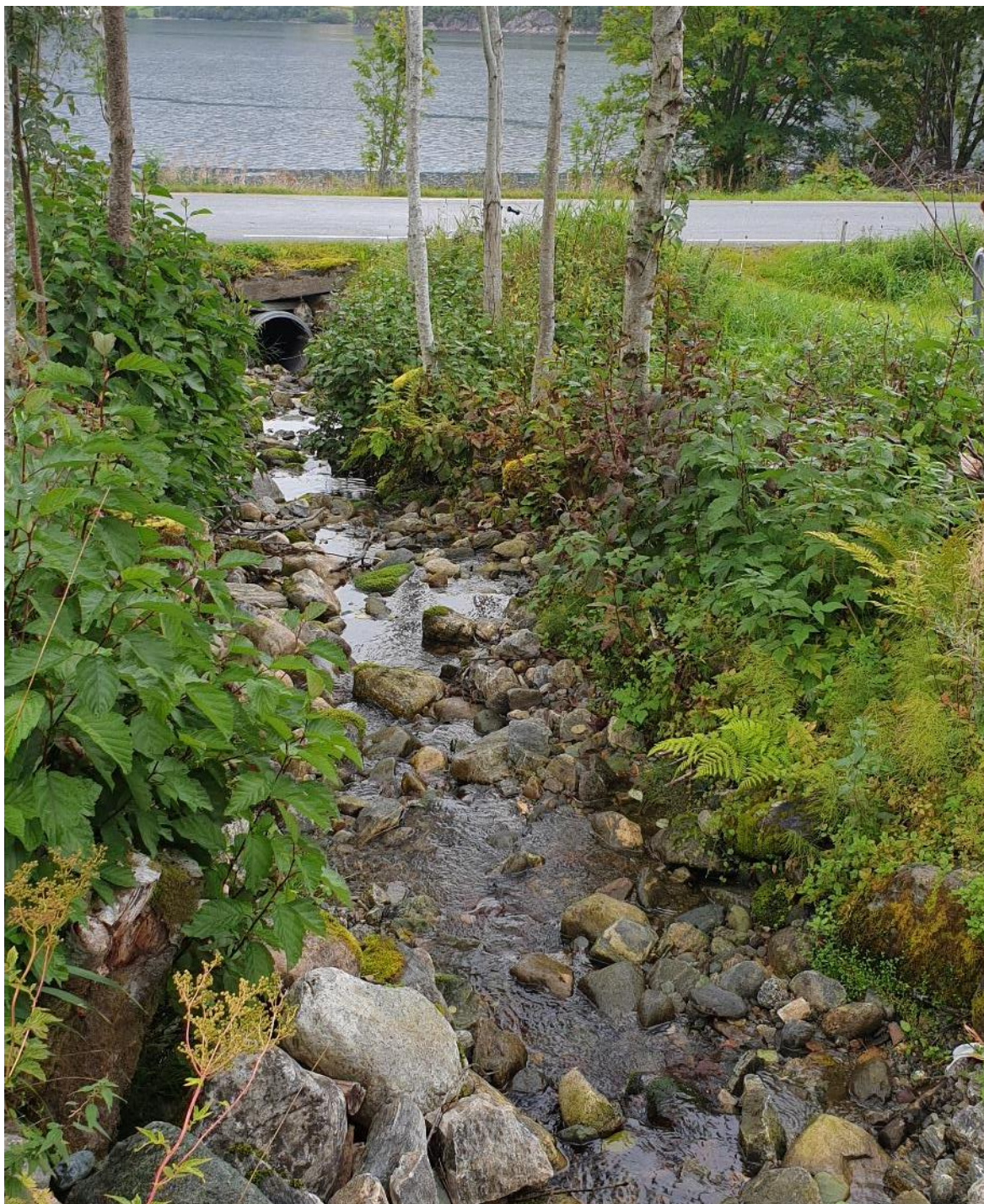
Bilde 35. Bilde tatt nedstrøms mot kulvert under riksveg 6182.
