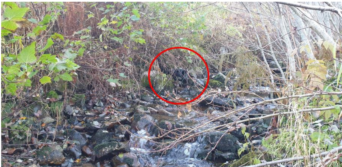
Bilde 71. Rør ut fra bolighus i området det ble registrert sterk kloakkluft.
