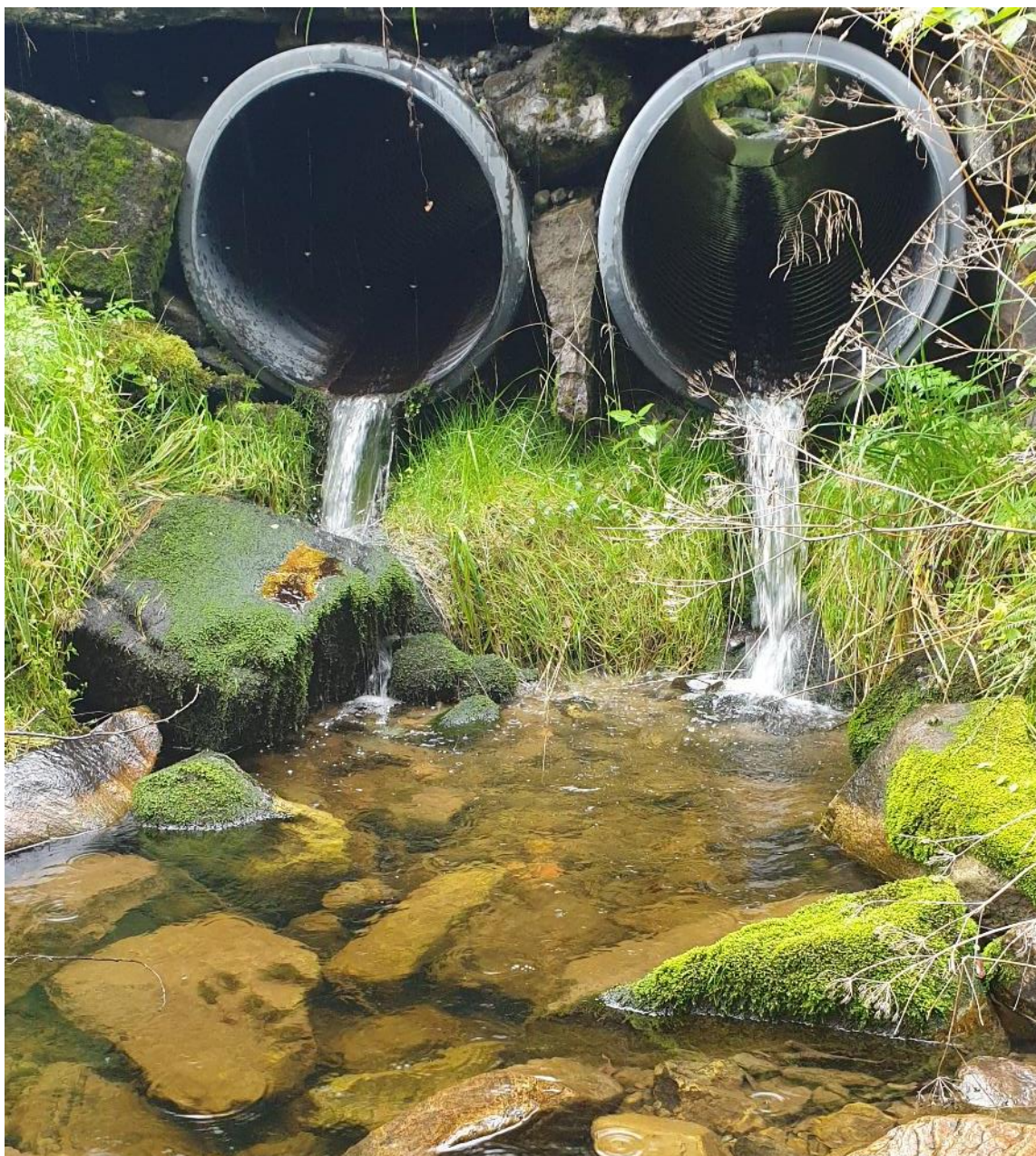
Bilde 34. Vandringsbarriere ved vegkryssingen av Valsøyfjordveien (RV6182).
