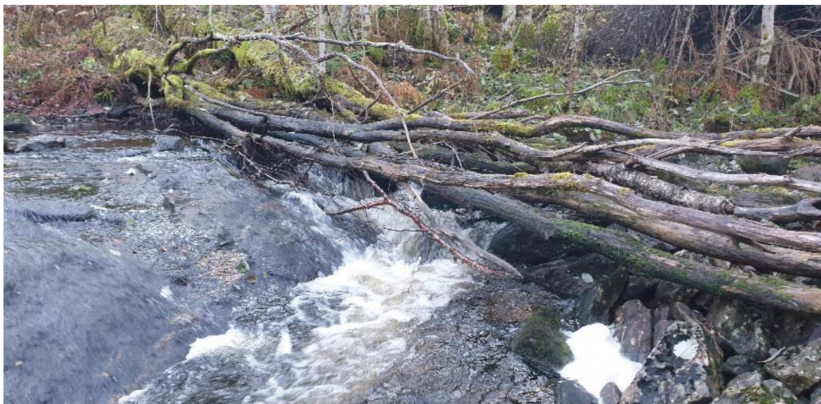
Bilde 62. Kvist og kvast som hadde lagt seg opp i den naturlige oppvandringsruten til fisk. Kan være til hinder ved lav vannstand da elva delvis renner over bart fjell på dette punktet.
