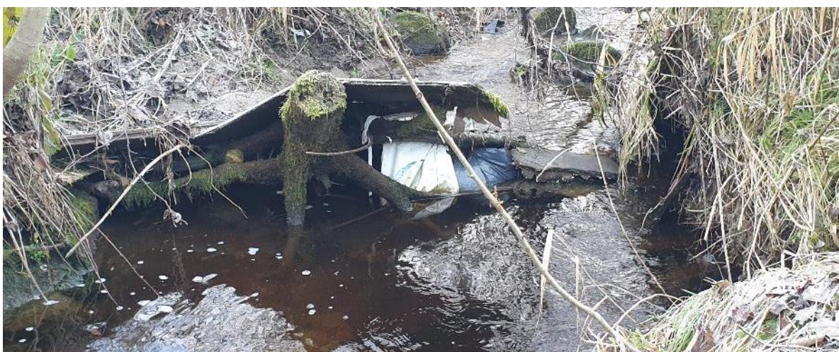
Bilde 87. Bygningsplate og søppelsekker med avfall som sperre for bekken. Bildet er tatt rett oppstrøms samløpet i vestre elveløp.
