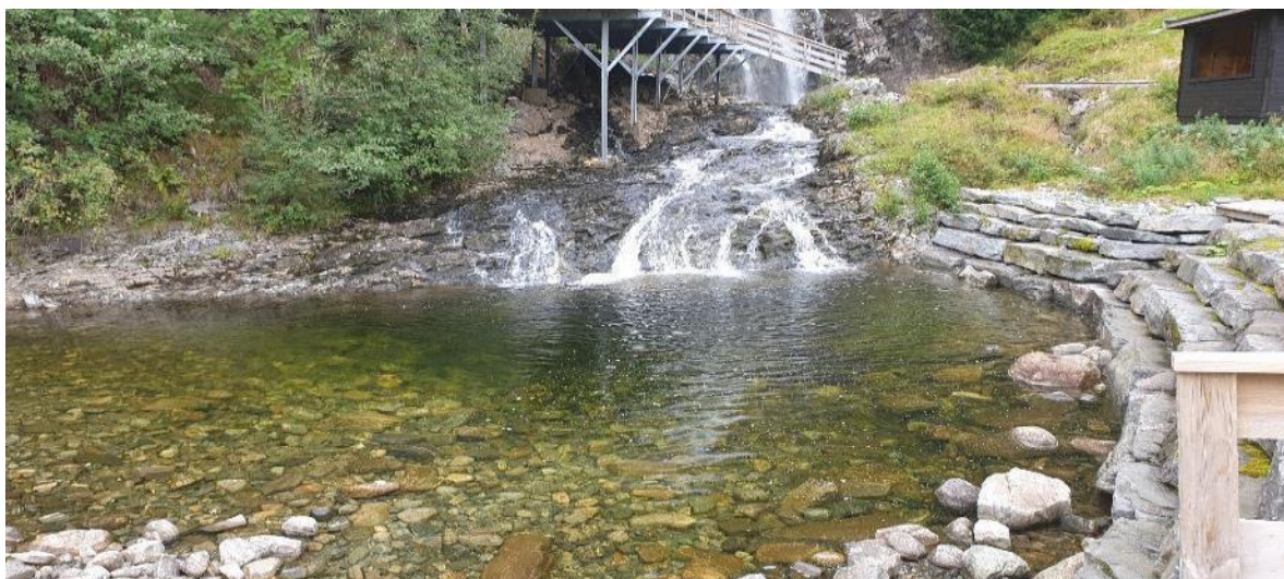
Bilde 23. Fossekulpen nedstrøms naturlig foss i Sandåa som utgjør naturlig vandringsbarriere på anadrom strekning. Fossen og konsertarena sees i bakgrunnen på bildet.
