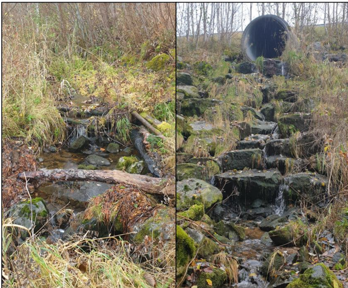
Bilde 11 a-b. Til venstre bekkeløp rett ovenfor flomål og til høyre teoretisk vandringsbarriere rett nedstrøms vegkrysning E39.
