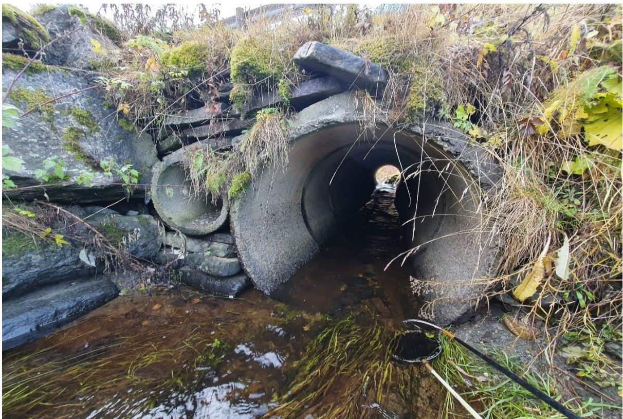
Bilde 3. Kulvert under Fv. 65 i Kjelbekken utgjør ikke et vandringshinder for anadrom laksefisk. Foto: Øyvind Solem, NINA.
