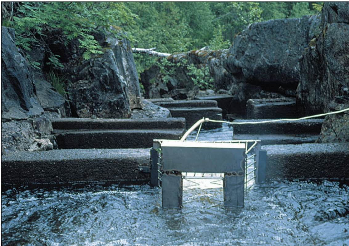
Mekaniske fisketellere plassert i fisketrapper eller trange elveavsnitt, kan telle antallet fisk som vandrer opp. Foto: Roar A. Lund
