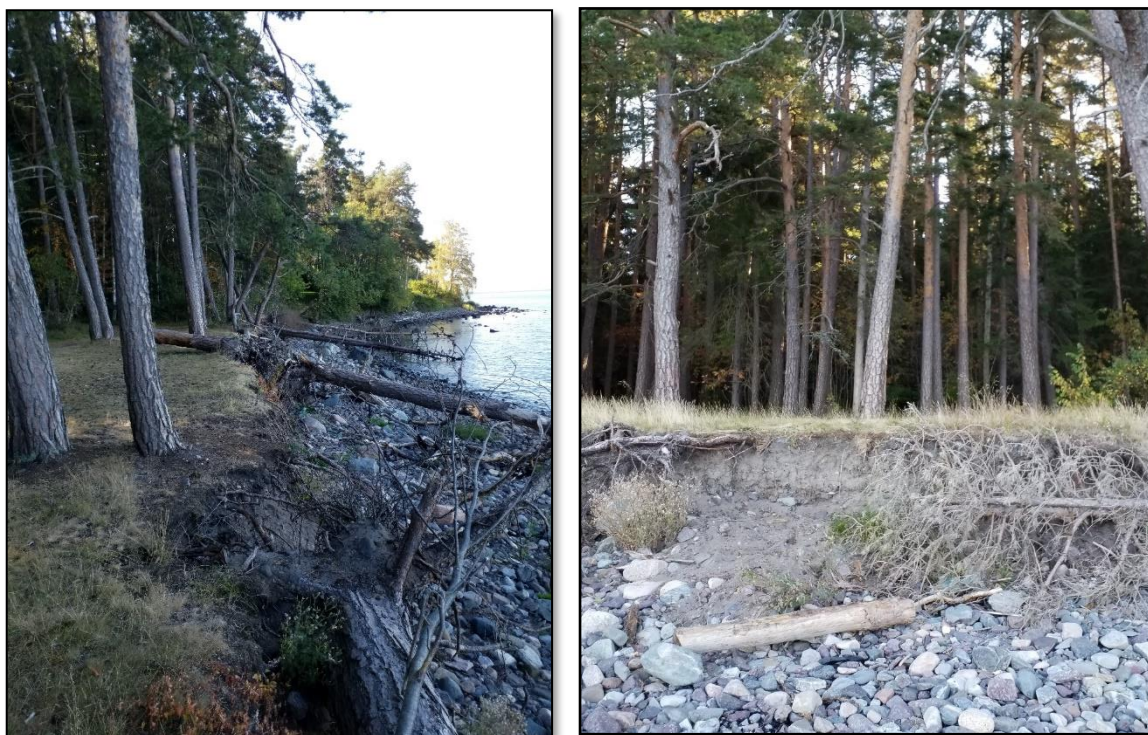
Figur 3.6 Langs erosjonskanten mellom furuskogen og rullesteinstranda ligger store, veltede trær som sperrer for ferdsel langs stranda (bilde til venstre). Dersom man kommer kyststier langs stranda fra sør (øverst i bildet), må man krysse erosjonskanten for å komme opp på stien gjennom Furulunden. Erosjonskanten er sensitiv for tråkk (bilde til høyre).
