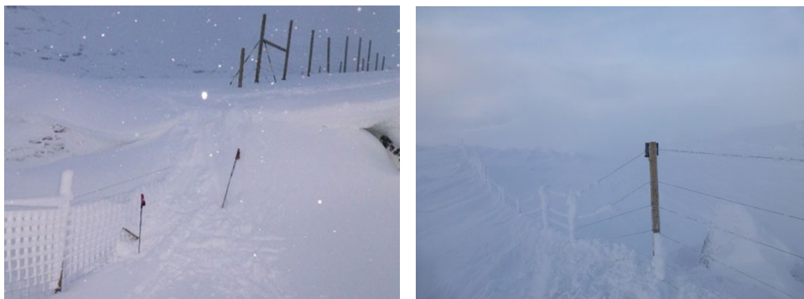
Figur 11. Eksempel på nedsnødd gjerdestrekning (venstre), og strekning hvor gjerdet er mindre enn 1 meter over snøen (høyre) i november 2018. På bilde til høyre vises kamera montert på gjerdestolpe (kamera 12). Snø og is fester seg til både stolper og gjerdenetting, som stedvis kan føre til at vaier fester ryker eller at gjerdenettingen svekkes. Foto: Aron Freyr Gudmundsson.
