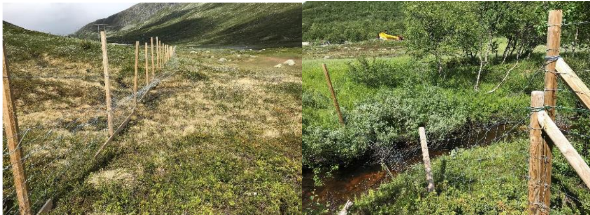
Figur 125. Eksempler på gjerdestrekninger langs rv. 52 hvor nettingen har ligget delvis nede, og krevd vedlikehold. Bilder er hentet fra Høva (2020).
