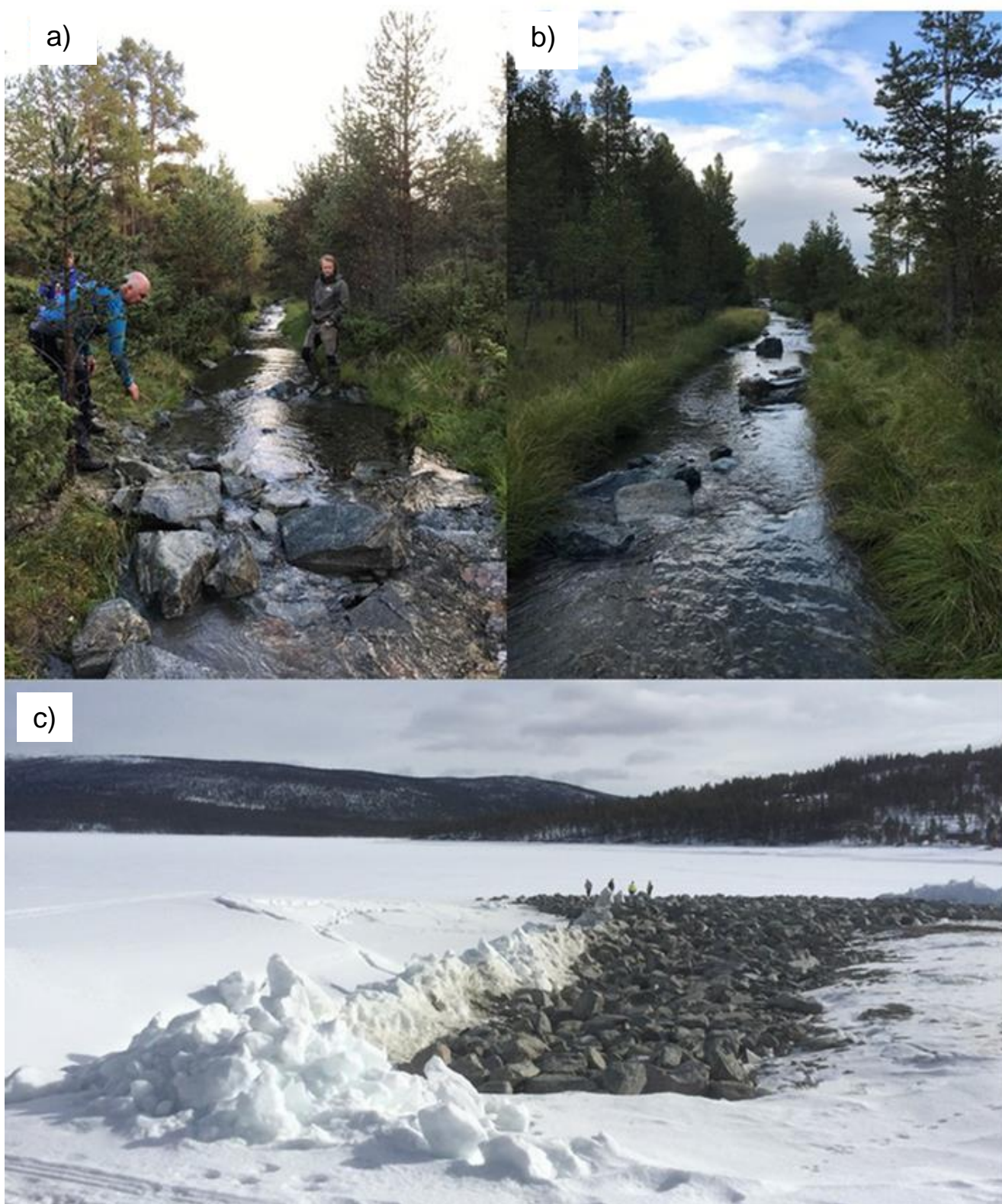
Figur 2.3. Utlagte steingrupper i nedre deler av Lomsjøbekken (a og b), og utlegging av større stein/blokk i reguleringssonen der Lomsjøbekken renner ut i Savalen (c).
