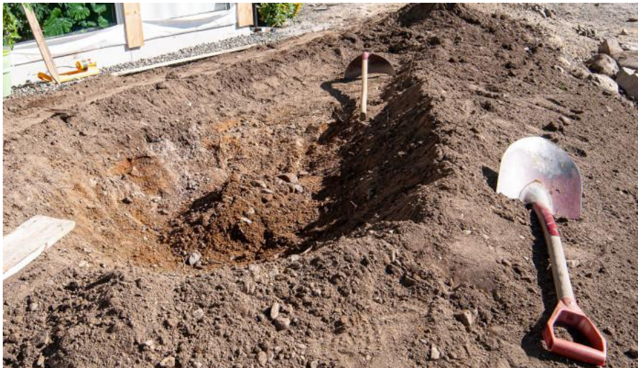
Graving av hagedam. En lang planke brukes med vater for å sikre at alle kantene blir like høye. Foto: Børre K. Dervo
