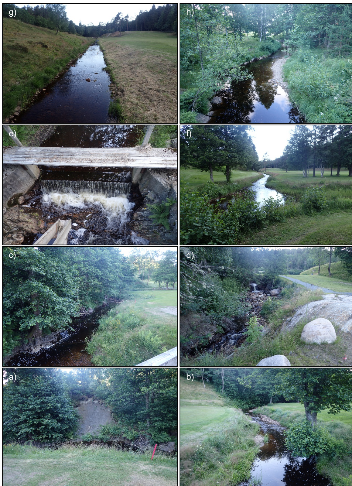
Foto 3.4.4. Nedre del av Marndalsbekken. a) Erosjon av grusmasser. b) Utrettet elvestreng gjennom golfbanen, med lite kantvegetasjon. c) Intakt skog på vestre og golfbanen på østre side av bekkestrengen. d) Strykparti. e) Liten demning. f-g) Golfbanen. h) Bedre kantsoner. Fotografi a-h) er tatt fra nederst til øverst i bekken.
