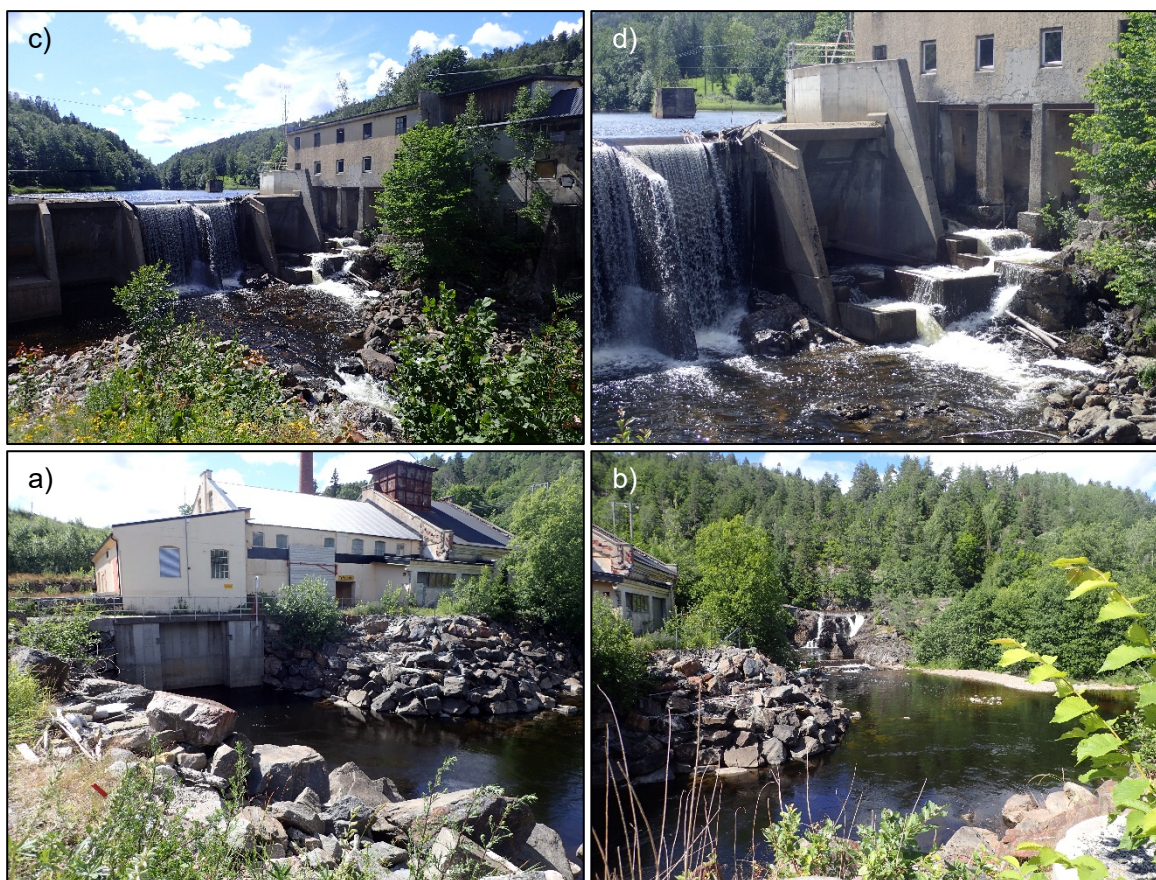
Foto 2.4.5. Storelva ved Fosstveit. a) Kraftverk med kjøringssport. b) Nedre demning. c) Øvre demning. d) Fisketrapp.
