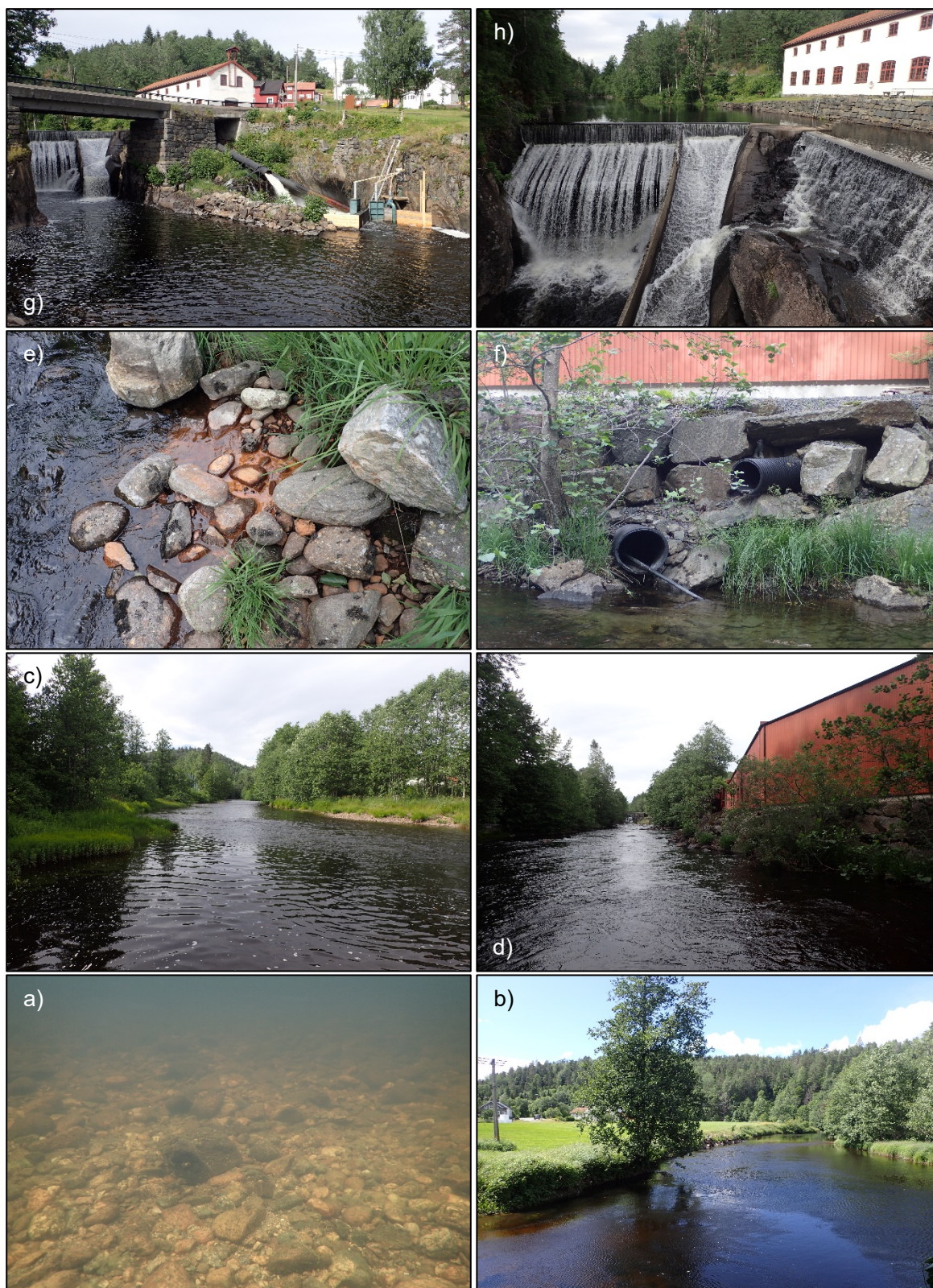
Foto 2.4.8. Storelva fra Strengselva til Nes Verk. a) Elvebunn med lite variasjon. b) Jorde. c) Relativt bred kantsone ved Lunden idrettsplass. d-f) Utløp i forbindelse med næringsbygg i Nesgrenda. g) Fiskeheis ved demningen ved Nes Verk. h) Demningen ved Nes Verk. Foto a-h) er tatt fra nederst til øverst i delområdet.
