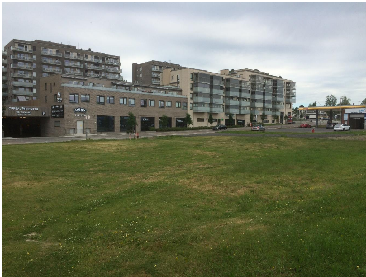
Figur 2. Oppsal senter og plenareal mellom Håkon Tveters vei og T-banelinjen (Østsjøbanen). (Planlagt utbygd for omsorgsboliger til nye Oppsal sykehjem)
