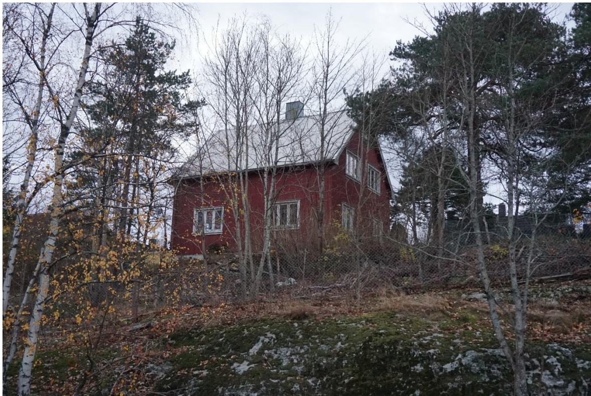
Figur 5. Fjellet, Oppsalveien 20 B, tidligere arbeidsbolig for Oppsal gård.
