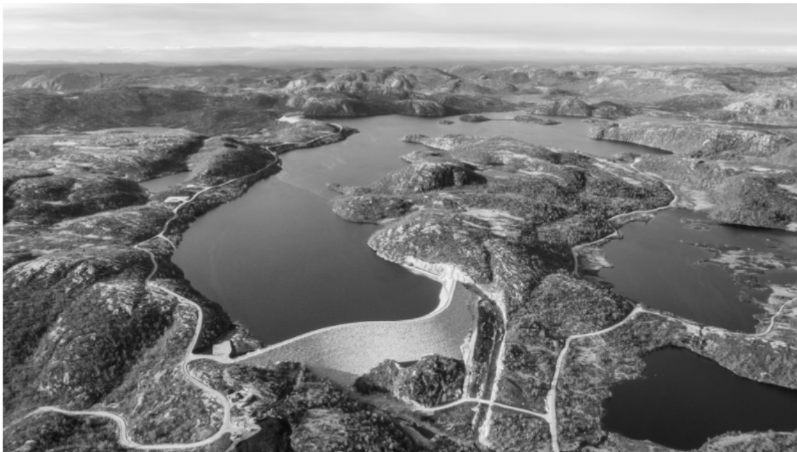
Oversiktsbilde av det nye Nåvatn-Skjerkevatnmagasinet. Kilde: AEVK
