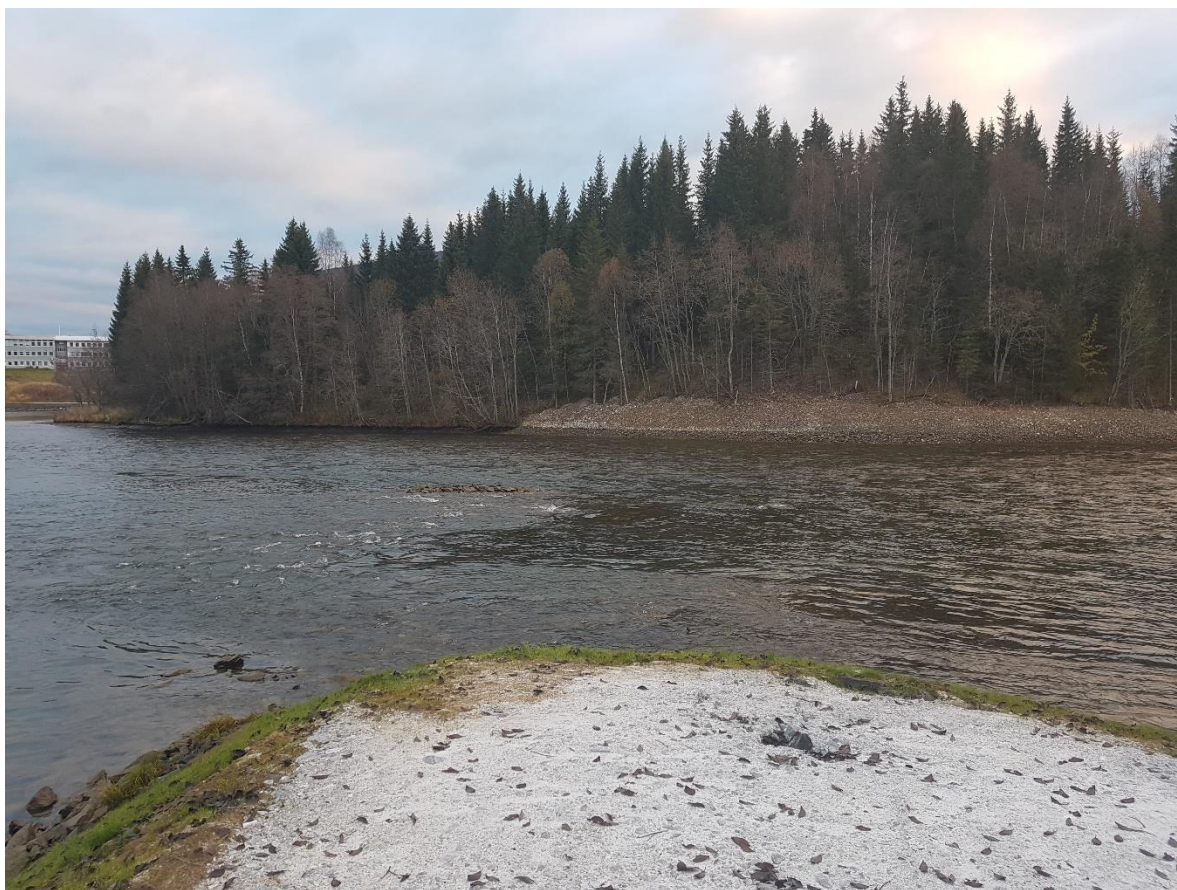
Bilde 5. I 2016, 2018 og 2020 ble det gjennomført inventering av hele tiltaksområdet i Røssåga mellom det nye og det gamle kraftverksutløpet (til venstre i bildet). Foto: Marius Berg.
