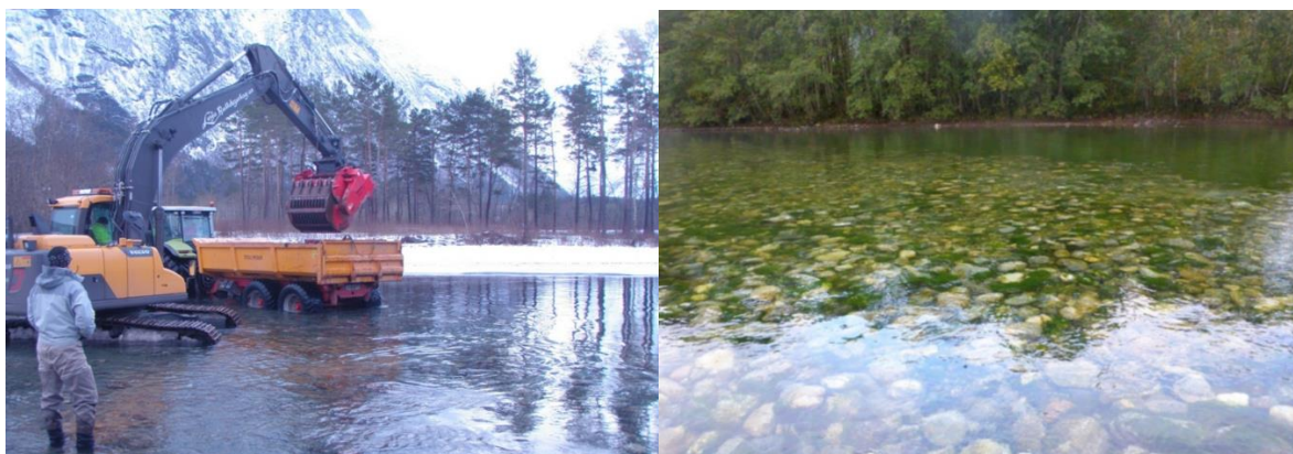
Bildeserie 9. Et mulig vedlikeholdstiltak i tiltaksområdet i Røssåga er fjerning av finsedimenter med sorteringsskuffe etter samme modell som i Eira. Foto: Nils Arne Hvidsten (venstre bilde) og Jan Gunnar Jensås (høyre bilde).
