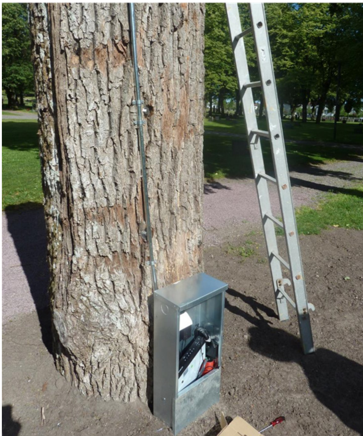
Figur 22. Ferdig montert videoovervåkingsutstyr med kabelskap, opptaksenhet, kabelskinne med kabler til 2 stk HD 600TVL 1/3" CMOS 6mm IR kamera. Foto: Anders Endrestøl.
