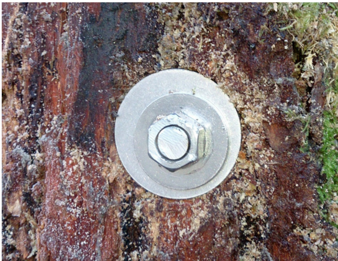
Figur 10. Hele 11 gjennomgående gjengestenger holder eikestokken sammen, to under bakken og ni over. Bildet er tatt 26. november 2014. Foto: Magne Flåten.
