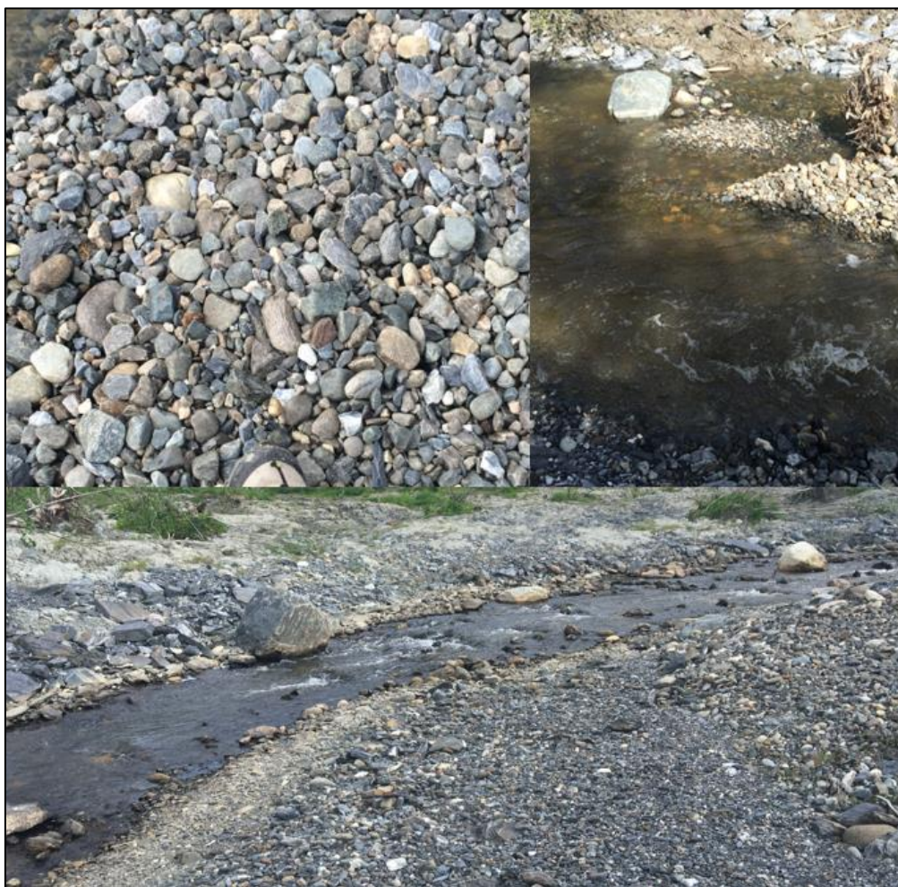
Figur 60. Utstrakt tilførsel av naturlig, rund elvestein i gytestørrelser for sjøørret i restaurert strekning av Hofstadelva. Foto: Morten Andre Bergan, NINA.
