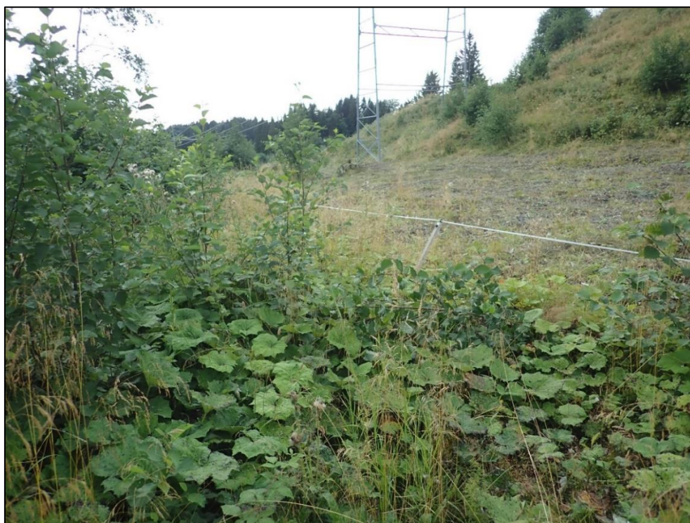
Figur 72. Bildet er tatt fra segment 2B, hvor et oppsatt strøm-gjerde holder storfe ute fra den delen av segmentet som ligger mot elva. Det er tydelig forskjell på vegetasjonsdekningen innenfor og utenfor gjerdet, men høy og tett vegetasjon i området som ikke påvirkes av storfe. Foto: NINA.
