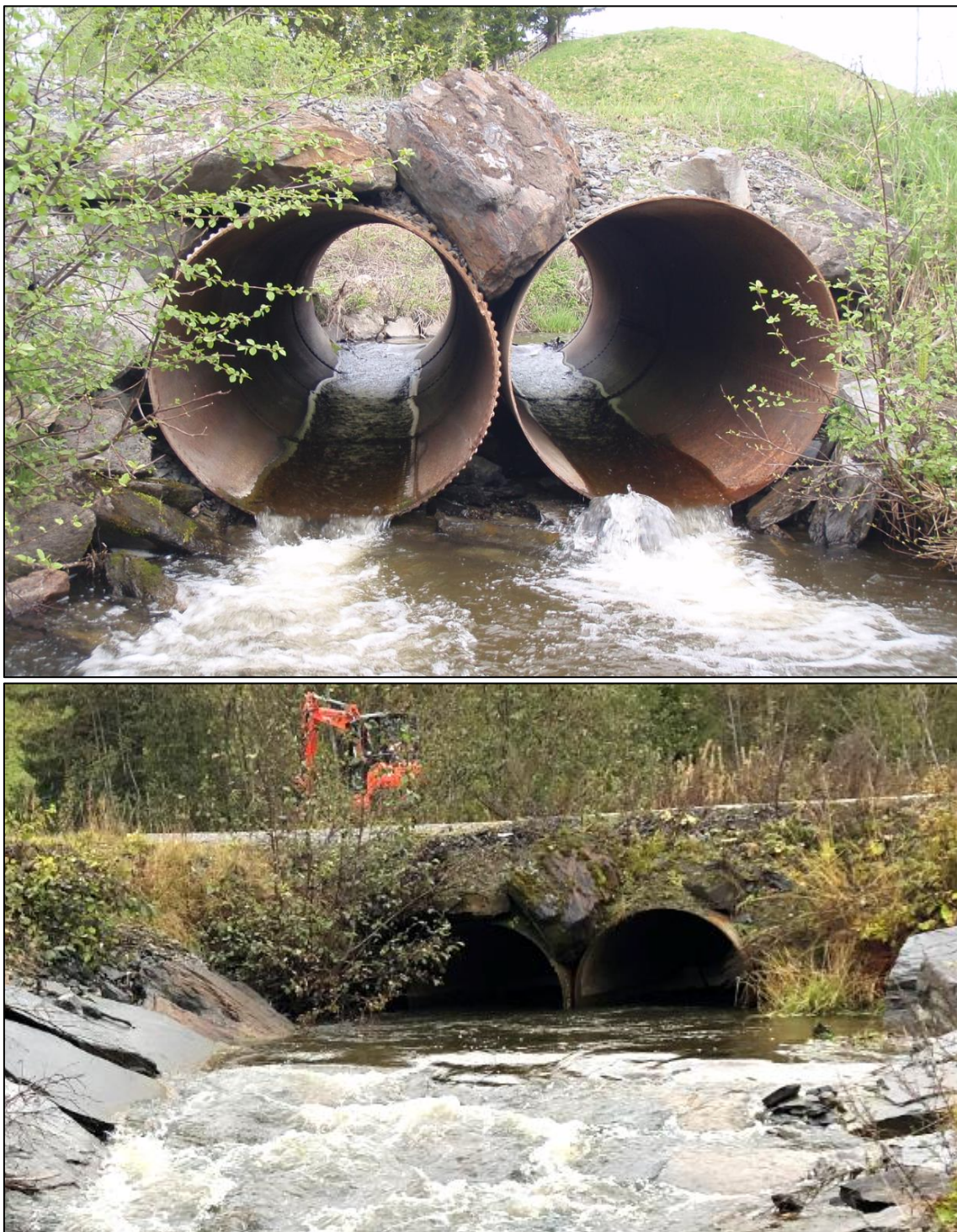
Figur 53. Den tidligere problemkulverten i Hofstadelva i 2011 (øverst, før utbedring) og 2018 (nederst), etter utbedring. Vannspeil nedstrøms ble vesentlig hevet, og gir nå oppgangsmuligheter for både gytefisk og ungfisk, på et langt større vannføringsvindu sammenlignet med tidligere. Foto: Morten André Bergan, NINA.
