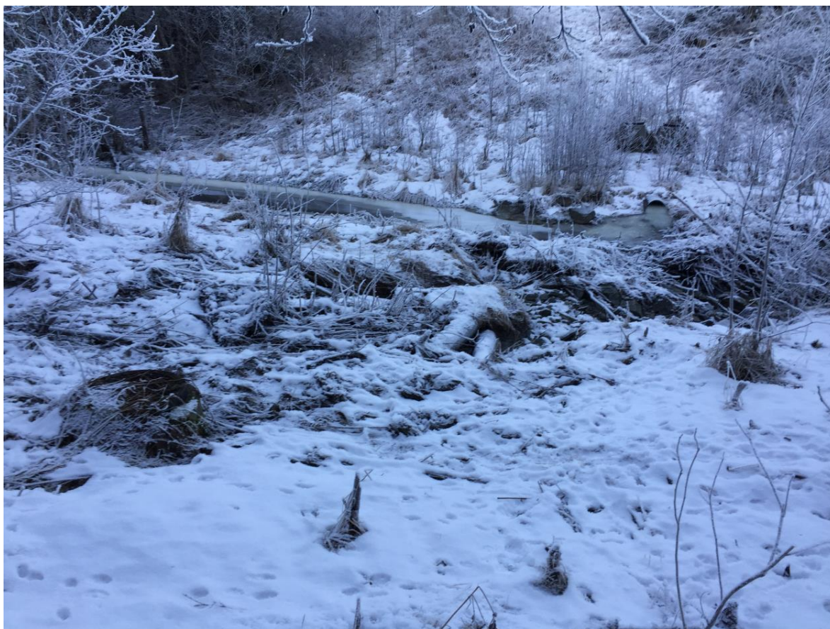
Figur 59. Bildet fra Trondheim kommunes befaring 06.01.2021. Vannivået er godt under nivået av demningens topp (som for den andre demningen), noe som tyder på at demningen er forlatt og ikke lenger vedlikeholdt. Foto: Trondheim kommune.
