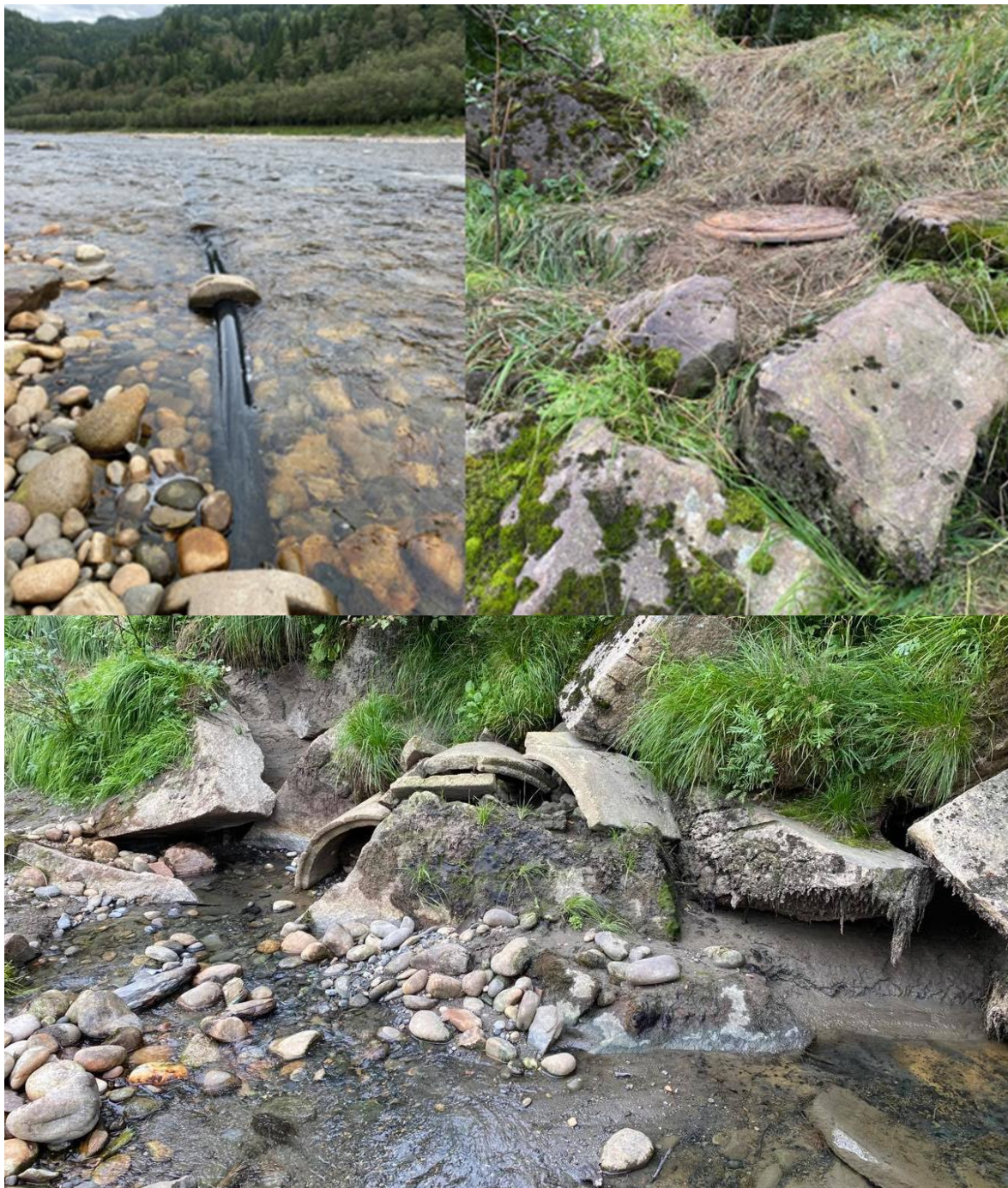
Figur 24. Øverst: Rørledningen som fører utslipp til Gaula (t.v.) og pumpekum ved elvebredden (t.h.). Nederst: Punktet nedstrøms kum, hvor utslippet rant ut i Enganbekken. Foto den 28.08.2020. Foto: Morten André Bergan.
