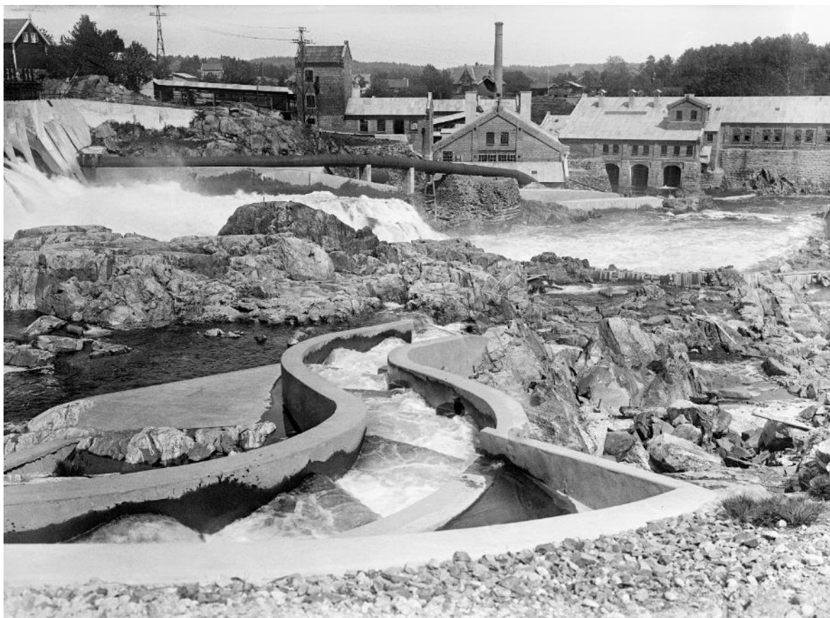
Bilde 19. Det ble etablert en fiskepassasje ved Rygene kraftverk allerede på 1890-tallet, for at sjøvandrende laksefisk skulle kunne passere dammen. Foto: Hartvig Huitfeldt-Kaas.
