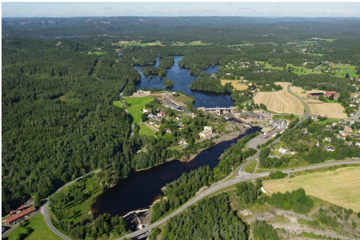
Bilde 13. I Nidelva ble det i august 2019 gjennomført elektrisk båtfiske på 27 stasjoner fordelt på elvestrekningene oppstrøms og nedstrøms Rygene kraftverk (flyfoto). De tre nederste stasjonene (se vedleggsfigur 11 ) oppstrøms Rygene kraftverk er lokalisert i øvre del av flyfotoet. Flyfoto: Agder Energi AS.
