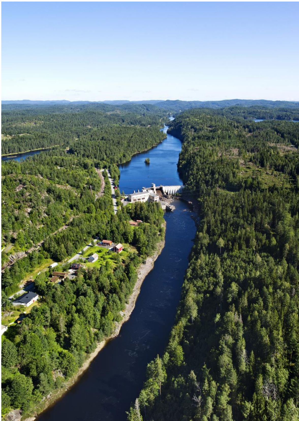
Bilde 20. Eivindstad kraftverk er et elvekraftverk som ligger i den lakseførende delen av Nidelva. Under elektrisk båtfiske i august 2019 ble det fanget bare én laksunge på en 440 meter lang stasjon nedstrøms kraftverket. Flyfoto: Agder Energi AS.
