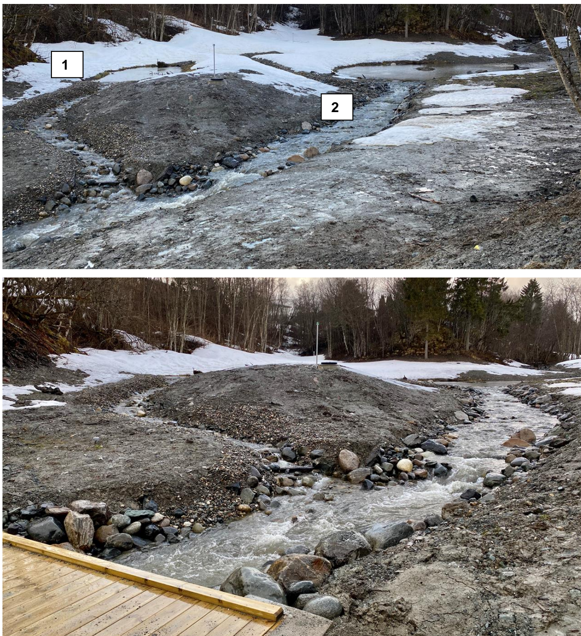
Figur 30. Øverst: Egen atskilt dam i tilsigsbekk (1) parallellt med hovedløpet til Uglabekken (2). Nederst: Samme parti som øverst. Foto ved gangbru. Foto fra april 2020. Foto: NINA.
