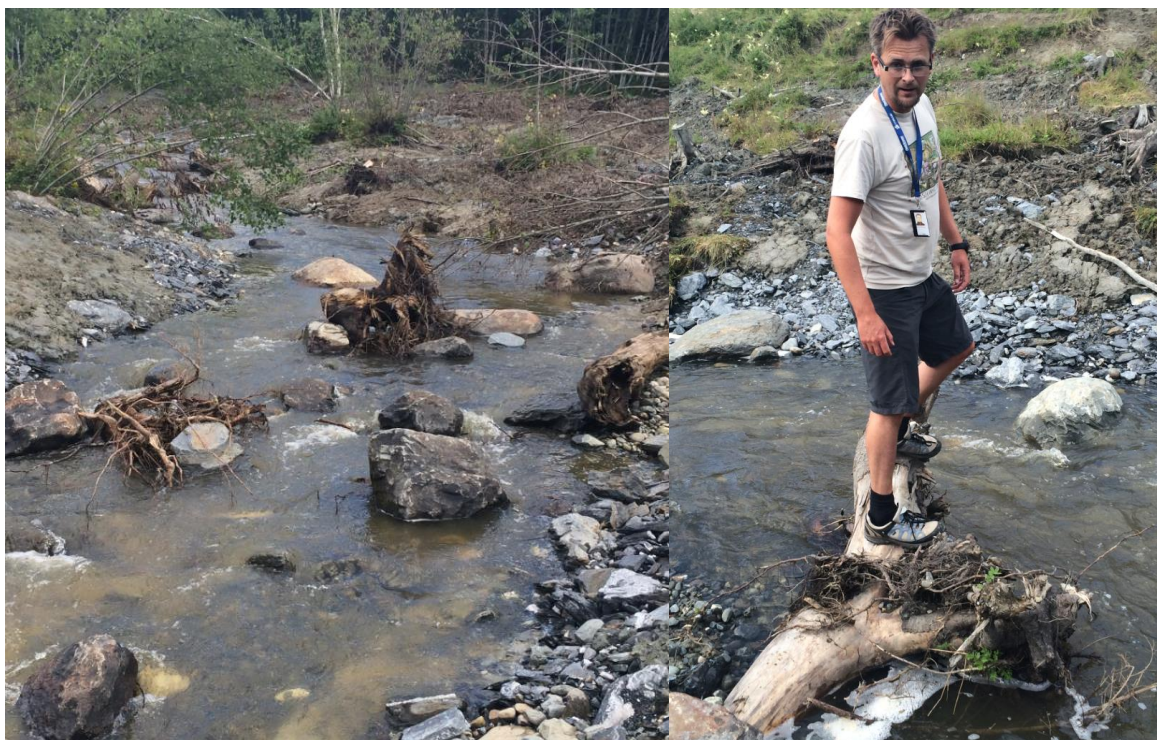
Figur 18. Utlegging og forankring av røtter i kombinasjon med storstein i Hofstadelva, Stjørdal. Foto: NINA.
