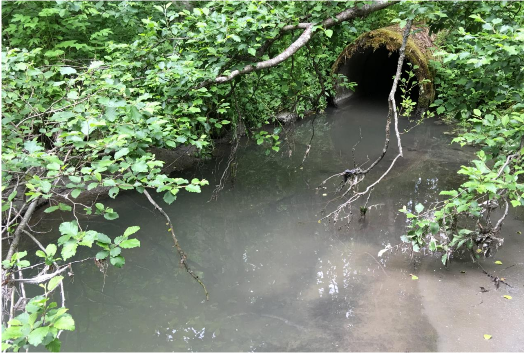
Figur 22. Svært blakket vann, rester av sanitært avfall og markant lukt av kloakk i Uglabekken etter lukket strekning ved Bekkefaret i 2016. Foto: NINA.
