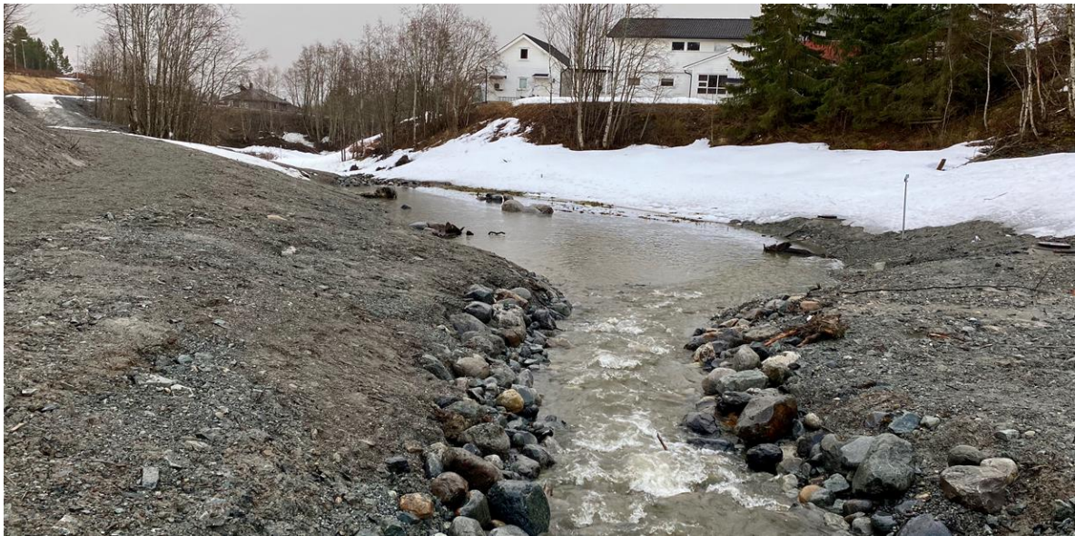
Figur 28. Nyåpnet og restaurert strykstrekning ned mot utposning og dam i Uglabekken. Storstein i klynger og rotsystemer forankret langs sidene av dammen. Foto fra april 2020. Foto: NINA.
