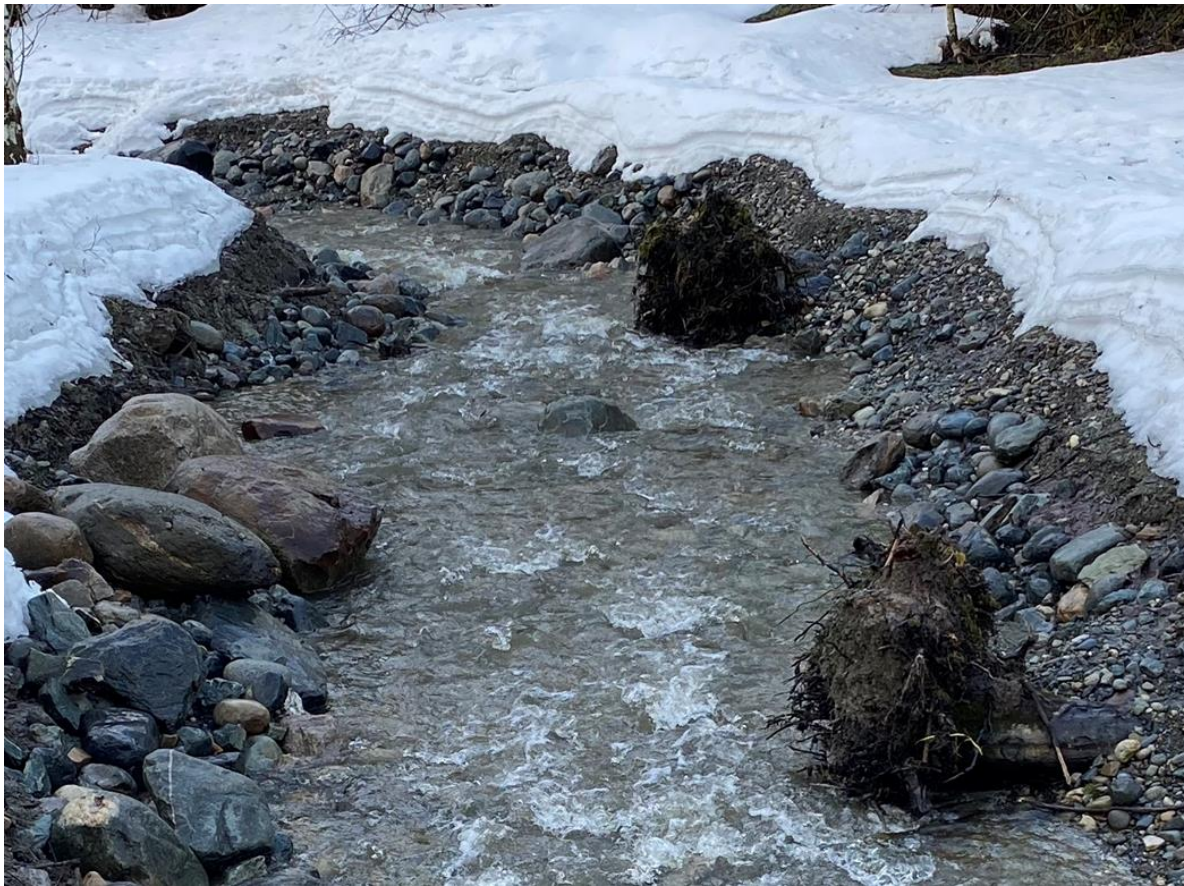
Figur 26. Nyåpnet og restaurert strykstrekning i Uglabekken. Storstein i klynger og rotsystemer forankret langs bekkesidene. Foto fra mars 2020. Foto: NINA.
