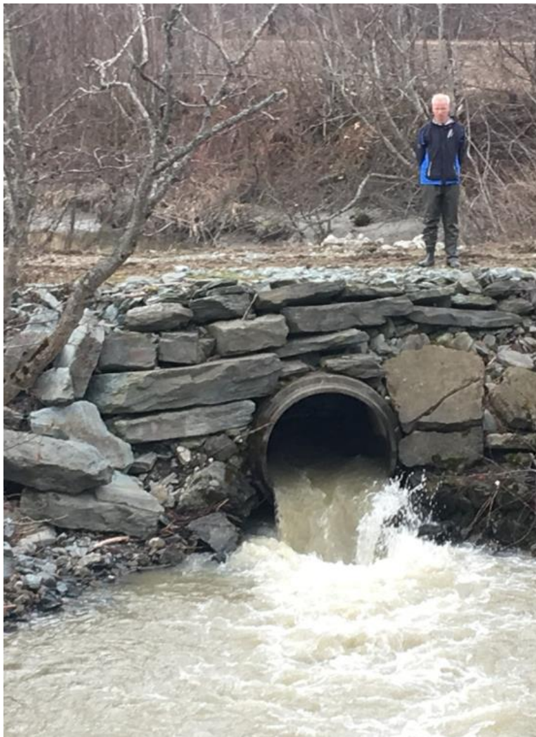
Figur 3. En underdimensjonert betongkulvert under eldre traktorvei (t.h., foto t.h.) stenger i enkelte år for oppvandring av sjørret, dersom optimal vannføringen uteblir før gytetidspunktet. Foto: NINA.
