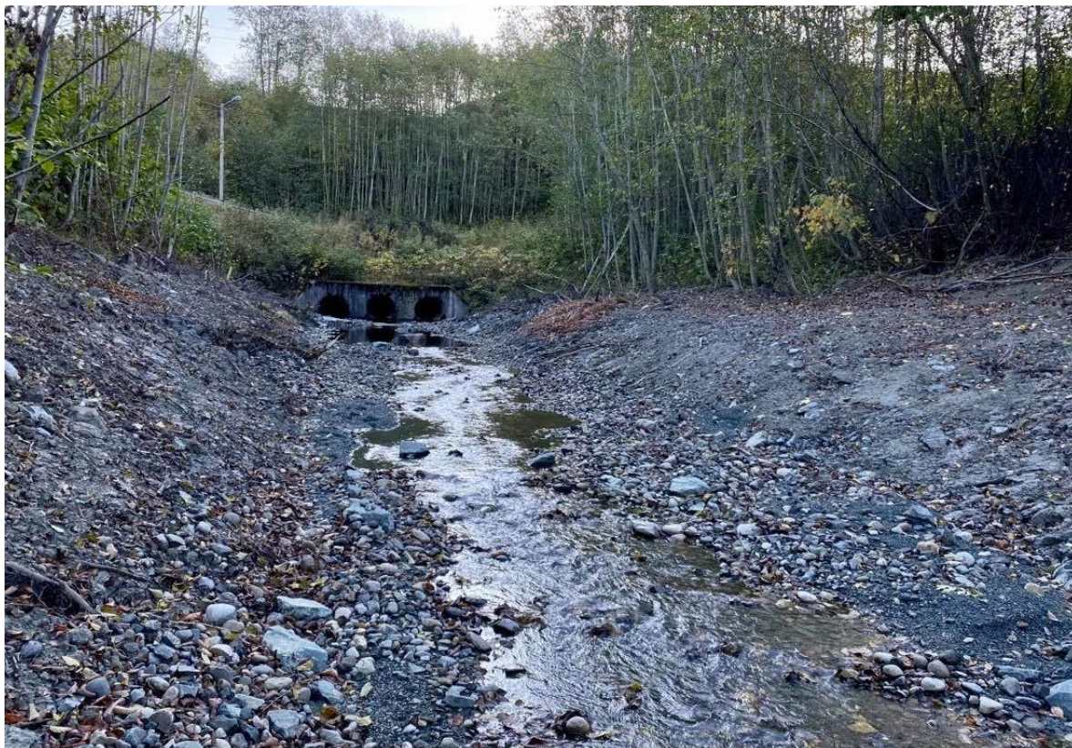
Foto 1: Foto opp mot kulp nedstrøms lukking under Stokkgjerdsveien og jernbane i Langbekken. Denne bekkestrekningen er steinsatt og sikret for ras i løpet av 2020. Stasjon 4e utgjør deler av strykstrekningen og kulpen øverst i bildet. Foto fra 6.oktober 2020. Foto: NINA
