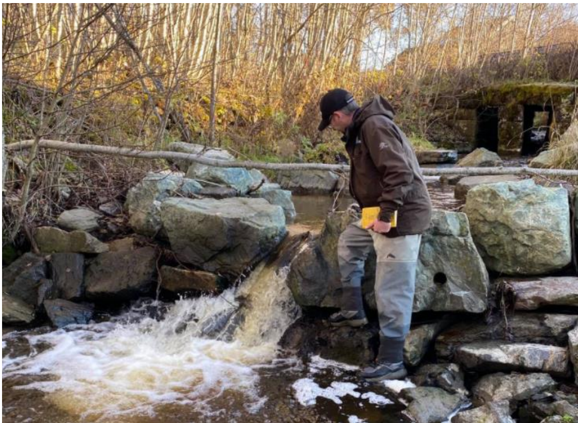
Figur 38. Terskler nedstrøms stikkrenne under jernbane i Lynga. Fotografi tatt i oktober 2020. Foto: NINA
