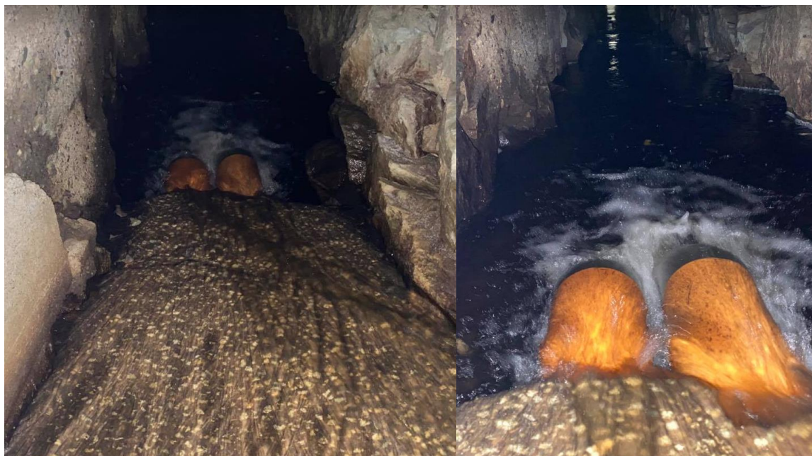
Figur 12. Inne i stikkrenna slutter asfalt/betongbunnen og går over i et parti med mer bevart bekkbunn, større vanndybde og lavere vannhastighet. Vandrende sjørret må hoppe opp i overgangen mellom bekkbunn og asfalt/betongbunn, og svømme over mange meter med lav vanndybde og høy vannhastighet. Foto: NINA
