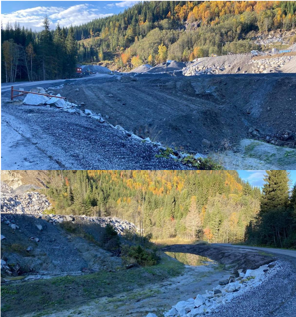
Figur 61. Sandbekken like nedstrøms delvis bekkelukking parallelt med Moe steinbrudd. Foto: NINA.
