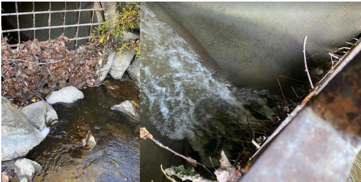
Figur 20. Rister foran jernbanekulvert var tett høsten 2020, og oppgang for gytefisk var stengt. Rista må fjernes. Foto: NINA.
