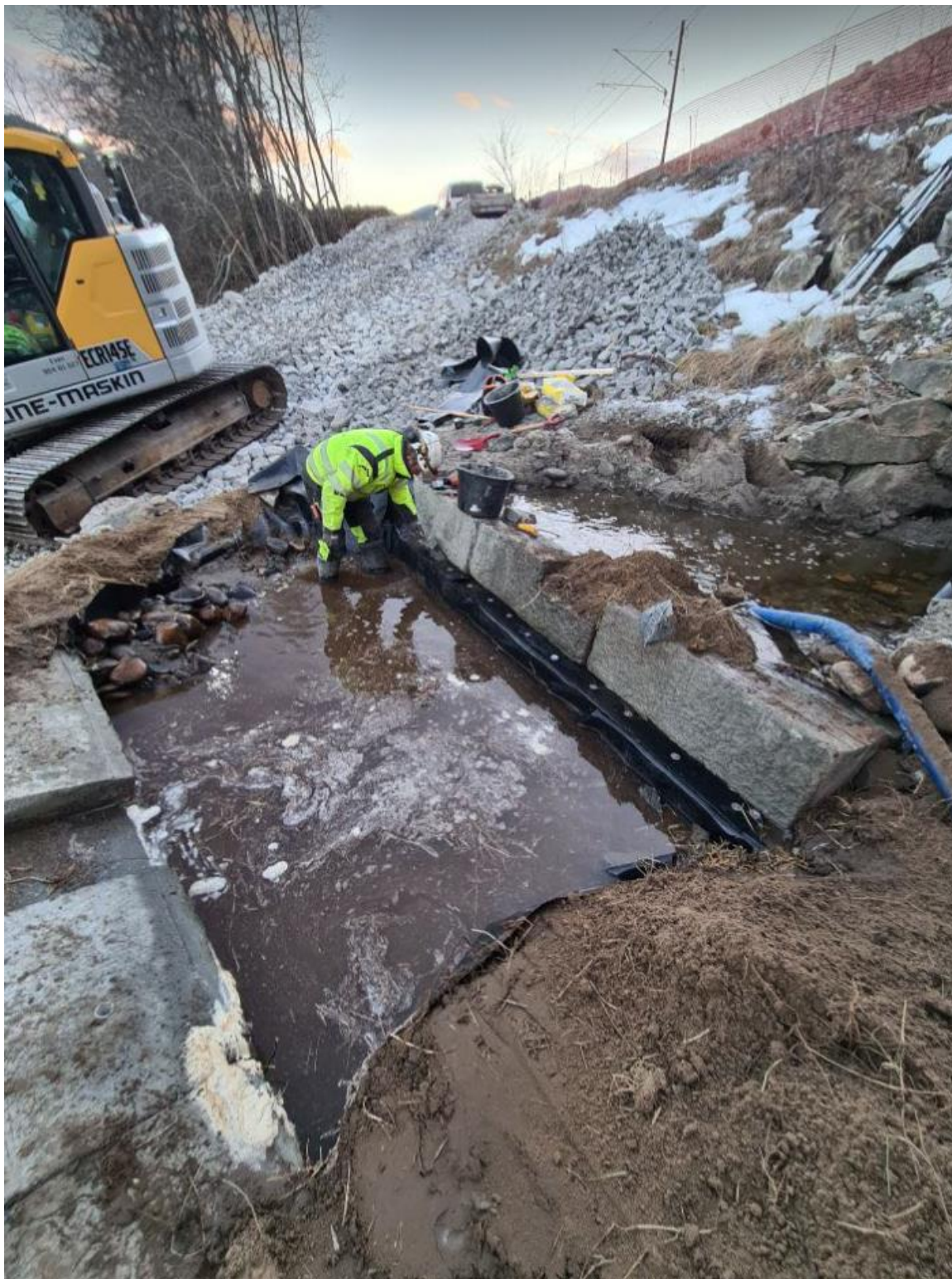
Figur 47. Det er iverksatt utbedring av fiskepassasjen i munningsområdet for Ørbekken til Gaula høsten 2020. Foto: Torstein Rognes, Gaula Natursenter.
