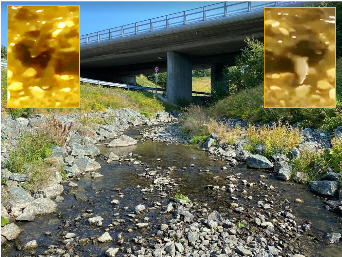
Figur 10. Stasjonsområde 4a i Ratbekken, med screenshots fra video (innfelt) filmet ved nye gyteområder i dette partiet av Ratbekken høsten 2020. Området ble for en stor del ødelagt av anleggsmaskiner like etterpå. Foto: NINA. Video-screenshots: Torstein Rognes, Gaula Natur-senter.
