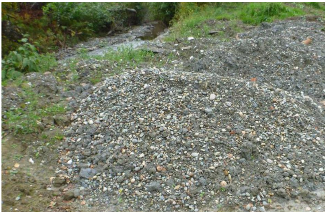
Figur 28. En vesentlig andel naturlig elvestein og -grus ble gravd ut av bekkebunnen til Loddbekken høsten 2013 i forbindelse med sikringsarbeider, og erstattet med grov stein med ukurant form (sprengstein). Solem mfl. (2014) skrev at denne praksisen kan få konsekvenser for bekkens produksjonsevne i årene som kommer. Foto hentet fra Solem mfl. (2014).
