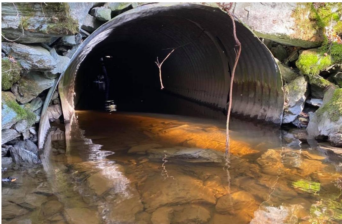
Figur 15. Nedsida av kulverten under Hjellhaugveien er intakt. Foto: NINA.
