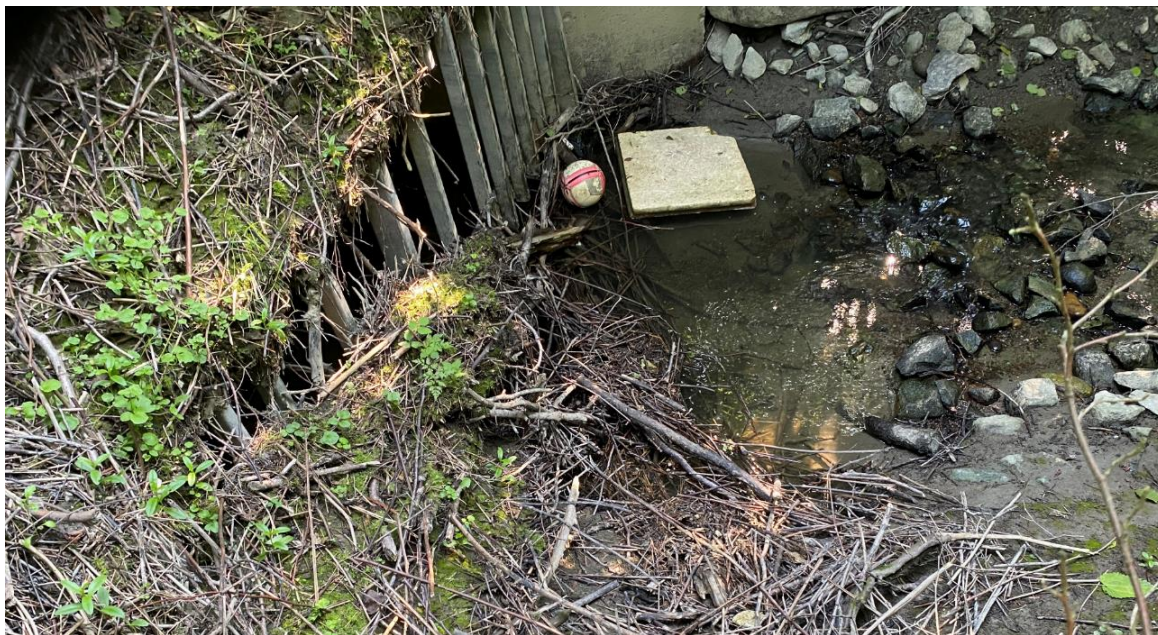
Figur 25. Rister foran veikulverten har nylig fått fjernet vertikale spiler, men går fortsatt svært fort tett, med fare for å danne oppgangshinder for ungfisk og gytefisk fra Gaula. Foto: NINA.
