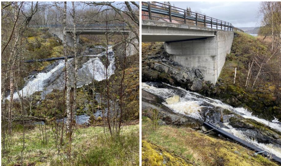
Foto 14. Foss i Mølnargårdselva like nedstrøms Fylkesvei 721, som stopper for oppgang av laks og sjørørret. Foto: Morten André Bergan.
