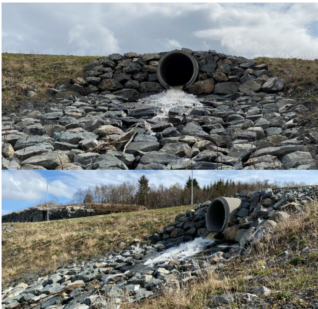
Foto 21. Ny forbygning og kulvert i Klakksbekken ble etablert i forbindelse med anleggsarbeid på Fylkesvei 710. Foto: Morten André Bergan.
