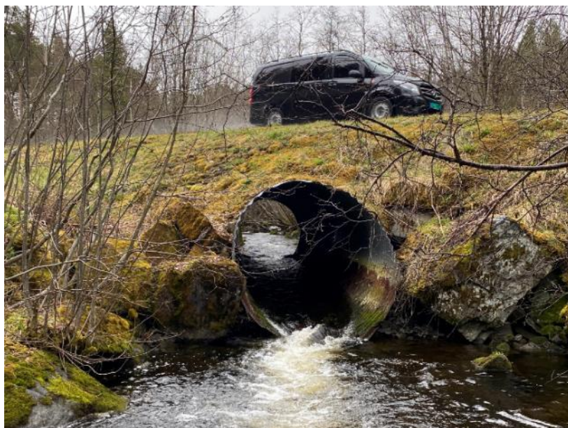
Foto 12. Veikulvert under Fylkesvei 721 i Okla. Foto: Morten André Bergan.
