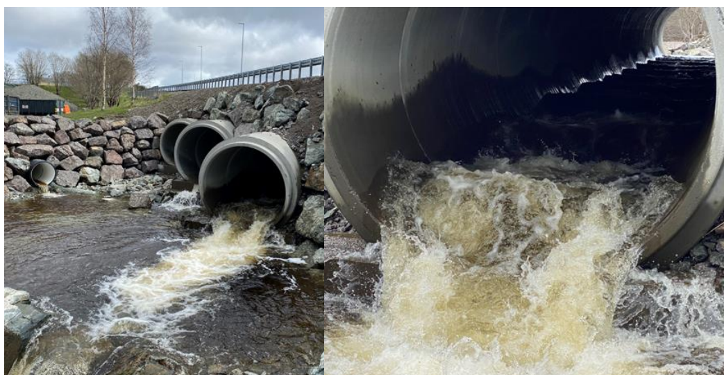
Foto 5. Ny kulvert under Fylkesvei 710. Foto på vannføring over middels. Foto: Morten André Bergan.
