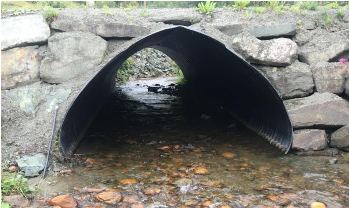
Foto 8. Den nye kulverten i Loa under Lebergsveien er et forbilledlig eksempel på en god løsning på krysning av vei over vassdrag. En slik løsning burde av kostnadmessige og fiskemessige hensyn også ha vært valgt i Botngårdselva. Foto: Morten André Bergan.
