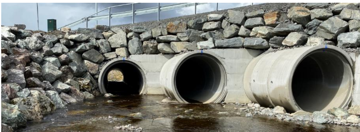
Foto 7. Kulvertingangen (overside av vei) under Fylkesvei 710. Foto: Morten André Bergan.
