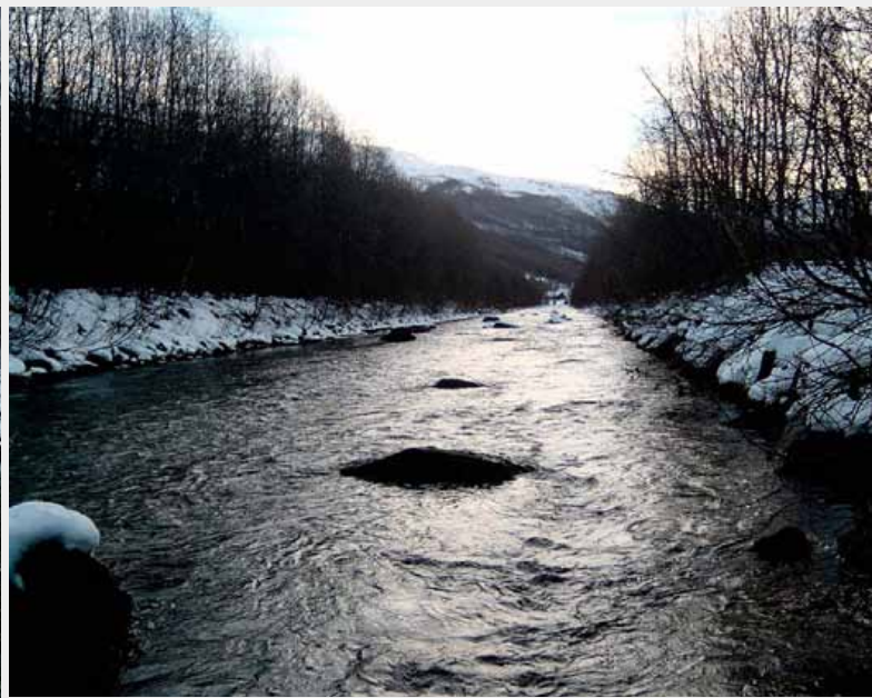
Figur 4. Bildet viser strekningen fra ca. 150 oppstrøms gamlebrua og opp mot gnr/bnr 7/23. Som vi ser er strekningen fullstendig kanalisert. - Another picture of the Bogn river above the old bridge seen in the right hand section of both pictures above illustrating the amount of canalization achieved.
