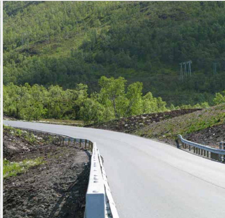
Figur 2. Rigg- og marksikringsplanen satte ytre rammer for anleggsarbeidet, for hvilke arealer som ikke kunne berøres av anleggsarbeidet, og hvilke områder som kunne benyttes. Vellykket vegetasjonstablering gjør at inngrepsskillet etter få år vil være vanskelig å se. - The purpose of the rig and ground securing plan is to avoid damage on important landscape features, cultural heritage and vegetation. Even after just a couple of seasons the demarcation line between the affected and non-affected areas will be indistinct in several areas. Foto/Photo: E. Kongsbakk.
