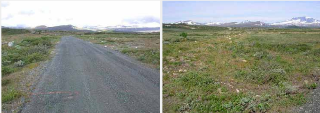
Figur 2. Fra vegstrekning i pilotprosjektet for fjerning av veg. Bildene viser utvikling fra før anlegg i august 2002 til juli 2005. - Test pilot project for removal of 1,2 km of road at Hjerkin. Left photo: August 2002, before construction work. Right photo: same position in July 2005. Foto/Photo: D. Hagen.
