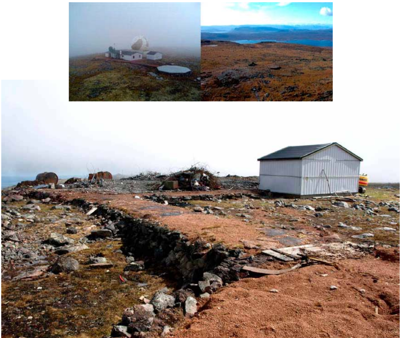
Figur 1. Maissavarre radarstasjon før riving (oppe til venstre), under riving (nede) og rett etter fullført restaureringsarbeid høsten 2008 (oppe til høyre). Foto: Terje Bartholsen (to øverste) og Christian Uhlig (nedre). The military radar installation at Maissavarre before (upper left photo), during removal (lower photo) and after finished restoration efforts (upper right photo). Photos: T. Bartholsen (upper photos) and C. Uhlig (photo below).
