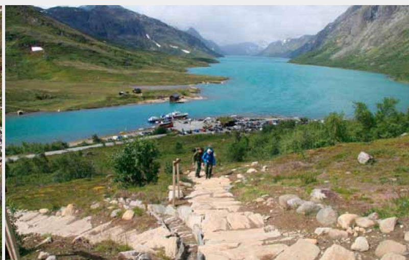
Figur 3. Stein er brukt for å forbedre stiene i området. - Stone and rocks have been used to improve the paths in the area. Foto/Photo: R. Solem.
