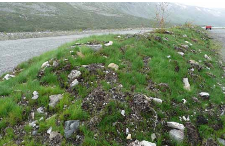
Figur 1. Deler av tipp Breidalen skal tjene som parkeringsplass. For å bryte opp den store parkeringsflaten, ble det lagt opp en vegetasjonkledd ranke midt over plassen. - Part of the heap Breidalen is turned into a parking area. To split the large, homogenous site a dike covered by vegetation is placed across the area. Foto/Photo: A. Hamarsland, august 2009.
