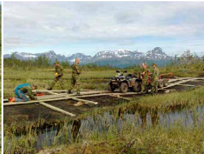
Figur 4. Mannskaper fra Ingeniørbataljonen etablerer permanent kjøreløype i Mauken. Military personell establish a permanent vehicle path in Mauken. Foto/Photo: A. Hamnes.
