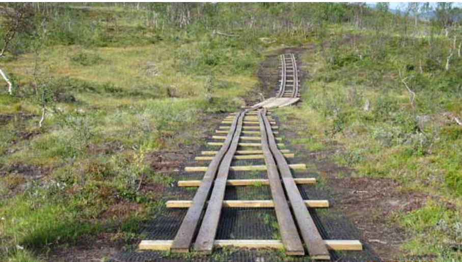
Figur 3. Ferdig permanent kjøreløype og klopp/bru over bekk. - Completed permanent path crossing a small stream. Foto/Photo: A. Hamnes.
