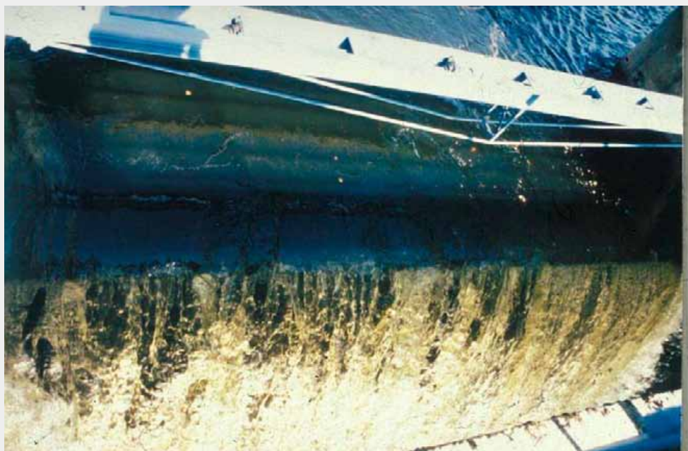
Figur 1. Tapping av overflatevann, ikke bunnvann via segmentluker, er en forutsetning for å sikre nedvandring av fisk forbi kraftverksdemninger (to ørret som slipper seg ned er vist med hvit pil). - Surface spillwater release is necessary to secure downstream passage of hydroelectric dams.
