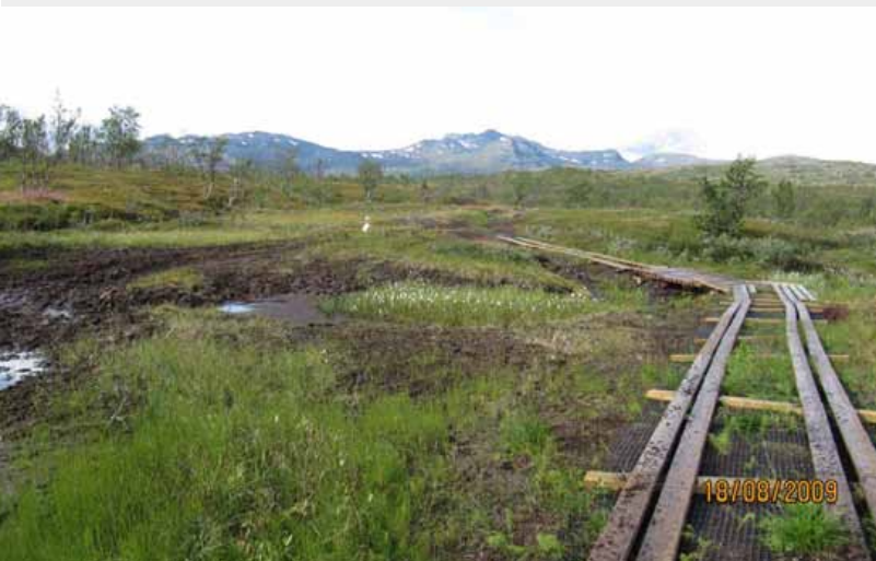
Figur 1. Permanent kjøreløype med geonett og kjørebane etablert over restaurert terrengløype. - Permanent track with geonett and path established in a restored vehicle track. Foto/Photo: A. Hamnes.
