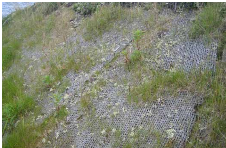
Figur 5. Spontan etablering av lav på kokosmatter brukt for å hindre erosjon. Geitrams og andre ugressarter spirer fra tilført jord under nettet. - Lichen fragments established spontaneously on coco-nets used for erosion control. Chamerion angustifolium and other weeds germinated from imported soils under the net. Foto/Photo: P. A. Pedersen.
