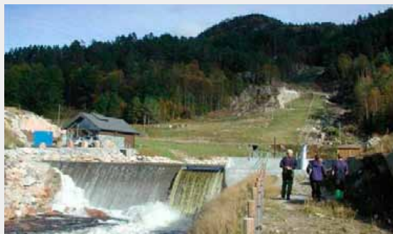
Figur 6. I løpet av de siste årene har det vært en kraftig vekst i utbygging av småkraftverk. Rørgaten blir nedgravd og terrenget formet. Der forholdene ligger til rette for det er målet at naturlig vegetasjon over tid vil etablere seg. Fra Oltedal småkraftverk i Sirdal kommune. - During the last years the interest for small-scale hydropower projects has increased. The pipe is normally buried and the site is landscaped. In most sites natural recovery of vegetation will occur. The picture is from Oltedal power plant in Sirdal. Foto/ Photo: J. A.Eie.
