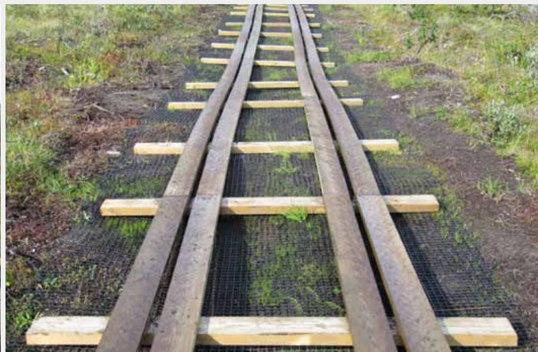
Figur 2. Geonett med kjørebane av trykkimpregnert materiale. - Geonett and path made by impregnated boards. Foto/Photo: A. Hamnes.
