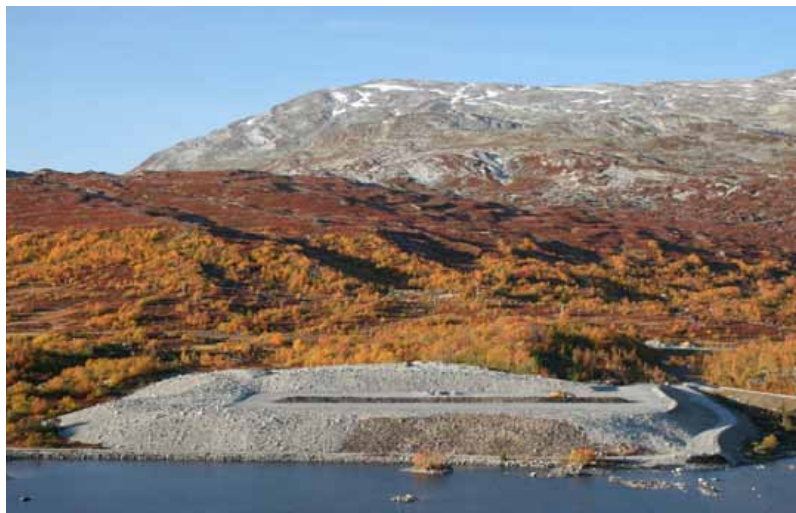
Figur 2. Tipp Breidalen ferdig overflatebehandlet, men før vegetasjonsetablering. - Heap Breidalen completed, however before the revegetation. Foto/Photo: A. Hamarsland, september 2008.
