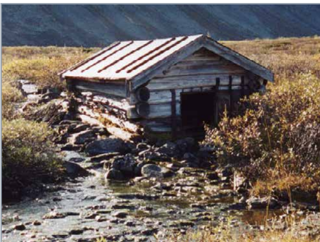
Sløehuset i Ingulssjøbekken hausten 2003, sett ovanfrå. Vatnet vart ført inn i huset der jernplata står. Opningen er 55-60 cm brei og 28 cm høg. Foto: Trygve Hesthagen.
