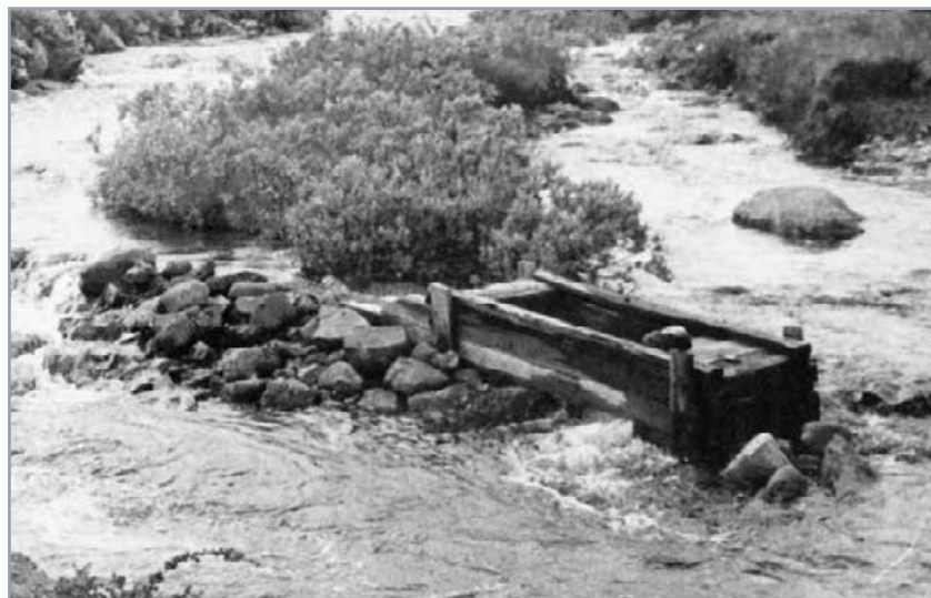
Ei av sløene i Seksisbekken fotografert på 1970-talet. Den eine "greina" av sløegarden er ein holme. Sjå det brusande vatnet som renn ut under sløa. Taket på sløa var den gong delvis borte på grunn av hærverk. Foto: Reidar Bakken. 8
