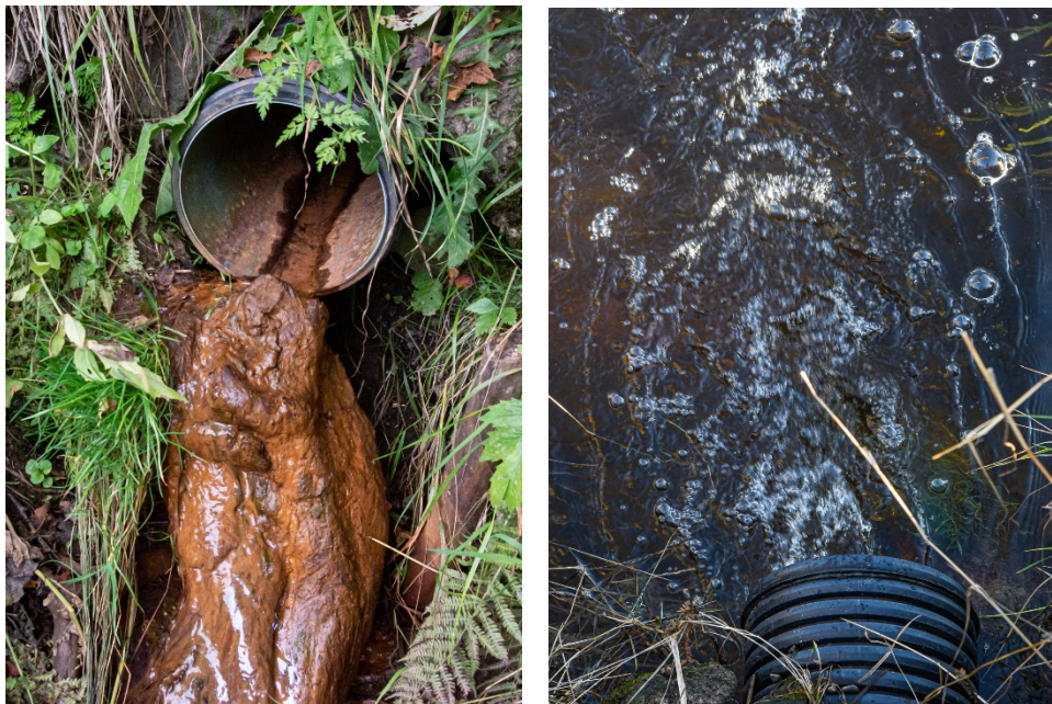
Figur 3.7. Bilde av dreneringsrøret ved utløpet i Leira henholdsvis 13. august (til venstre) og 19. november (til høyre). Den brune fargen på bilde til venstre er jernutfelling.
