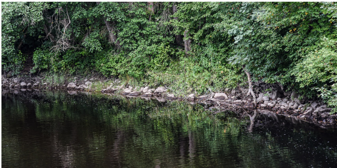
Figur 3.14. Stein som trolig er plastring av Leiras elvekant ovenfor Breen bru.
