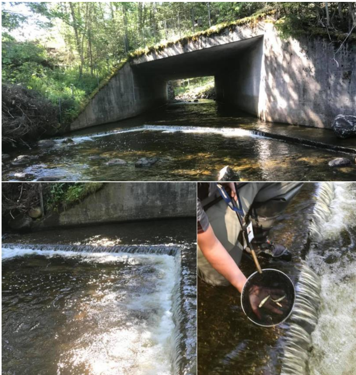
Foto 2. Veikulvert under Fv 704 i 2020. Ørekyte (bilde nederst til høyre) ble funnet på nærliggende strekninger både ovenfor og nedenfor denne kulverten i 2020. Foto: Trondheim kommune.
