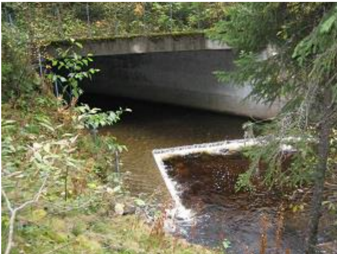
Foto 18. Veikulvert under Fv 704 i 2011. Foto hentet fra Anonym (2012).
