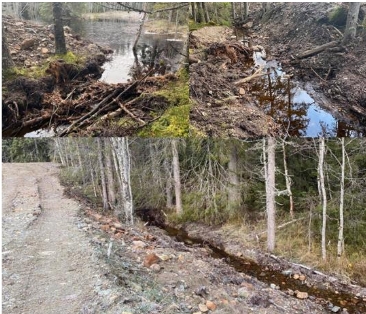
Foto 25. Gjenåpning av tettet sideløp rundt dammen høsten 2020. Foto fra 20 oktober 2020. Foto: NINA.
