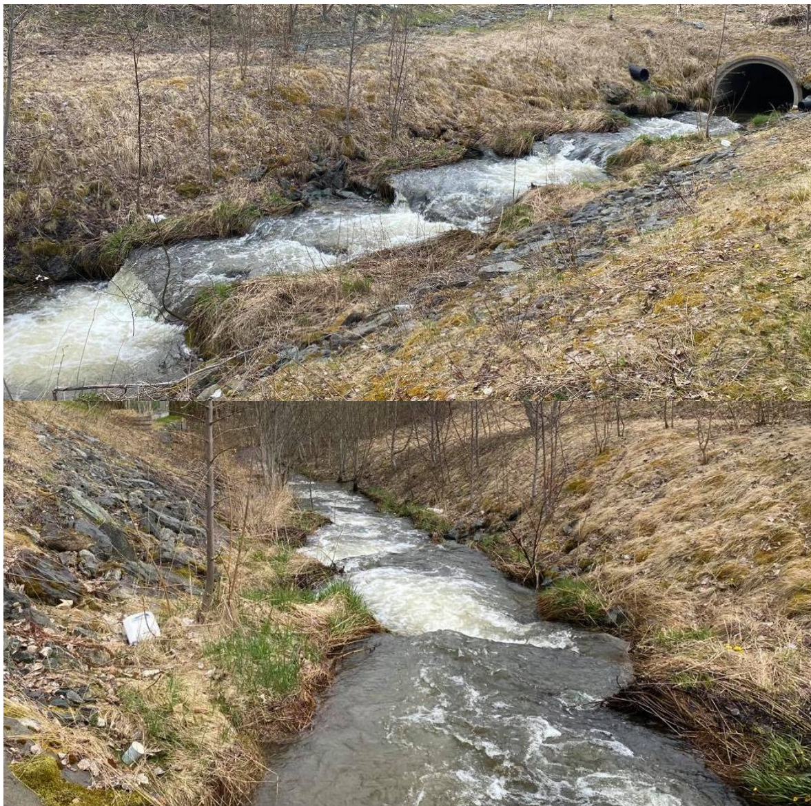
Foto 31. Glissen kantvegetasjon selv mer enn 20 år etter steinsetting skyldes mangel på tilførsel av jordlag i forbindelse med tiltaket. Foto: NINA.
