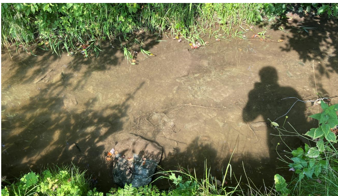
Foto 9. Kulp ovenfor stasjon 3 den 18. august 2020. Synlig nedslammet av jord og sand fra begynnede sikringstiltak på strekningen ovenfor. Strekningen er den samme som avbildet på foto 7 og 8 . Foto: NINA.
