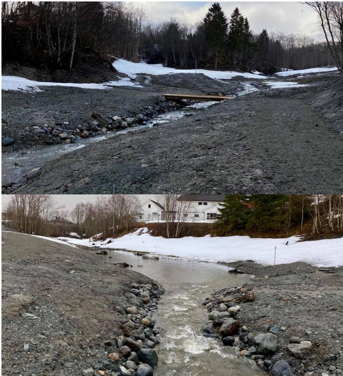
Foto 30. Ved å legge på og klappe fast et jordlag ned til alminnelig vannstand i bekken etter sikringstiltaket, legges til rette for å reetablere en velutviklet kantvegetasjon og -sone langs bekken i tiltaksområdet. Eksempel fra Uglabekken. Foto: NINA.
