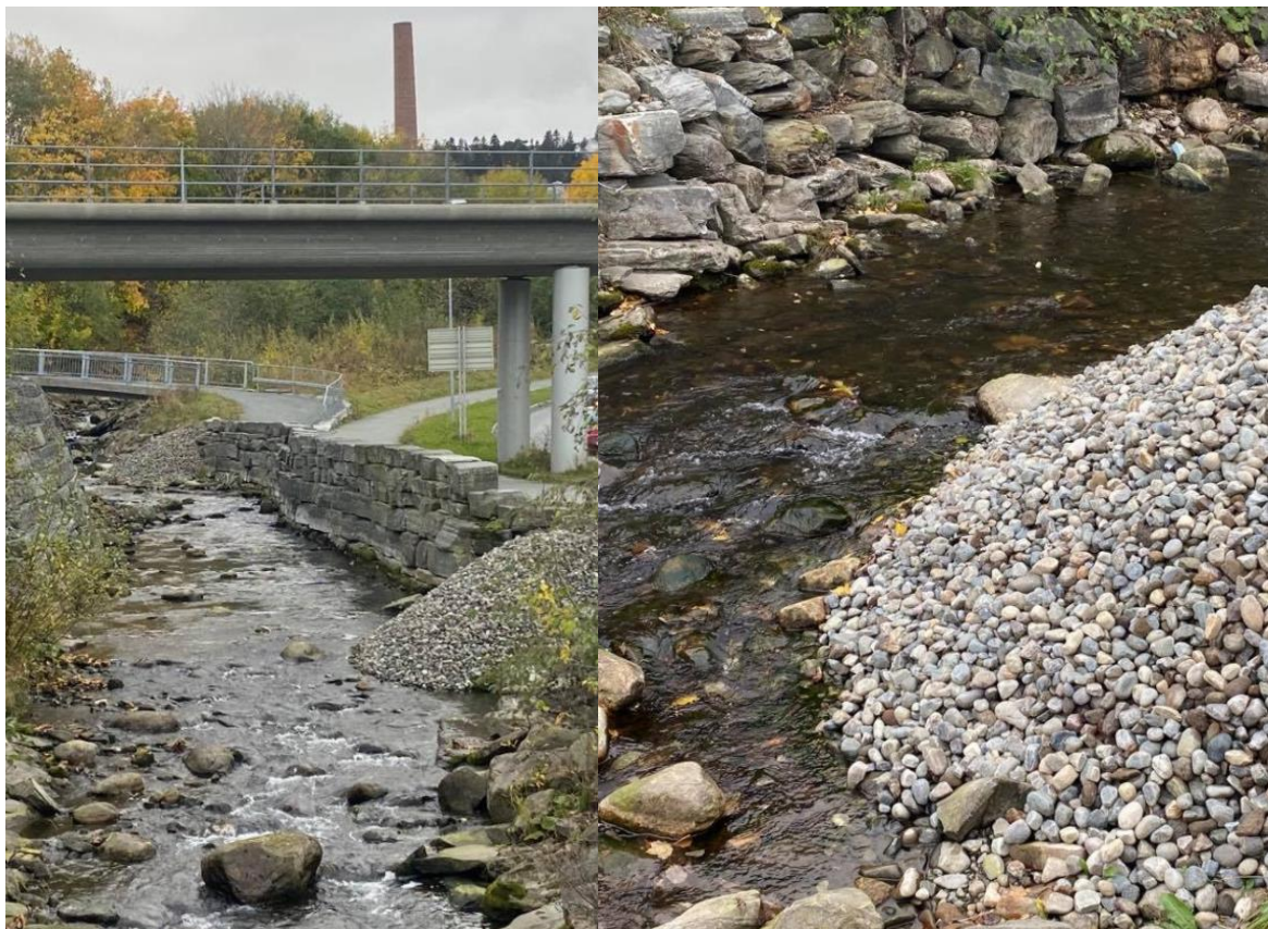
Foto 28. Utlegging av stein- og grushauger som tilfører vassdraget nytt substrat ved flomepisoder og isgang. Foto fra løsninger i Vikelva, Trondheim. Foto: NINA.
