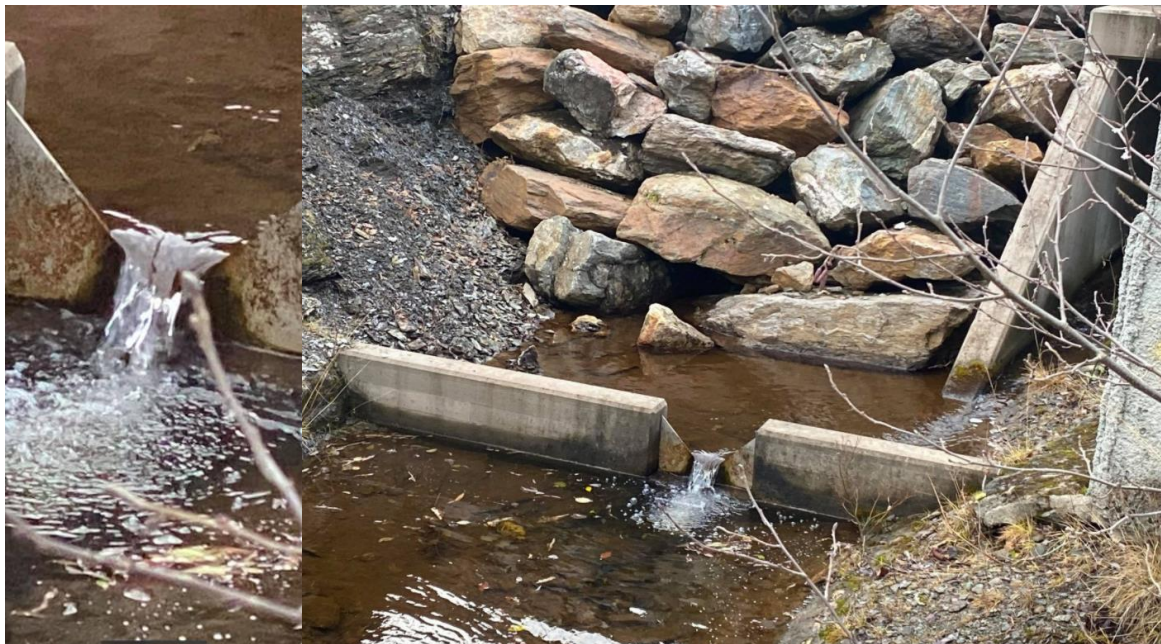
Foto 17. Vannslipp i Hammerbekken nedstrøms demningen ved Nydammen når det ikke er overløp. Foto fra november 2020. Foto NINA.
