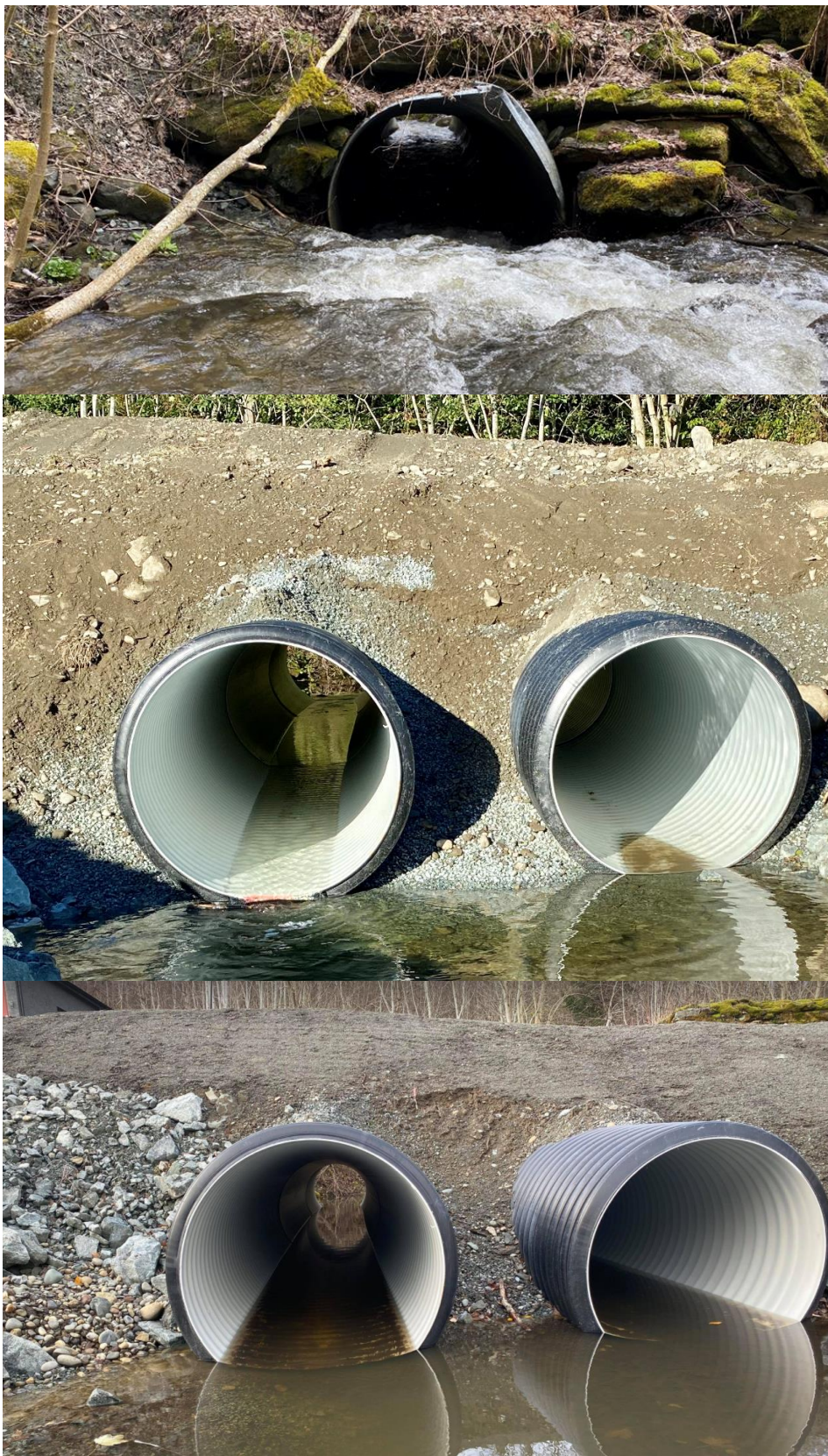
Foto 6. Nye kulverter i Hammerbekken er mer nedsenket og lettere å vandre forbi enn tidligere løsning, før tiltaket. Øverst: Før tiltak. Midten: Foto på svært lav vannføring i Hammerbekken den 1. september 2020. Nederst: Foto på middels vannføring den 5. november 2020. Foto: NINA.
