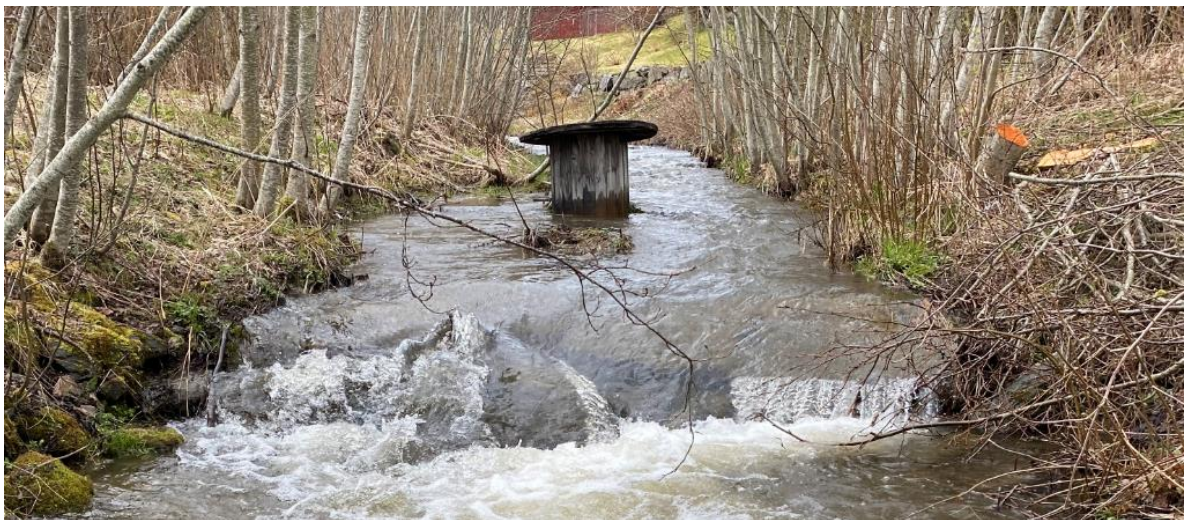
Foto 10. Storstein og blokk lagt i kanaliserte bekkestrekninger opp mot bekkelukking under Snøfuglveien og E39. Foto: NINA.
