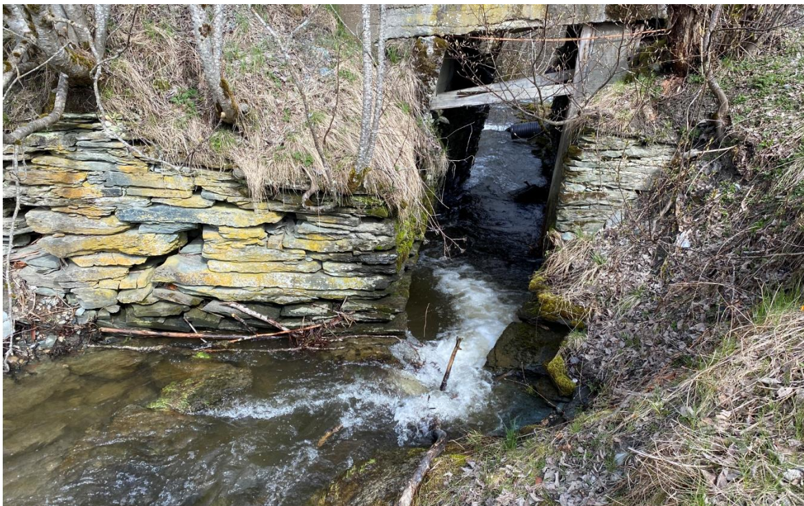
Foto 13. Hammerbekken går i stikkrenne under gammel bru ved avkjøring til Hammerdalen 23-27. Foto: NINA.
