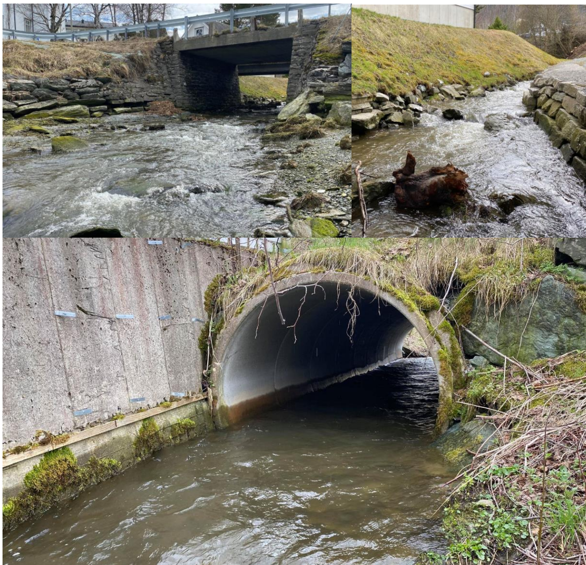
Foto 2. Stasjonsområde 1 strekker seg fra flomål nedstrøms Buvikvegen (øverst til venstre), gjennom boligområder (øverst til høyre) og opp til privatveikrysning (nederst), en bekkestrekning på omlag 115 meter. Foto: NINA.
